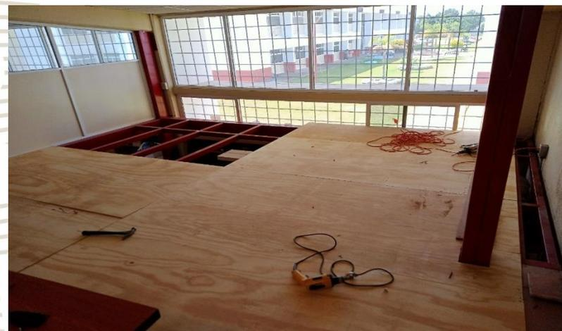
APLICACIÓN DE PINTURA EN FACHADAS DE SALA DE ESPERA, RETIRO DE ENTREPISO DE TRIPLAY EN MAL ESTADO DEL TAPANCO DE LABORATORIO DE MAQUINAS, HERRAMIENTAS, CNC. Y LABORATORIO DE NEGOCIOS INTELIGENTES EDIFICIO LT-2.
