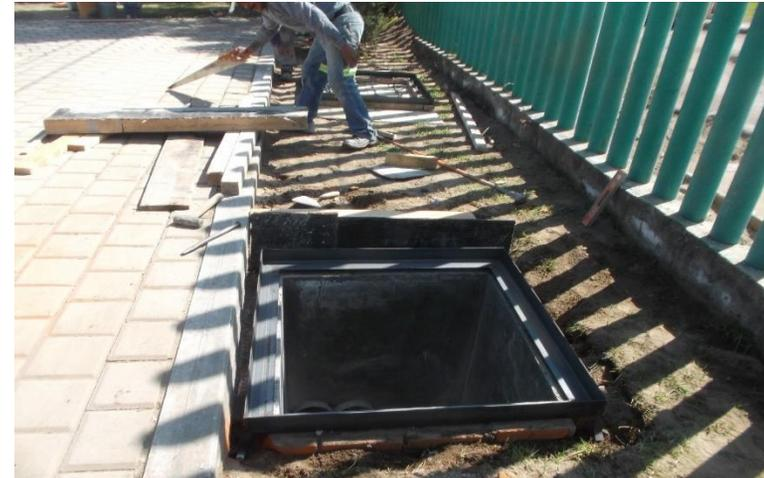
**OBRA EXTERIOR: CIMBRADO Y COLADO CON CONCRETO F' C=200KG/CM2 EN PAREDES Y FIRME DE LA ALCANTERILLA PLUVIAL**
