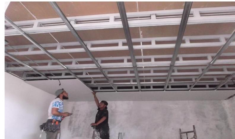
**CONSTRUCCION DE ARMADURA PARA COLOCACION DE PLAFON A BASE DE PERFILES PTR DE 2" PARA RECIBIR PLAFOND E INSTALACIONES ELECTRICAS EN CUBICULO DEL EQUIPO DE MEDICION POR COORDENADAS LABORATORIO METROLOGIA EDIF.LT-3 CUERPO "B"**
