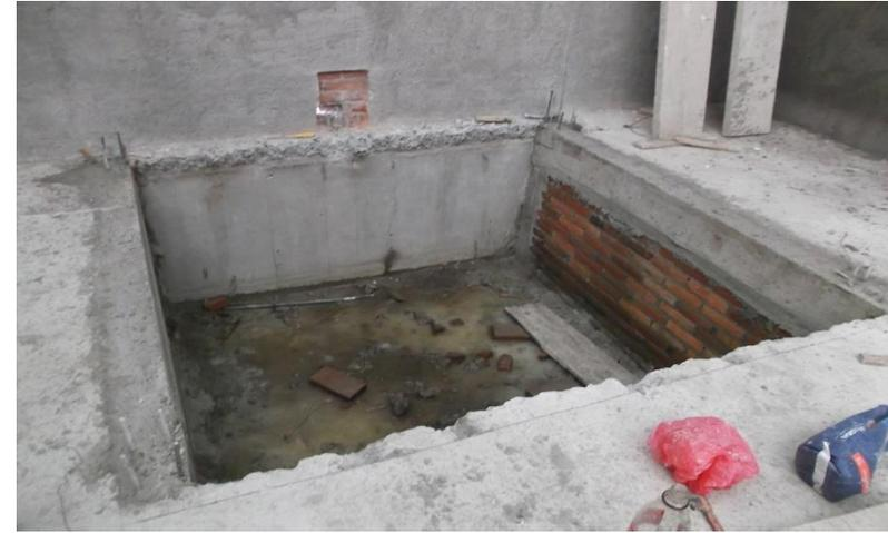
**DEMOLICION DE LOSA PARA CONSTRUCCION DE CIMENTACION Y CUBICULO ESPECIAL PARA INSTALAR EQUIPO DE MEDICION POR COORDENADAS LABORATORIO DE METROLOGIA EDIF.LT-3 CUERPO "B"**
