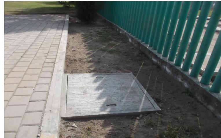
**OBRA EXTERIOR: SUMINISTRO Y COLOCACION DE REJILLA IRVING Y TAPA PARA CONEXION A LA ALCANTARILLA PLUVIAL**
