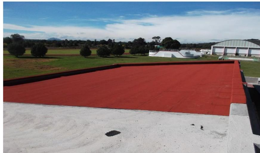
APLANADO Y COLOCACION DE MEMBRANA IMPERMEABILIZANTE EN AZOTEA EJES A' -C' / 9-18 EDIF. LT-3 CUERPO "B"
