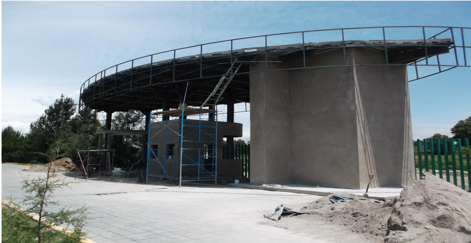
OBRA EXTERIOR: APLANADOS EN MURDS INTERIORES Y EXTERIORES CON MORTERO CEMENTO-ARENA PROPORCION 1:5 (ACCESO NORTE)
