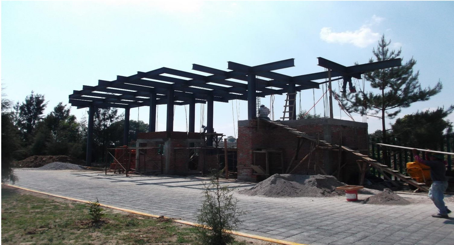
OBRA EXTERIOR: SUMINISTRO Y COLOCACION DE ESTRUCTURA METALICA EN LOSA DE AZOTEA (ACCESO NORTE)
