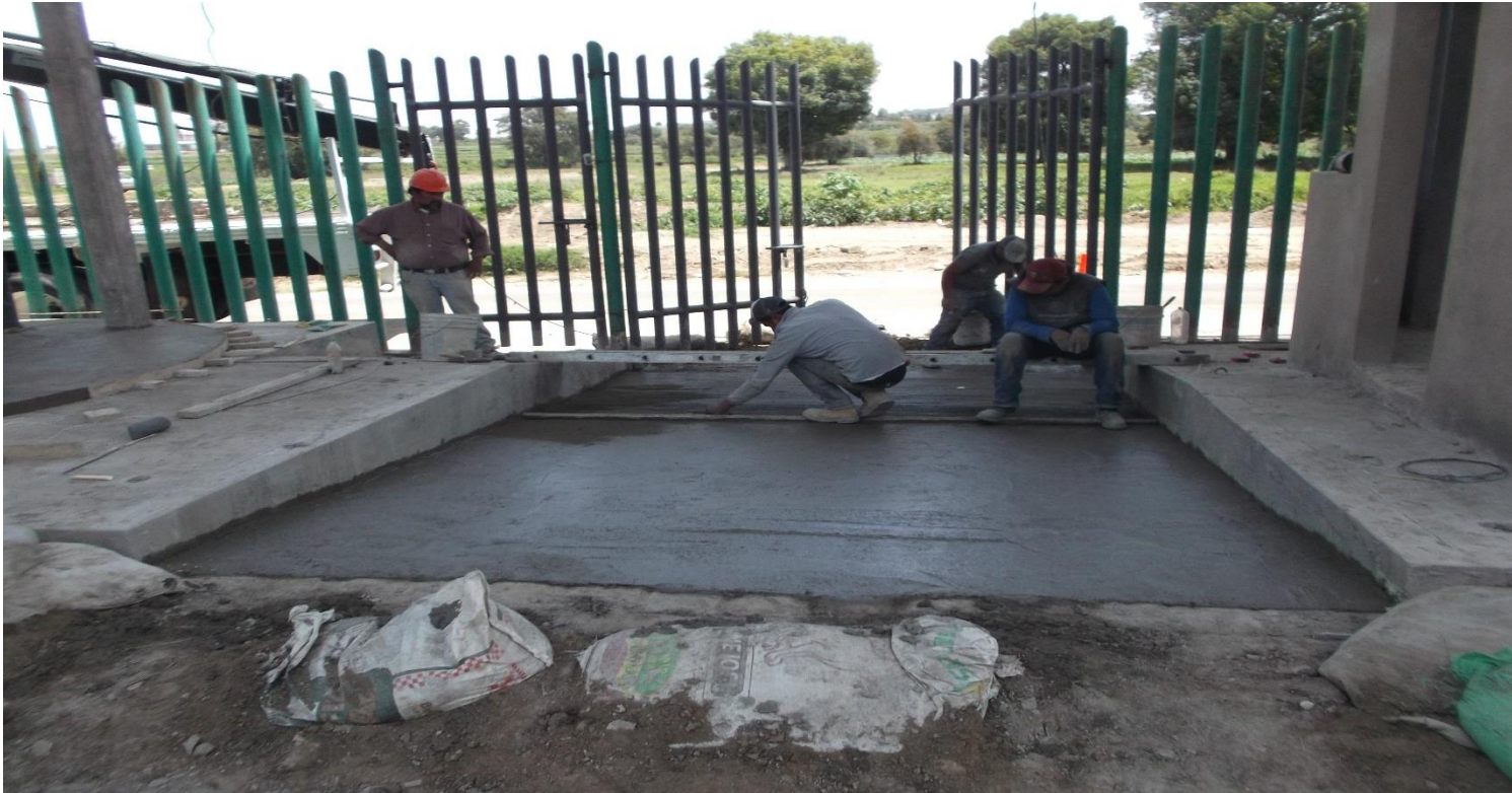
OBRA EXTERIOR: EN PROCESO, CONSTRUCCION DE RAMPAS VEHICULARES Y BANQUETAS A BASE DE CONCRETO F' C= 150 KG/CM2 HECHO EN OBRA (ACCESO NORTE)
