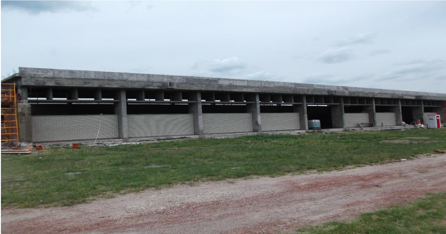
CONSTRUCCION DE MUROS APARENTES ACABADO ESMALTADO EN FACHADA ORIENTE
