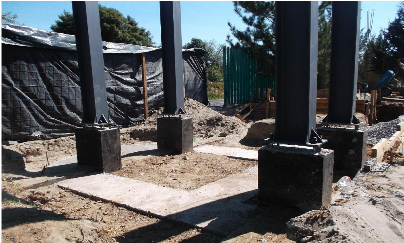
OBRA EXTERIOR: RELLENO CON MATERIAL INERTE Y SUMUNISTRO, HABILITADO Y COLOCADO DE COLUMNAS METALICAS (ACCESO NORTE)
