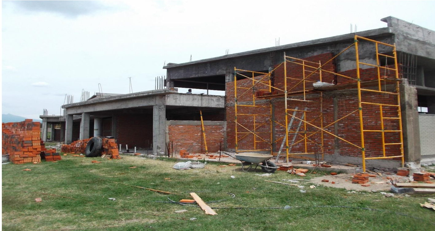
CONSTRUCCION DE CADENAS Y CASTILLOS DE CONCRETO Y MUROS DE TABIQUE ROJO COMUN EN FACHADA NORTE
