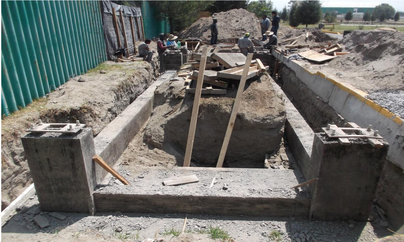
OBRA EXTERIOR: DESCIMBRADO DE ELEMENTOS DE CIMENTACION, ZAPATAS, CONTRATRABES Y DADOS (ACCESO NORTE)
