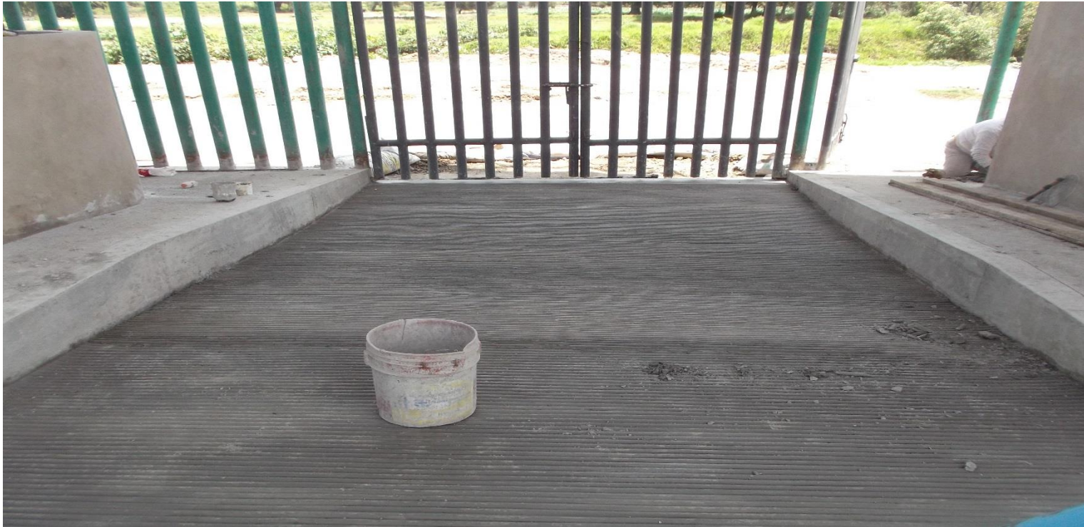
OBRA EXTERIOR: CONSTRUCCION DE RAMPAS VEHICULARES Y BANQUETAS A BASE DE CONCRETO F' C= 150 KG/CM2 HECHO EN OBRA (ACCESO NORTE)
