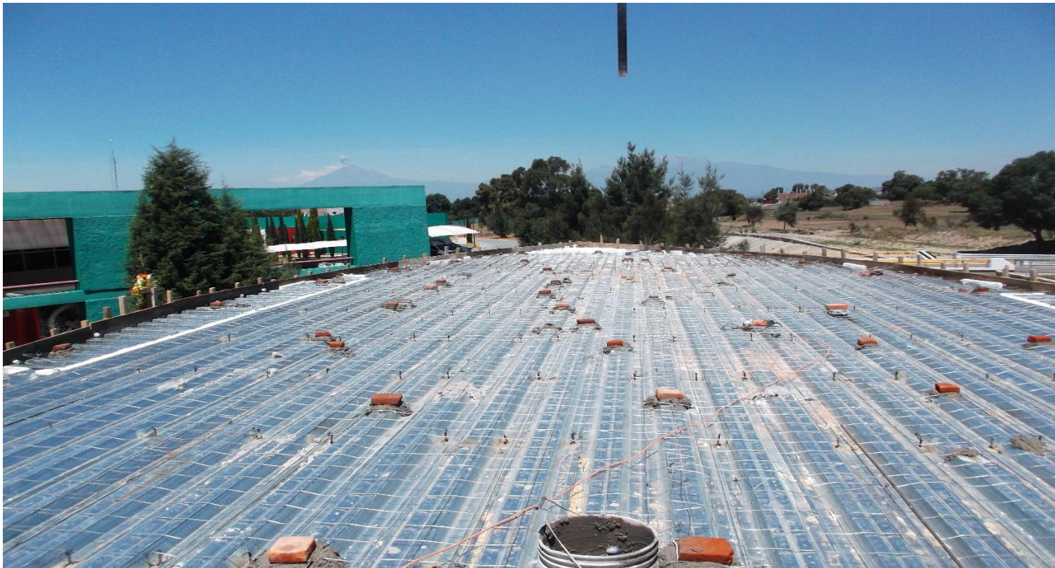
OBRA EXTERIOR: SUMINISTRO Y COLOCACION DE LOSA-ACERO Y MALLA ELECTROSOLDADA 6-6/10X10 EN LOSA DE AZOTEA (ACCESO NORTE)
