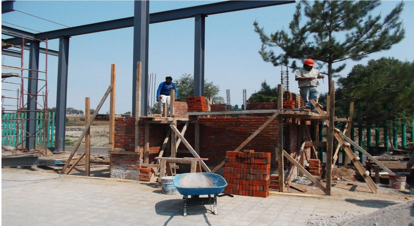
OBRA EXTERIOR: DESPLANTE DE MUROS DE TABIQUE ROJO COMUN PARA ZONA DE DESCANSO DE VIGILANCIA (ACCESO NORTE)
