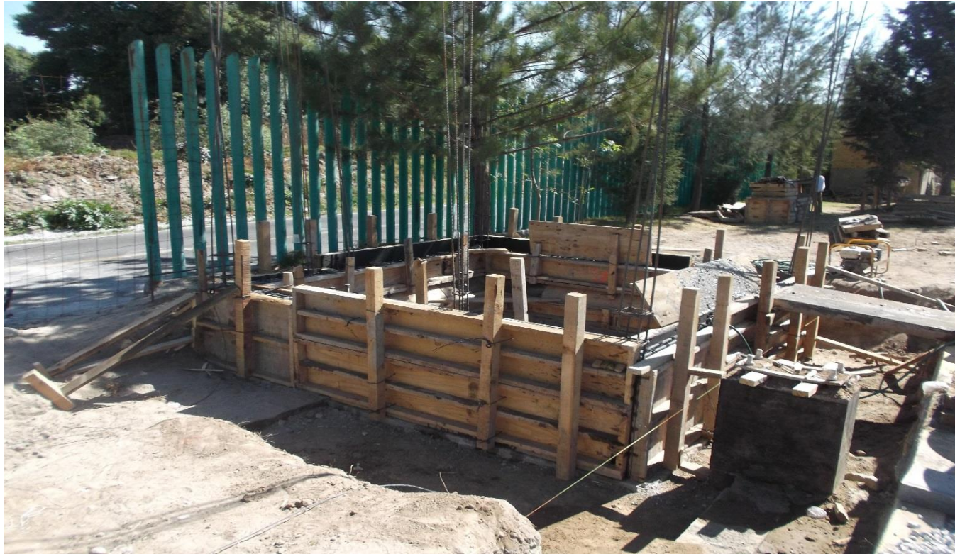
OBRA EXTERIOR: CIMBRADO Y COLADO DE ZAPATA SECUNDARIA Z-4 (ACCESO NORTE)
