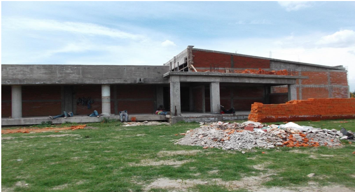
CONSTRUCCION DE CADENAS Y CASTILLOS DE CONCRETO Y MUROS DE TABIQUE ROJO COMUN EN FACHADA SUR
