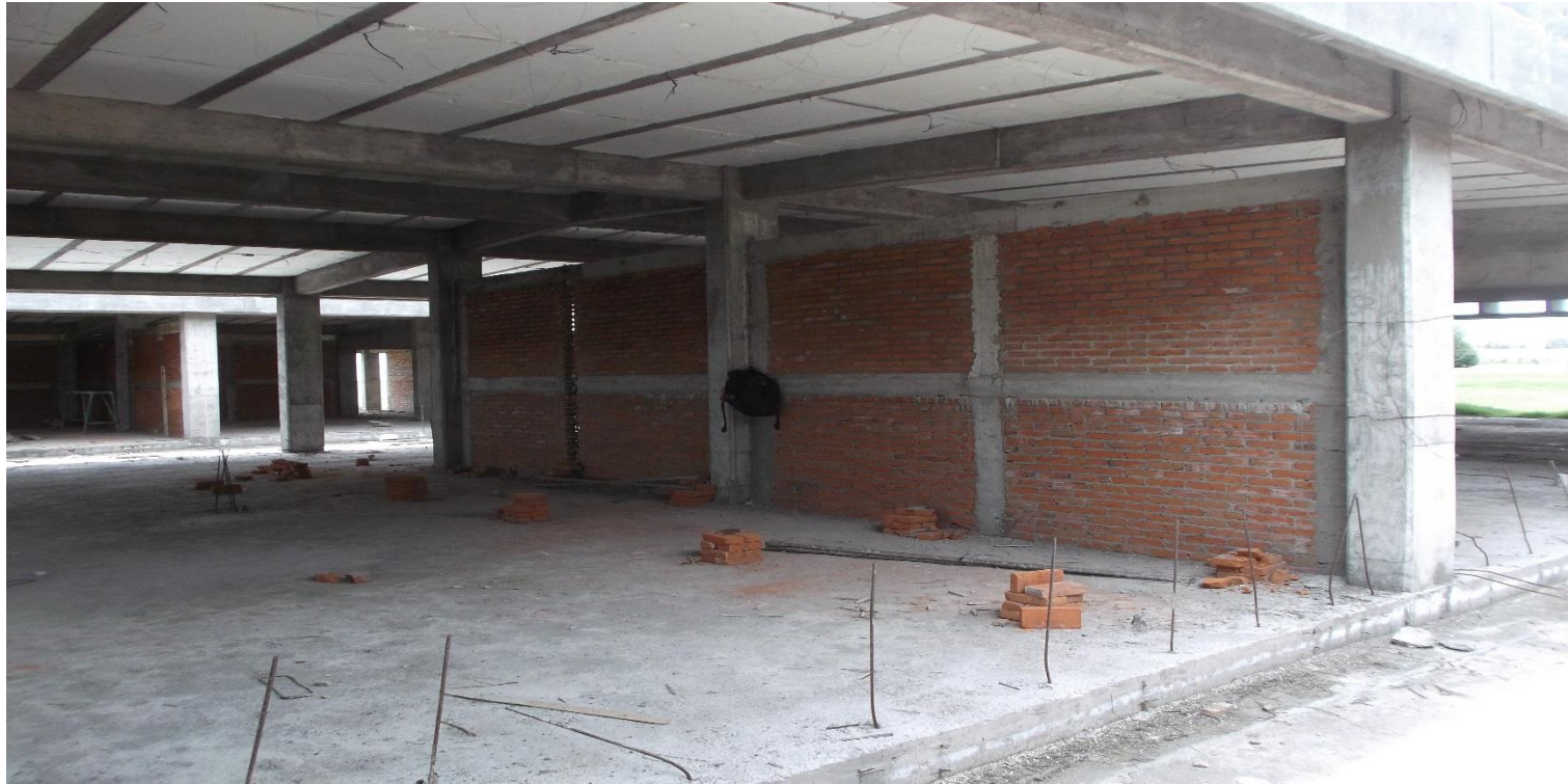
CONSTRUCCION DE CADENAS Y CASTILLOS DE CONCRETO Y MUROS DE TABIQUE ROJO COMUN INTERIORES
