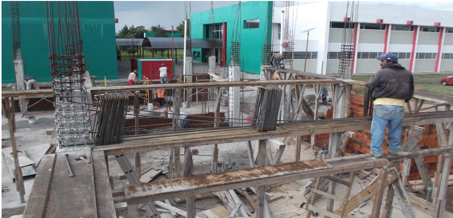
CIMBRA DE FONDO EN TRABES DE ENTRIPISO.
