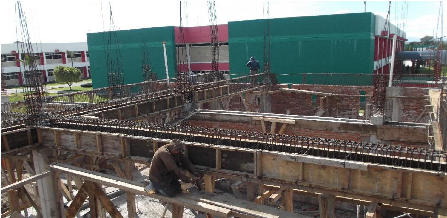
ARMADO Y CIMBRADO DE COSTADOS EN TRABES DE LOSA DE ENTREPISO.
