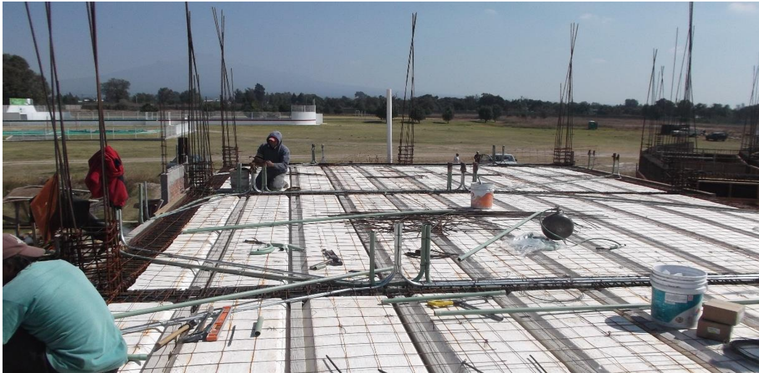
COLOCACION DE INSTALACIONES ELECTRICAS Y VOZ Y DATOS EN LOSA DE ENTREPISO.
