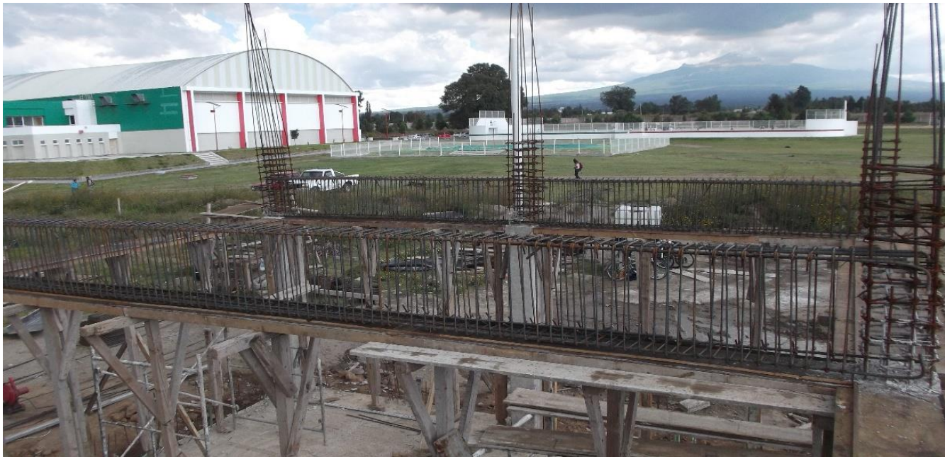
CIMBRA DE FONDO Y COLOCACION DE ACERO DE REFUERZO EN TRABES DE ENTREPISO
