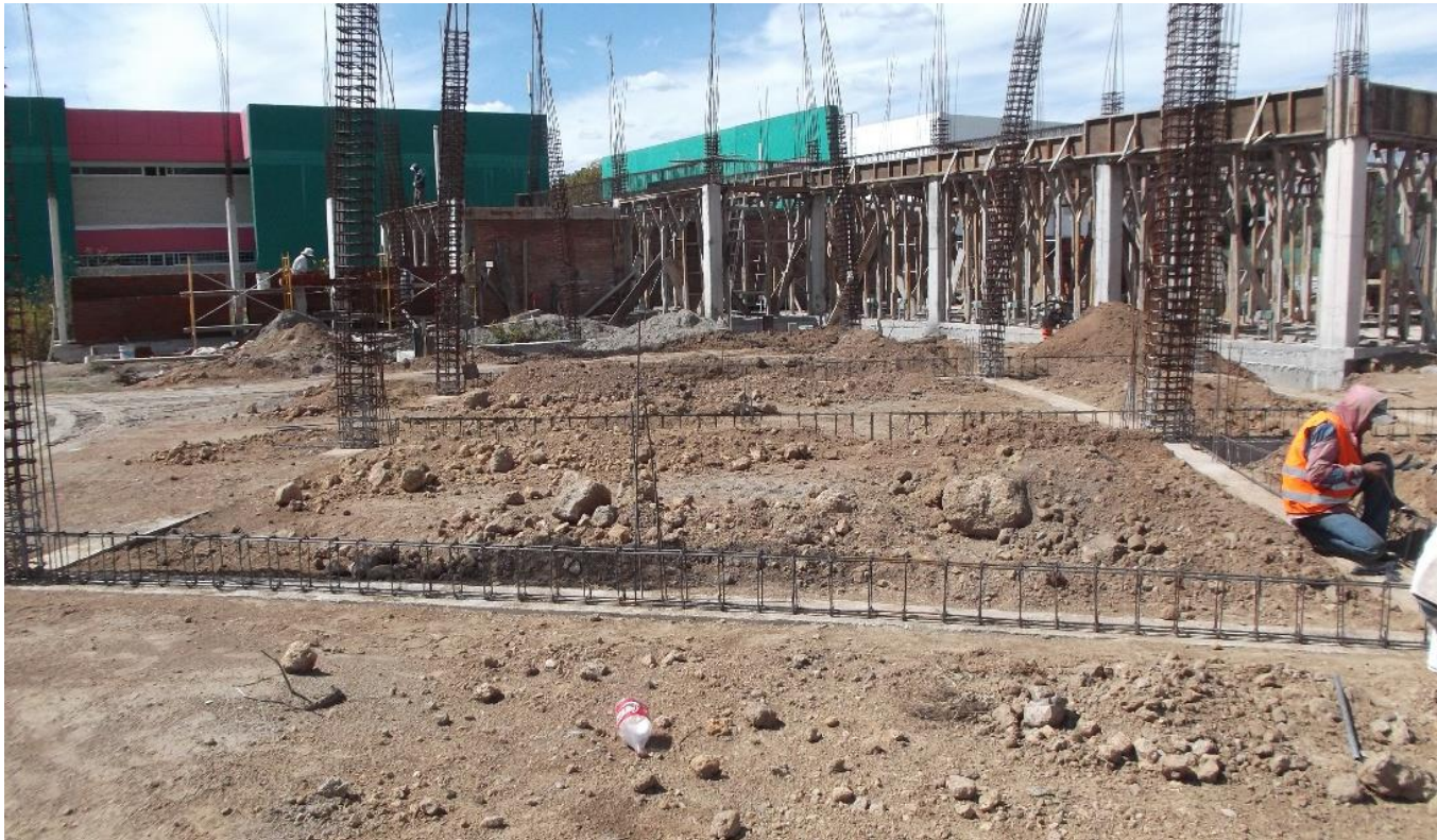
ARMADO DE CADENAS DE DESPLANTE EN CIMENTACION.
