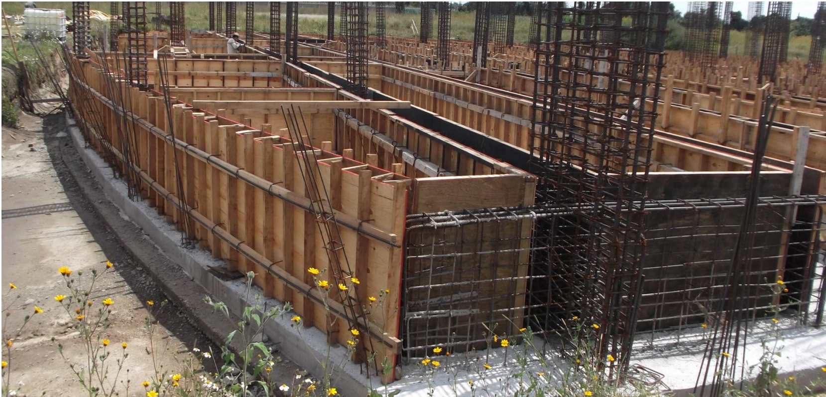
CIMBRA EN CONTRA TRABES PARA RECIBIR VACIADO DE CONCRETO.
