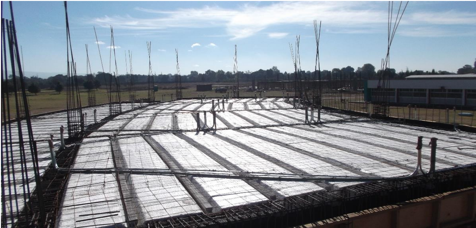
ARMADO DE TRABES, COLOCACION DE VIGUETAS, CACETONES Y MALLA ELECTROSOLDADA EN LOSA DE ENTREPISO.
