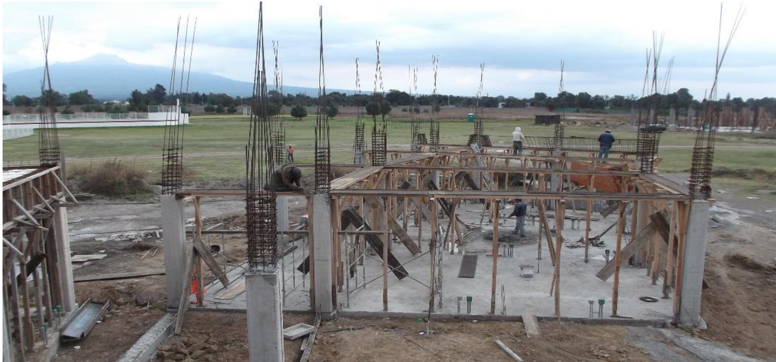
CIMBRADO DE FONDOS Y COLADO DE FIRMES EN PLANTA BAJA.
