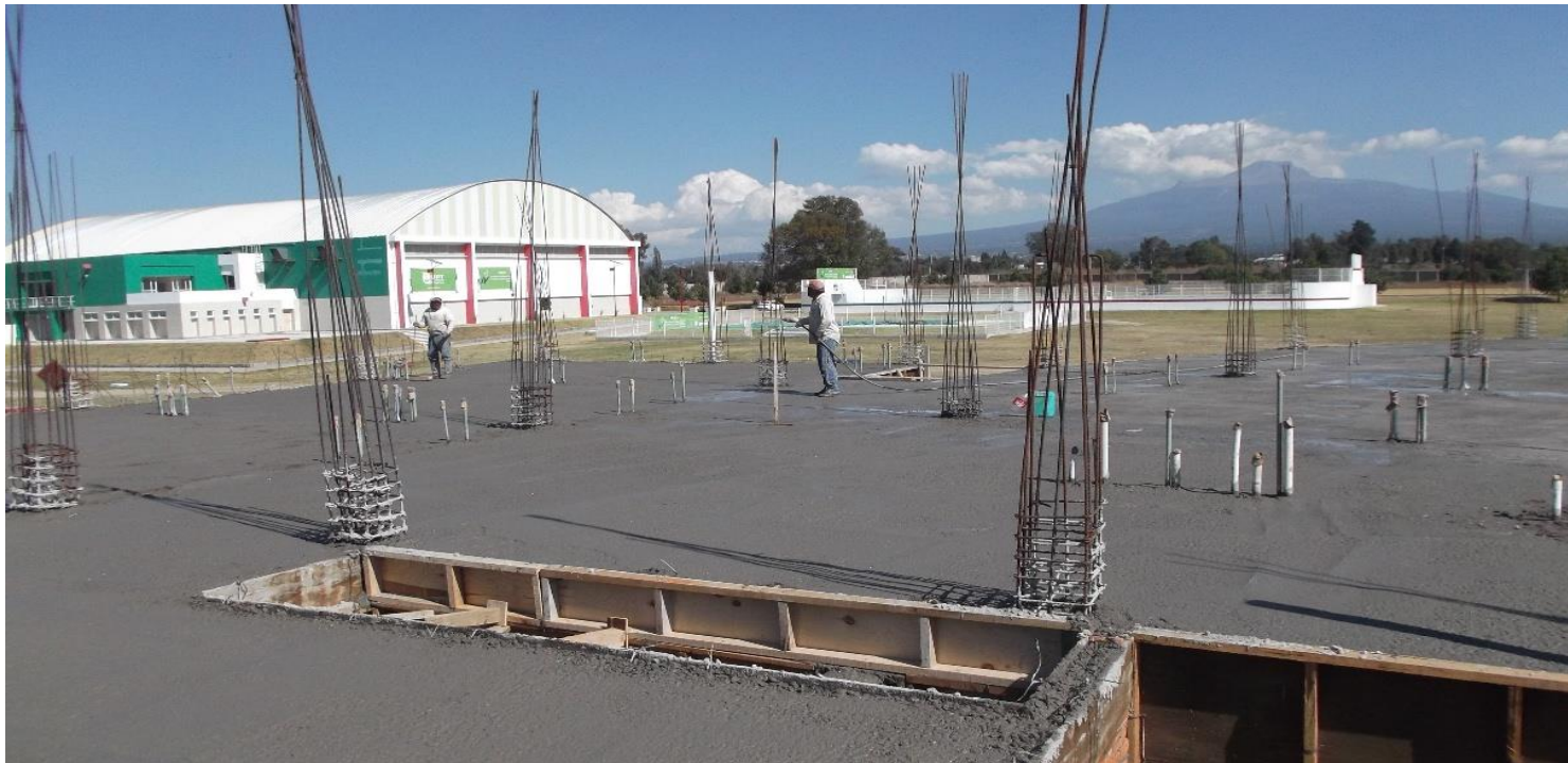
COLADO DE LOSA DE ENTREPISO. CONCRETO F´C=250 KG/CM2, PREMEZCLADO Y BOMBEADO.
