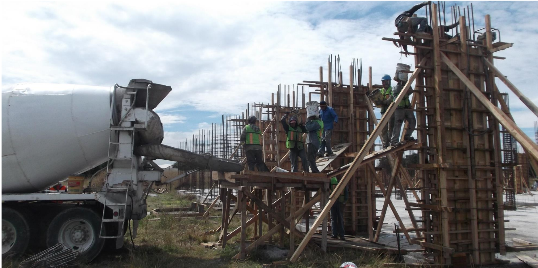
CIMBRADO Y VACIADO DE CONCRETO PREMEZCLADO EN COLUMNAS.
