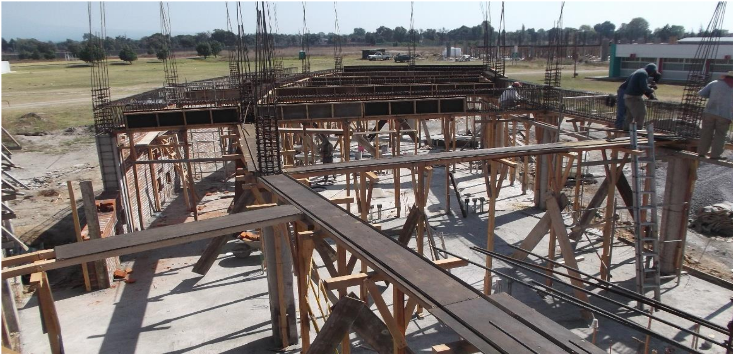
CIMBRADO Y ARMADO CO ACERO DE REFUERZO EN LOSA DE ENTREPISO.
