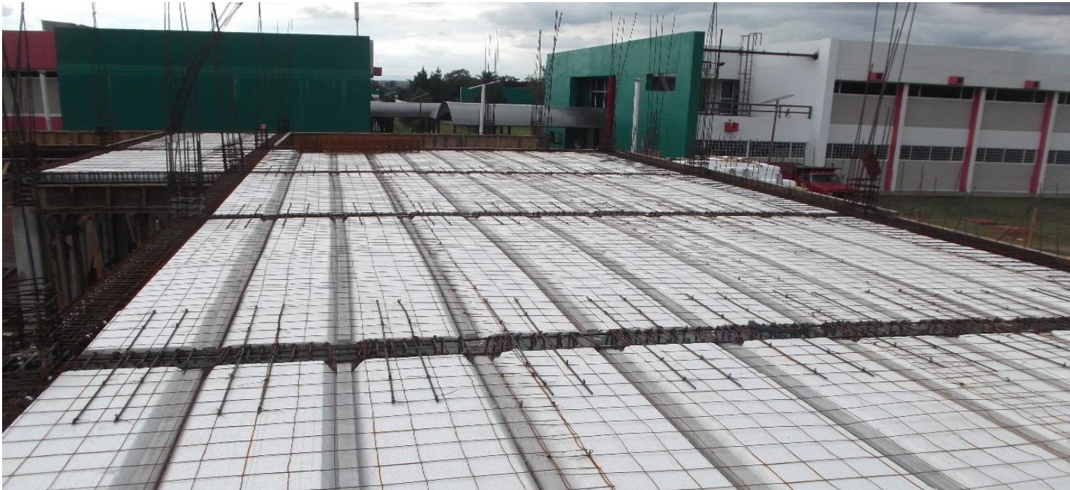
COLOCACION DE VIGUETAS Y CASETONES EN LOSA DE ENTREPISO.
