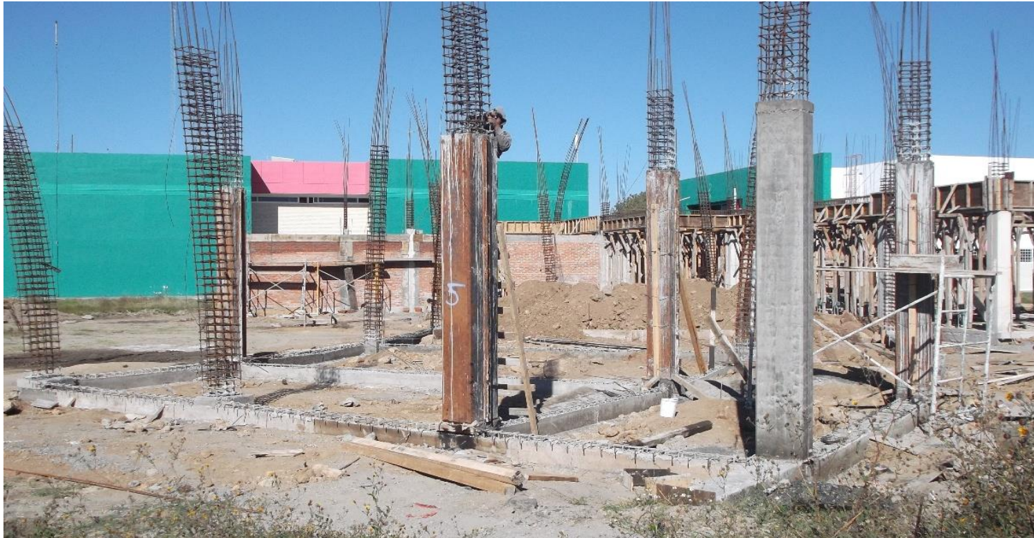
CIMBRADO Y COLADO DE COLUMNAS PLANTA BAJA.
