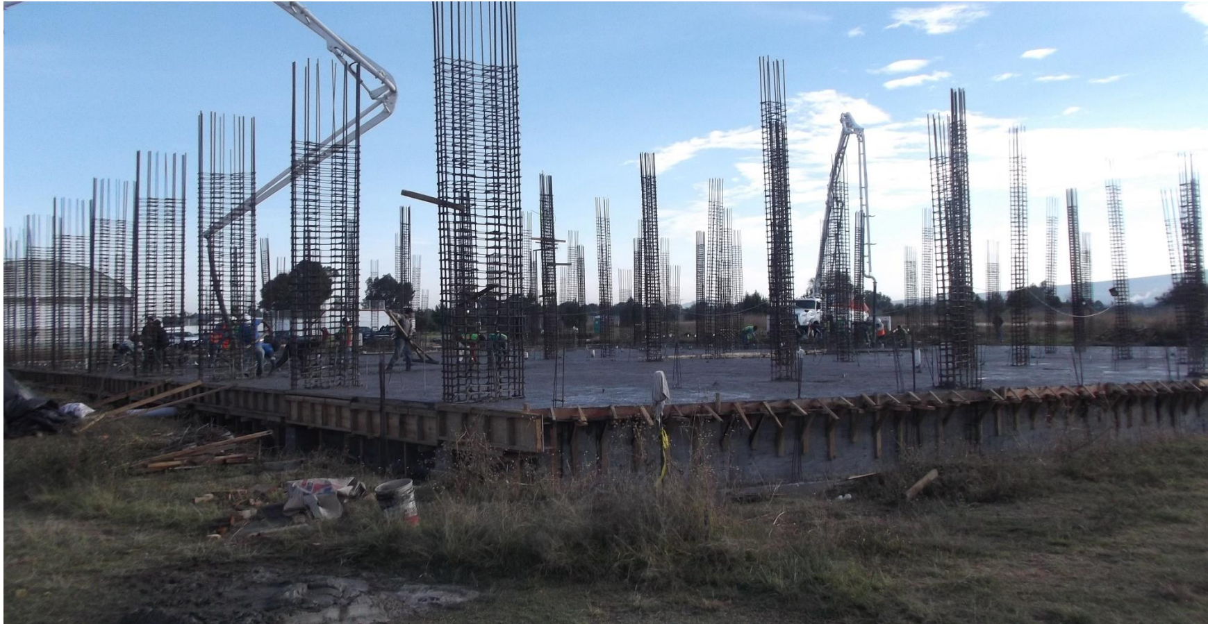
VACIADO DE CONCRETO PREMEZCLADO EN LOSA TAPA F'c = 250 \text{ KG/CM}^2
