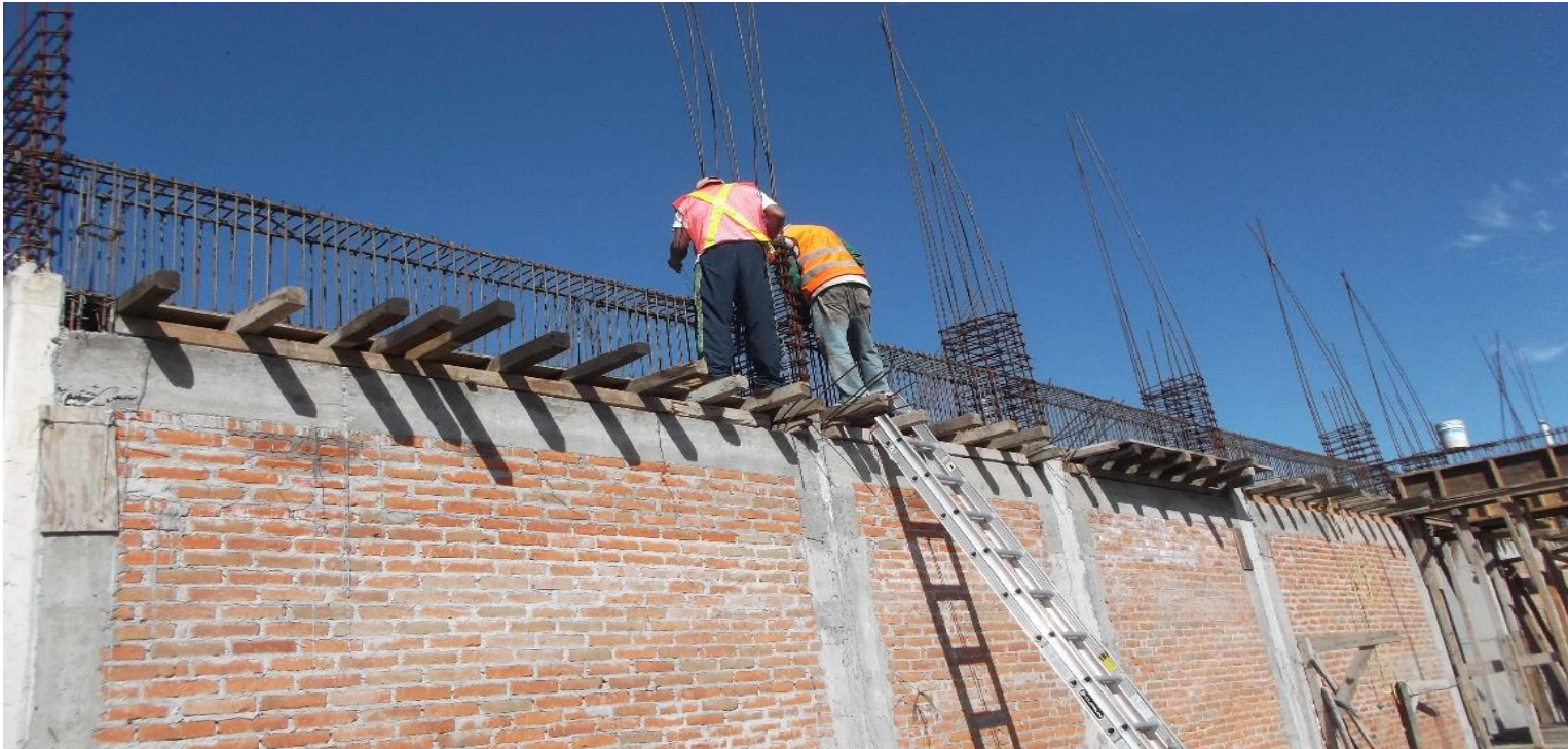
COLOCACION DE ACERO DE REFUERZO EN TRABES DE LOSA DE ENTREPISO.
