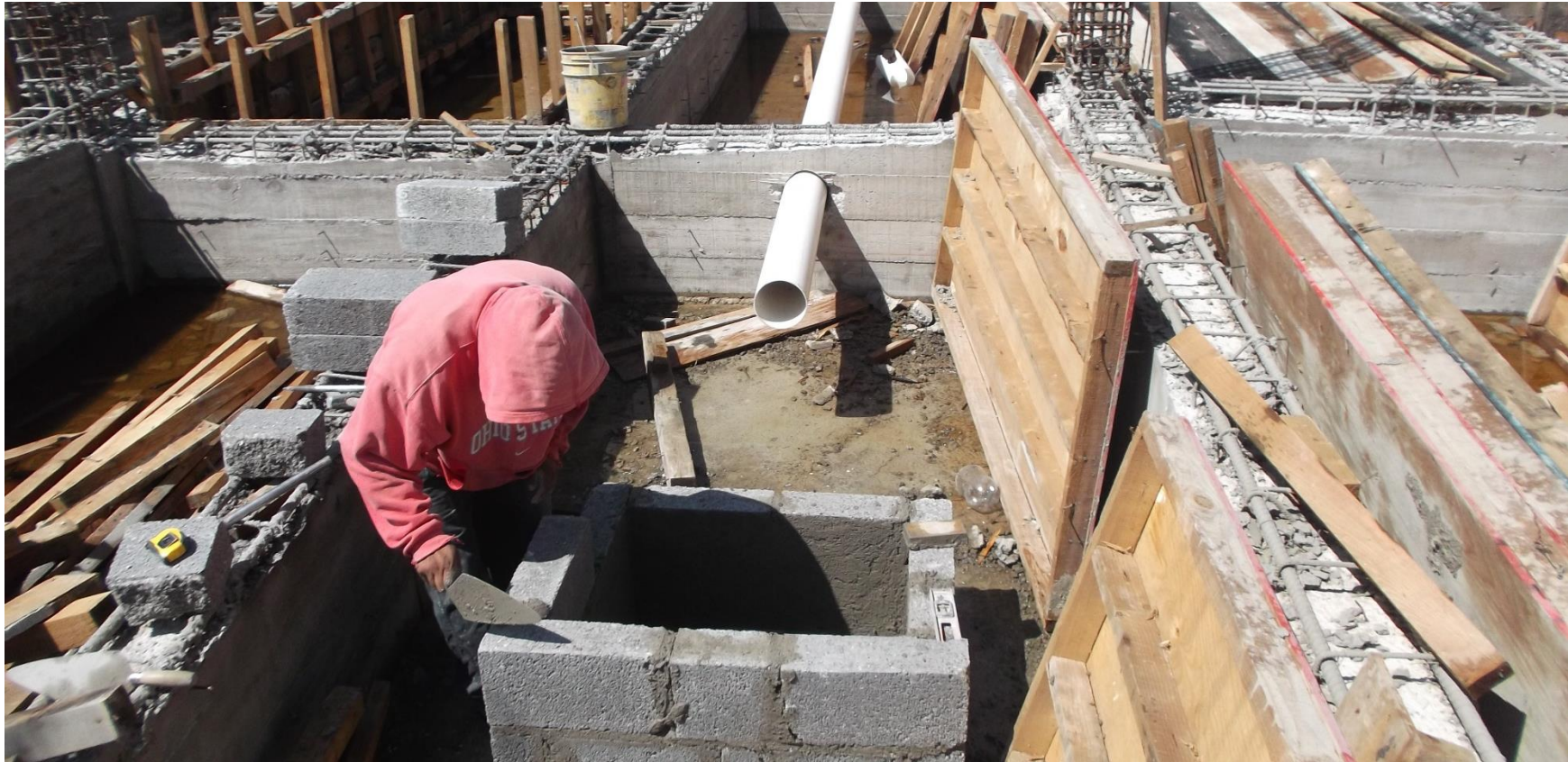
DESCIMBRADO EN CONTRA TRABES Y PREPARACIÓN DE REGISTROS PARA ALOJAR INSTALACIONES SANITARIAS.
