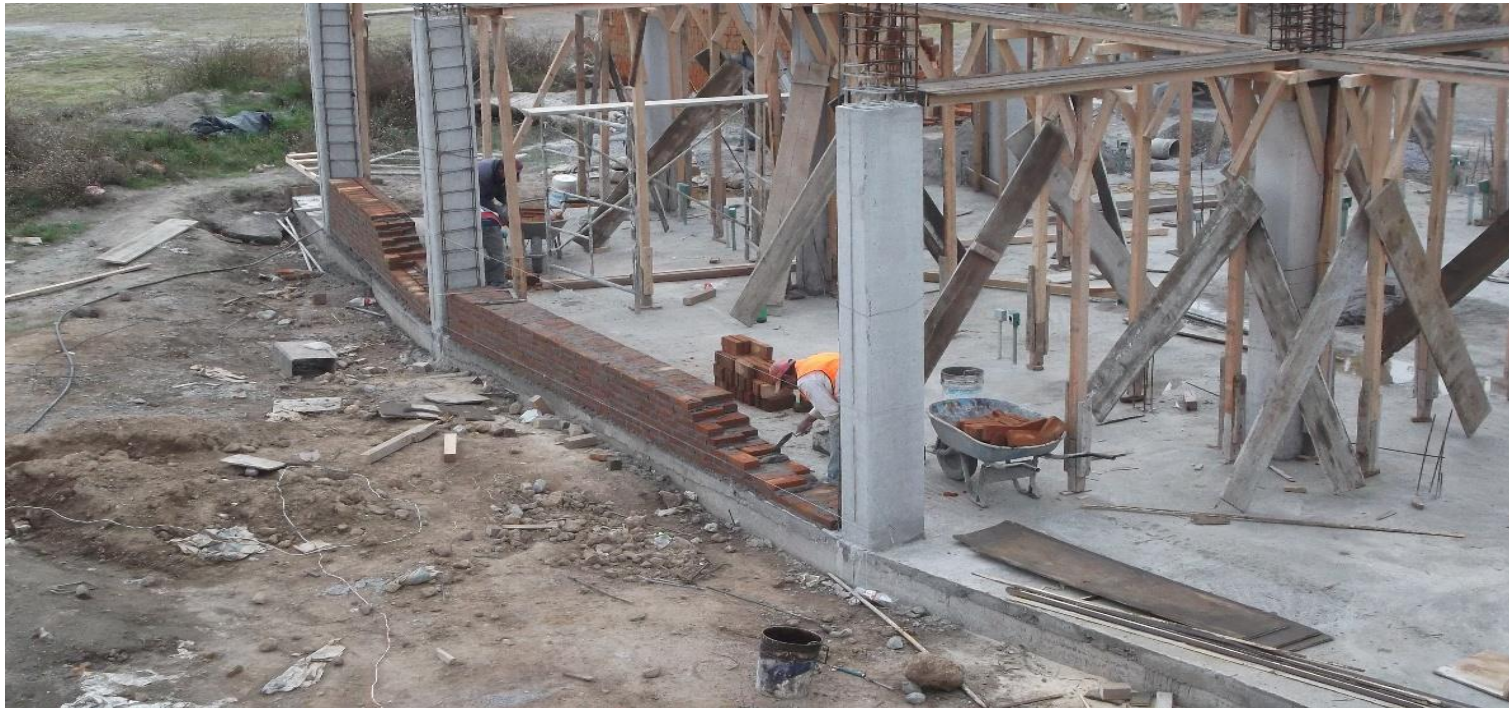
DESPLANTE DE MUROS DE TABIQUE EN PLANTA BAJA.
