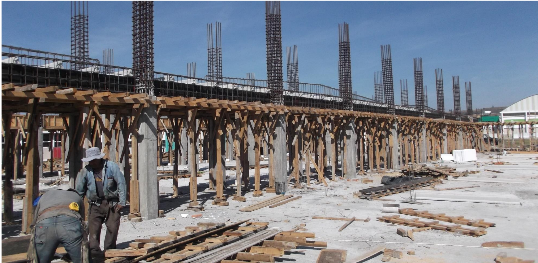
CIMBRA EN TRABES, HABILITADO DE ACERO, Y COLOCACIÓN DE VIGUETAS PARA COLAR LOSA.
