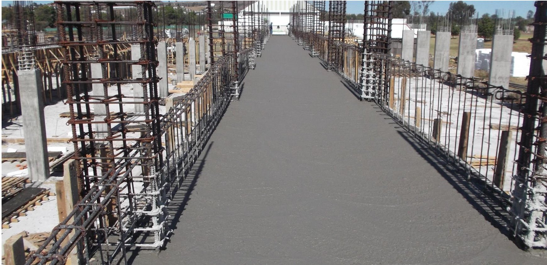
VACIADO DE CONCRETO PREMEZCLADO EN LOSA DE PASILLO.
