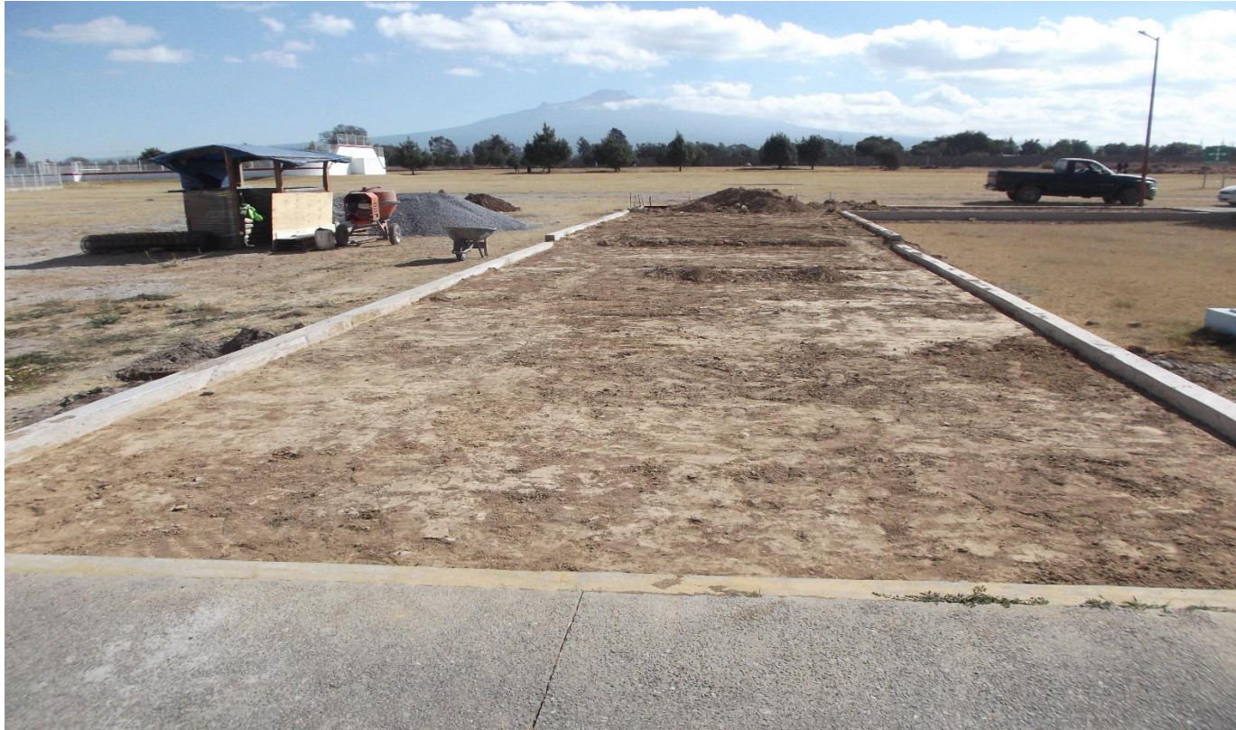
OBRA EXTERIOR: RELLENOS COMPACTADOS Y CONSTRUCCIÓN DE GUARNICIONES DE CONCRETO PARA LA CONTINUACIÓN DEL ANDADOR PRINCIPAL
