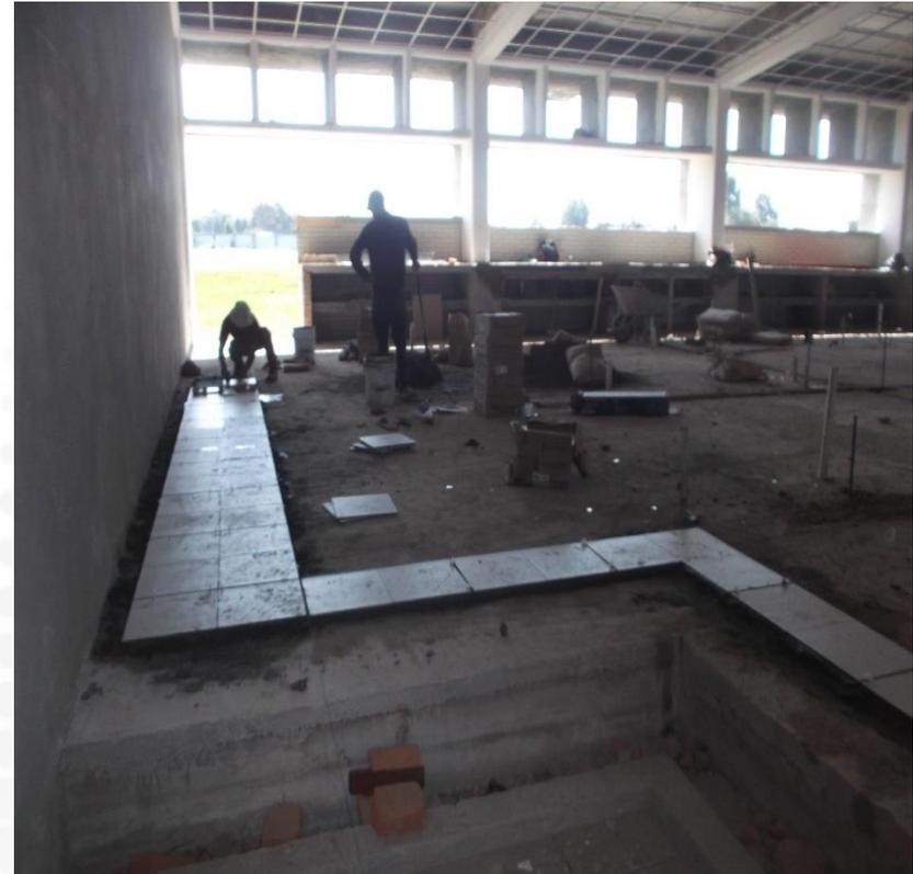
**RELLENO COMPACTADO CON MATERIAL INERTE EN LABORATORIO DE INFRARROJO “IR” PARA ALBERGAR INSTALACIONES, COLOCACION DE LOSETA DE CERAMICA INTERCERAMIC EN PISOS INTERIOS**
