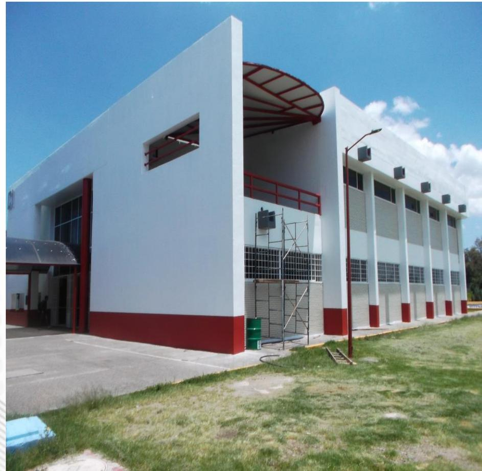
**OBRA EXTERIOR: SUMINISTRO Y APLICACIÓN DE PINTURA VINILICA EN FACHADA DEL EDIFICIO BIBLIOTECA**
