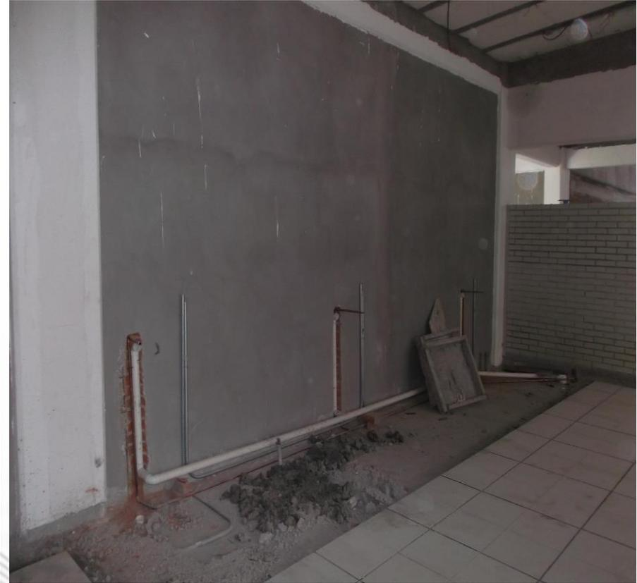
**COLOCION DE FIRME DE CONCRETO PARA RENIVELACION DE PISOS INTERIORES DE ACUERDDA PROYECTO, COLOCACION DE INSTALACIONES HIDROSANITARIAS Y ELECTRICAS EN LABORATORIO DE QUIMICA**
