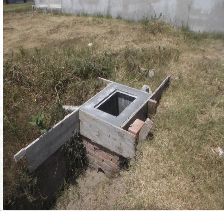
**CONSTRUCCION DE ESTRADO PARA ALOJAR INSTALACIONES HIDROSANITARIAS, ELECTRICAS, AIRE GAS. EN LABORATORIO DE QUIMICA, RENIVELACION DE REGISTROS SANITARIOS EXTERIORES**
