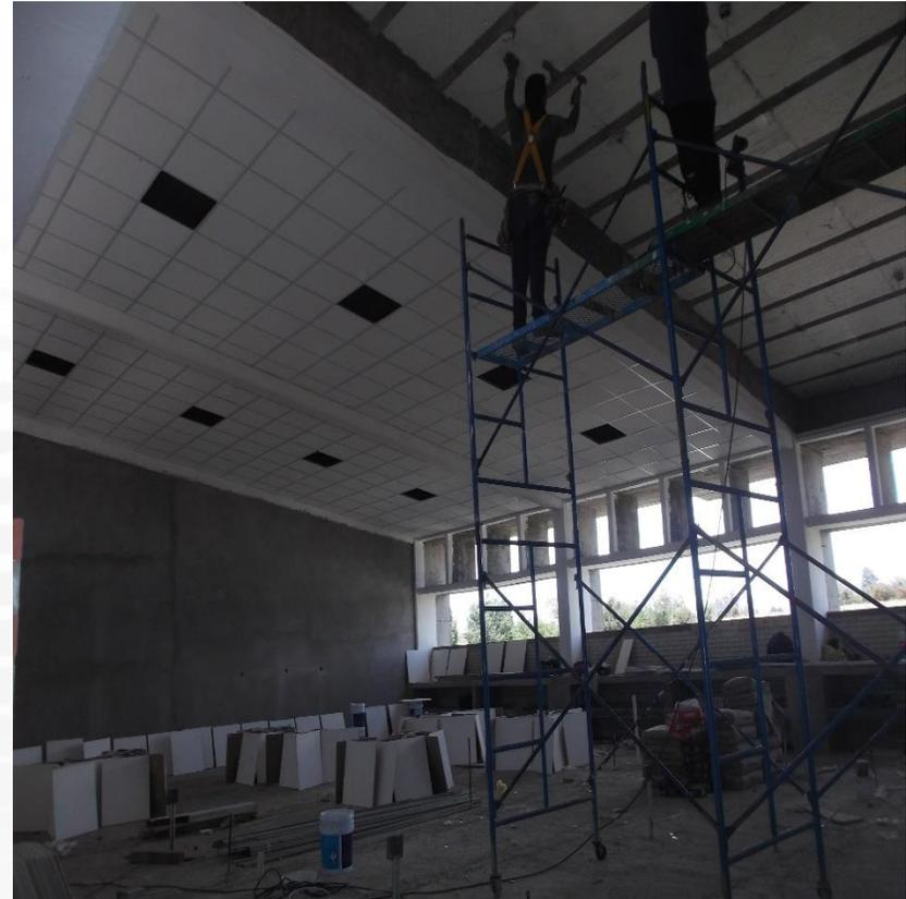
**COLOCACION DE SUSPENSION VISIBLE PARA FALSO PLAFON ACUSTICO CON PANELES DE 61X61 CM.**
