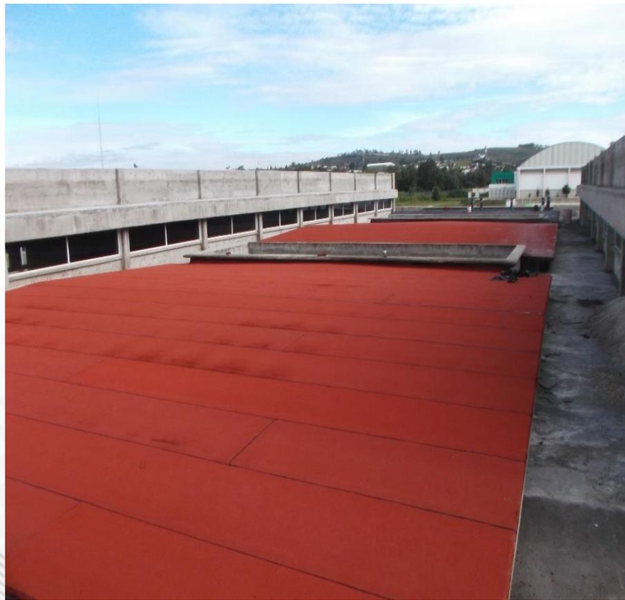
**COLOCACION DE RELLENO LIGERO A BASE DE CACAHUATILLO-CEMENTO EN LOSAS DE AZOTEA PARA DAR PENDIENTE, COLOCACION DE MEMBRANA DE IMPERMEABILIZACION EN LOSAS DE AZOTEA**
