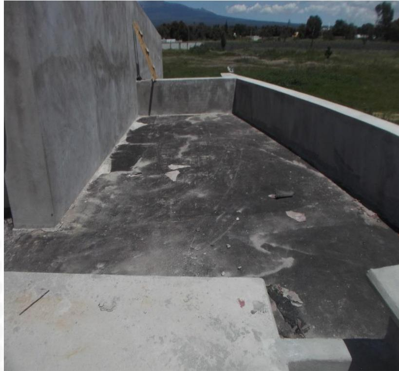
**RETIRO DE MEMBRANA DE IMPERMEABILIZACION EN MAL ESTADO EN LOSA DE AZOTEA**
