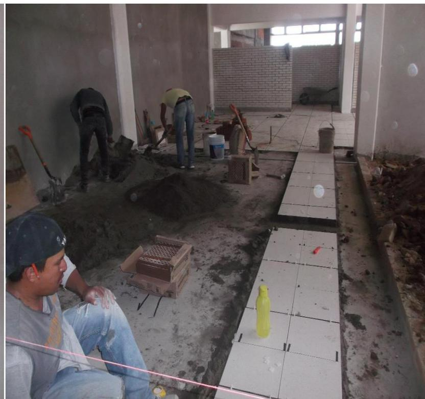
**COLOCACION DE LOSETA INTERCERAMIC TRÁFICO INTENSO EN PISOS INTERIORES**
