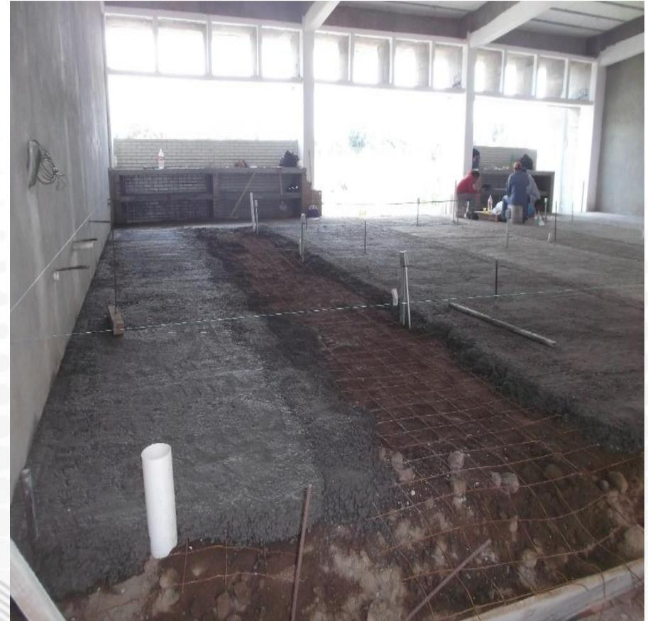
**SUMINISTRO Y COLOCACION DE LOSETA DE CERAMICA INTERCERAMIC TRAFICO INTENSO, TENDIDO DE FIRME DE CONCRETO REFORZADO CON MALLA ELECTRO SOLDADA EN LABORATORIO DE QUIMICA**
