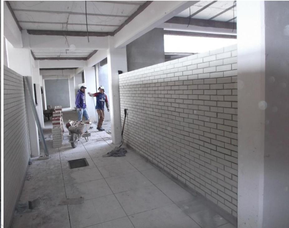
**COLOCACION DE LOSETA DE CERAMICA INTERCERAMIC EN PISOS INTERIORES Y CONSTRUCCION DE MUROS APARENTES STA. JULIA**
