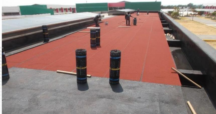
**SUMINISTRO DE IMPERMEABILIZANTE Y APLICACIÓN DE PRIMARIO BASE AGUA PARA SELLADO DE POROS Y LIGA DE EL LIENZO IMPERMEABILIZANTE A LOSA DE AZOTEA EN EDIFICIO LT-2**
