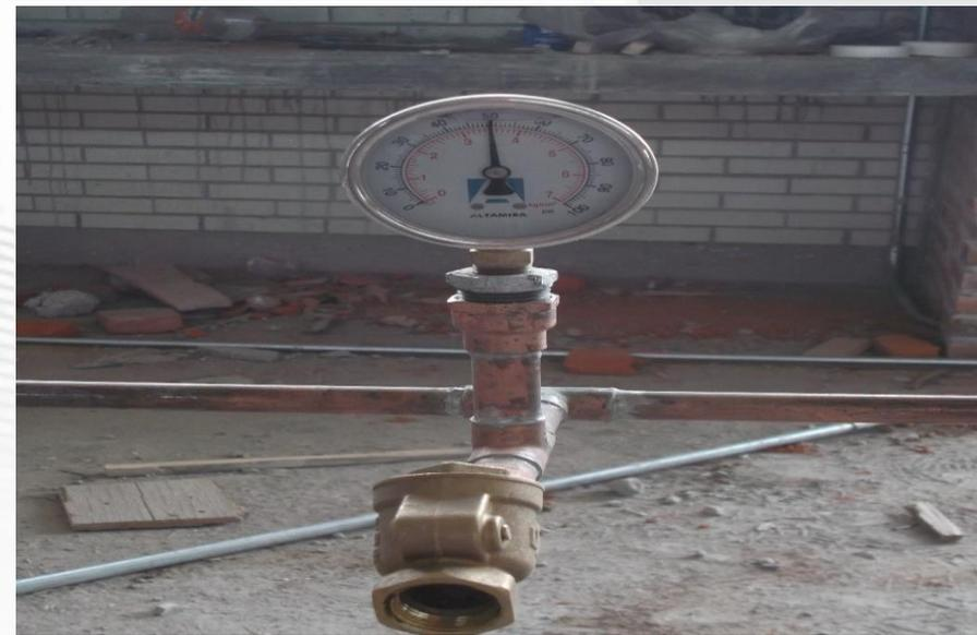
CABLEADO EN SALIDAS ELECTRICAS EN PLAFON PARA LUMINARIAS A BASE DE CABLE USO RUDD Y PRUEBA HIDROSTÁTICA EN INSTALACIONES HIDRAULICAS PARA LA ADAPTACION DE LABORETORIOS DE QUIMICA EDIFICIO LT-3
