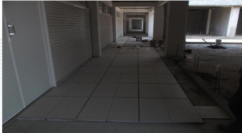
**TENDIDO DE FIRME DE CONCRETO F' C= 150KG/CM2. PARA RENIVELACION DE PISOS INTERIORES DE ACUERDO A NIVELES DE PROYECTO, SUMINISTRO Y COLOCACION DE LOSETA DE CERAMICA TRAFICO INTENSO EN PISOS INTERIORES**
