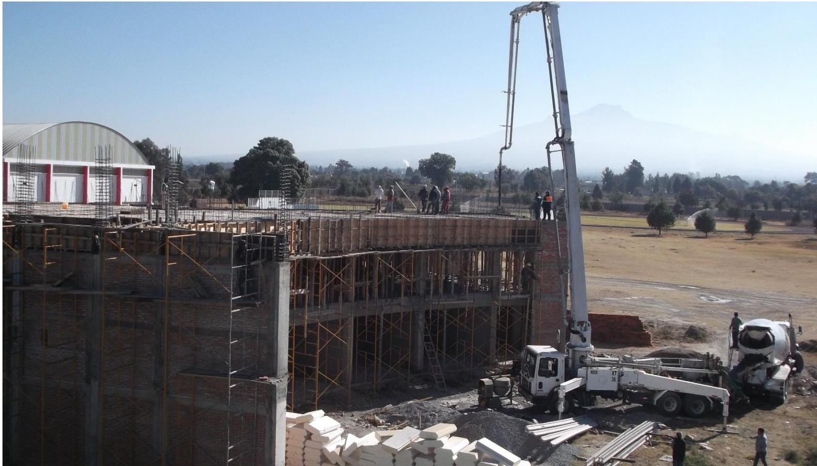
COLADO DE LOSA DE AZOTEA NIVEL + 7.80 M.
