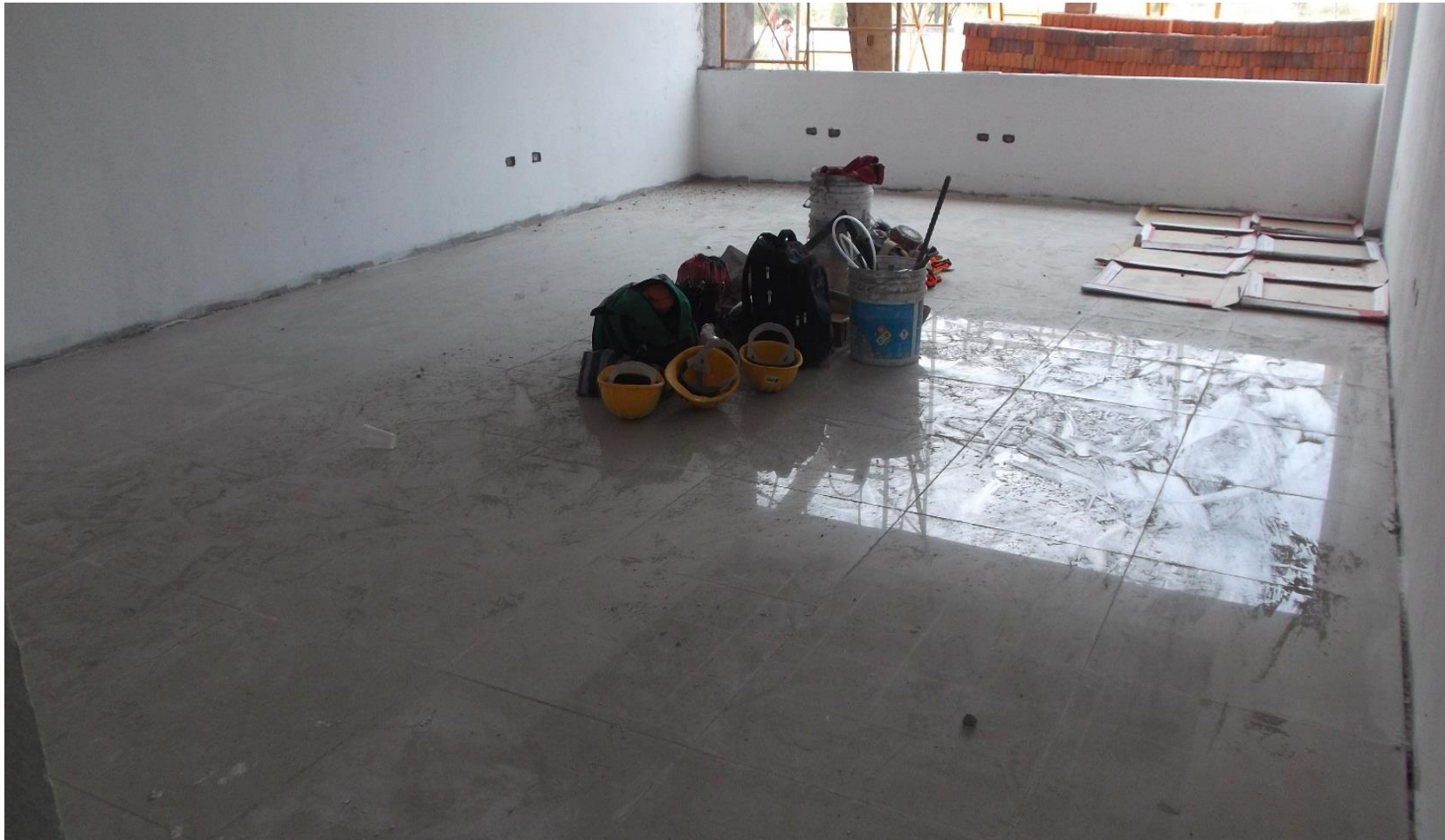
COLOCACION DE LOSETA DE CERAMICA EN PISO PLANTA BAJA.
