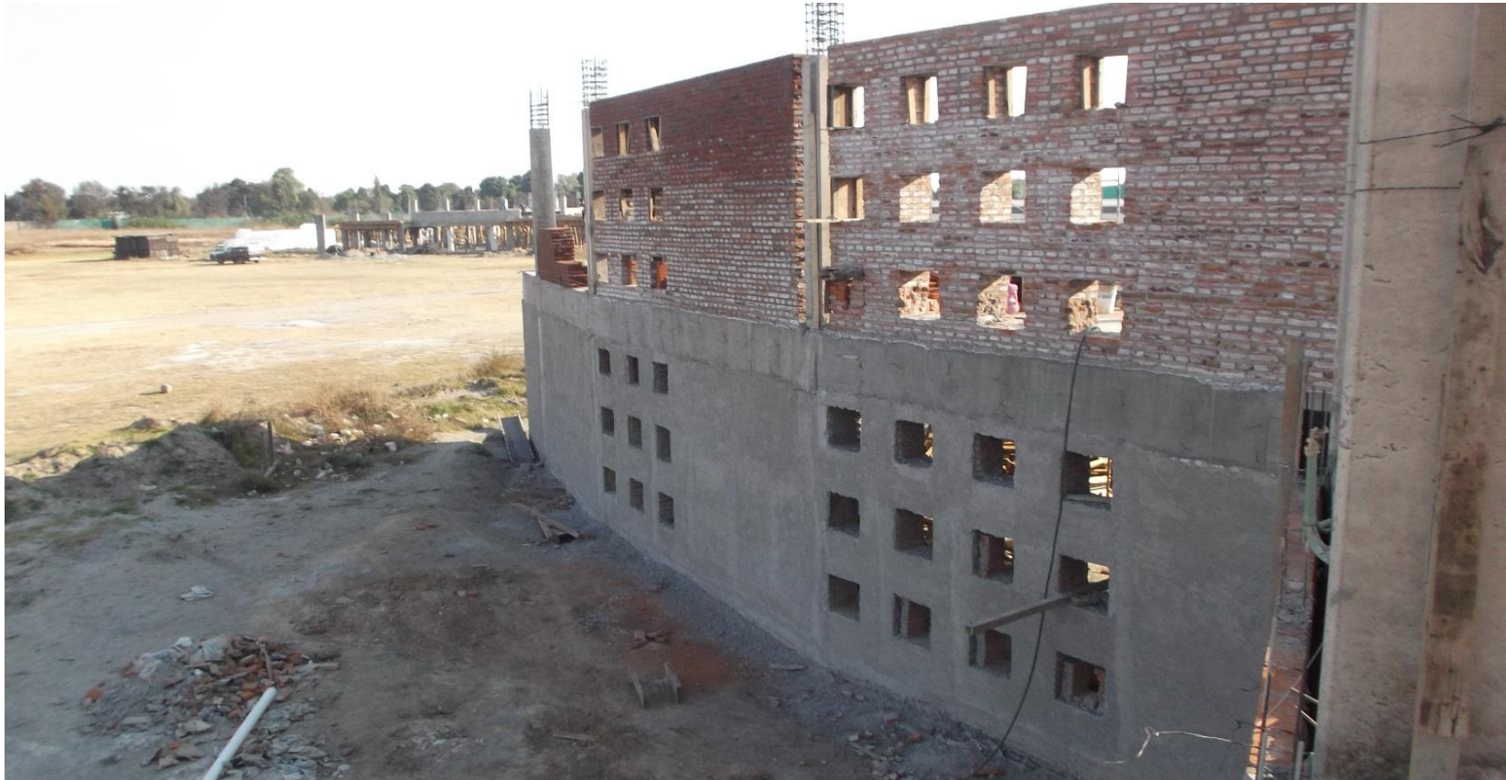
APLANADO DE MUROS EXTERIORES EN PLANTA BAJA
