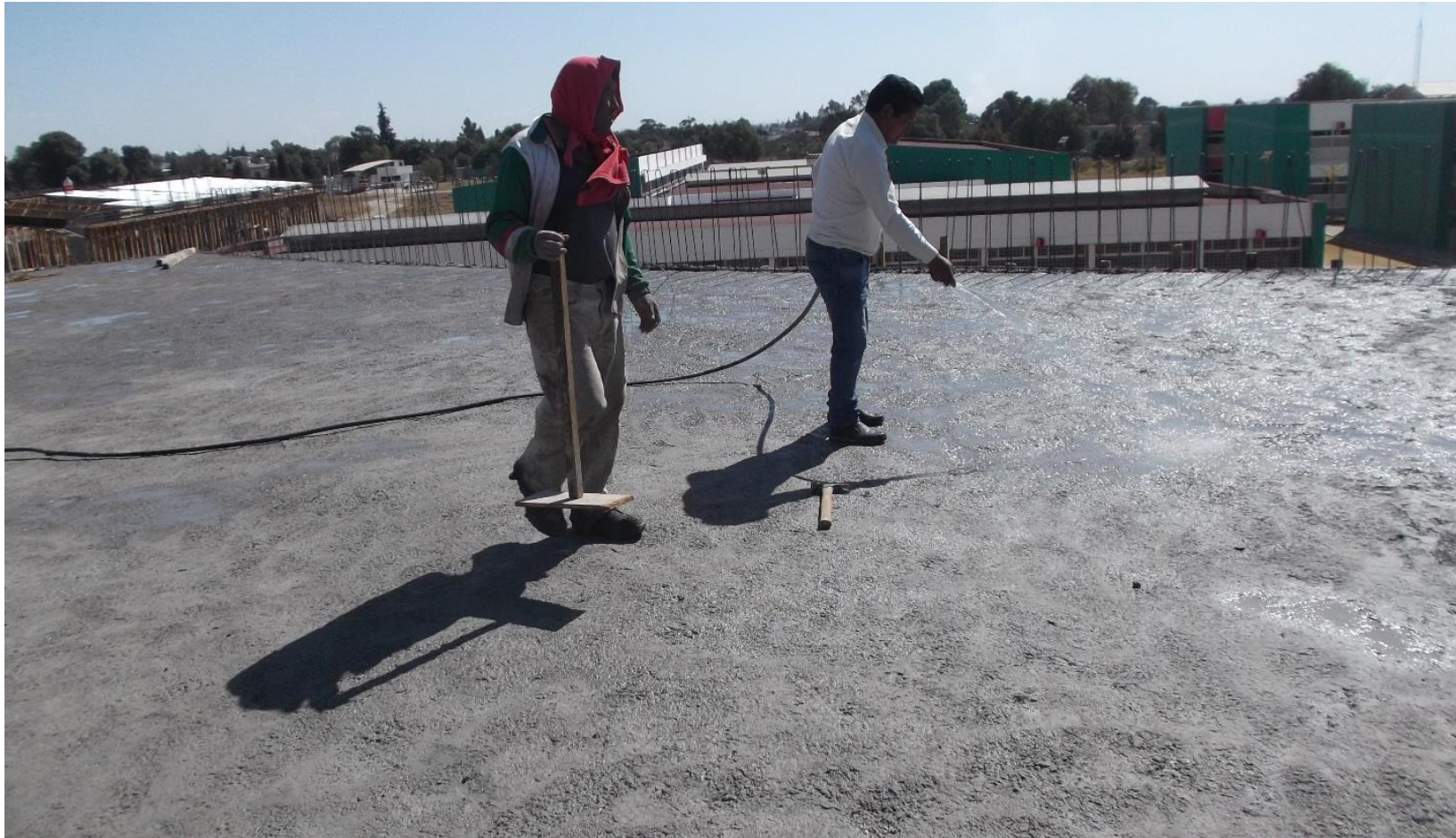
COLADO DE LOSA DE AZOTEA NIVEL + 7.80 M.
