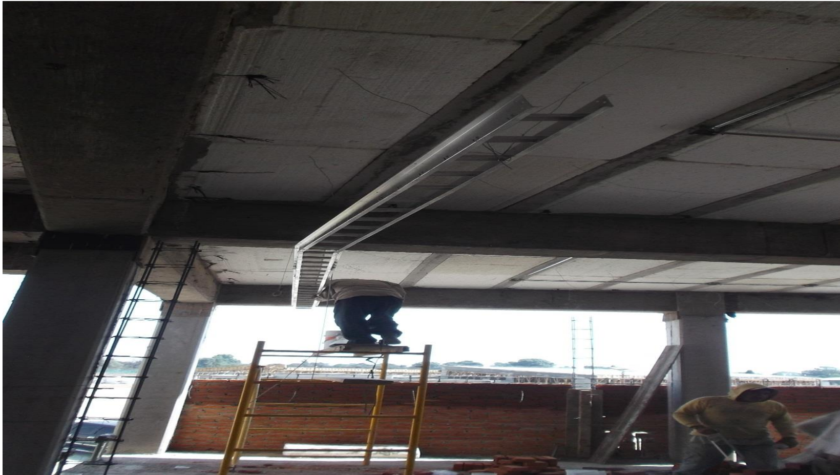
INSTALACIONES ELECTRICAS Y DE VOZ Y DATOS EN SEGUNDO PISO.
