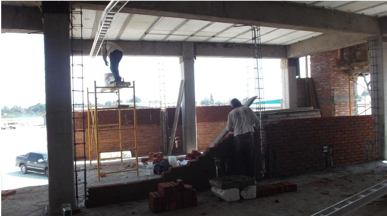
DESPLANTE DE MUROS INTERIORES EN PLANTA ALTA.
