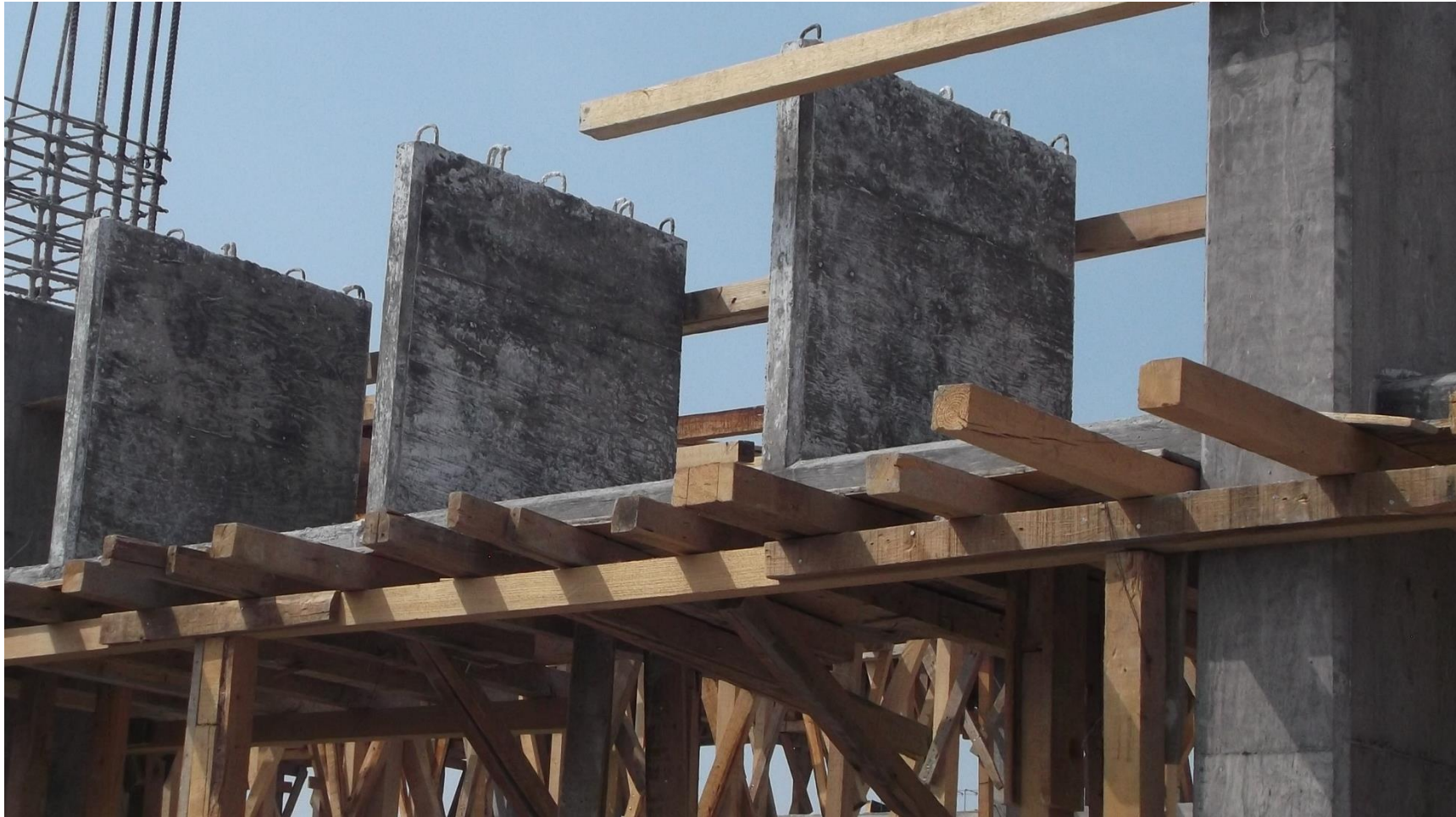
PARTE LUZ COLADO A BASE DE CONCRETO PREMESCLADO F' C= 250KG/CM2 .
