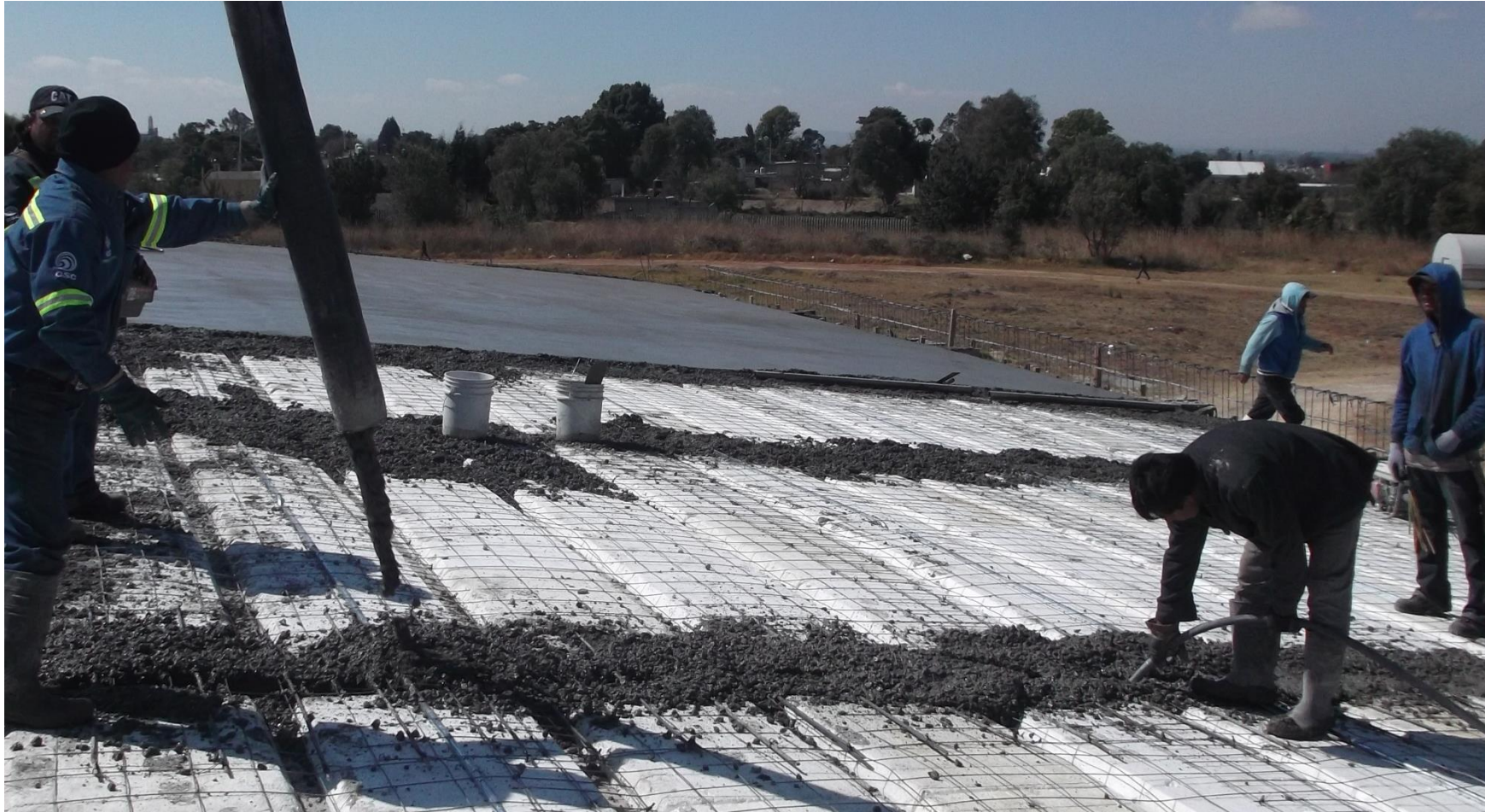
VACIADO DE CONCRETO PREMEZCLADO F' C =250 KG/CM2 EN LOSA DE AZTEA Y VIBRADO DE CONCRETÓ EN TRABES
