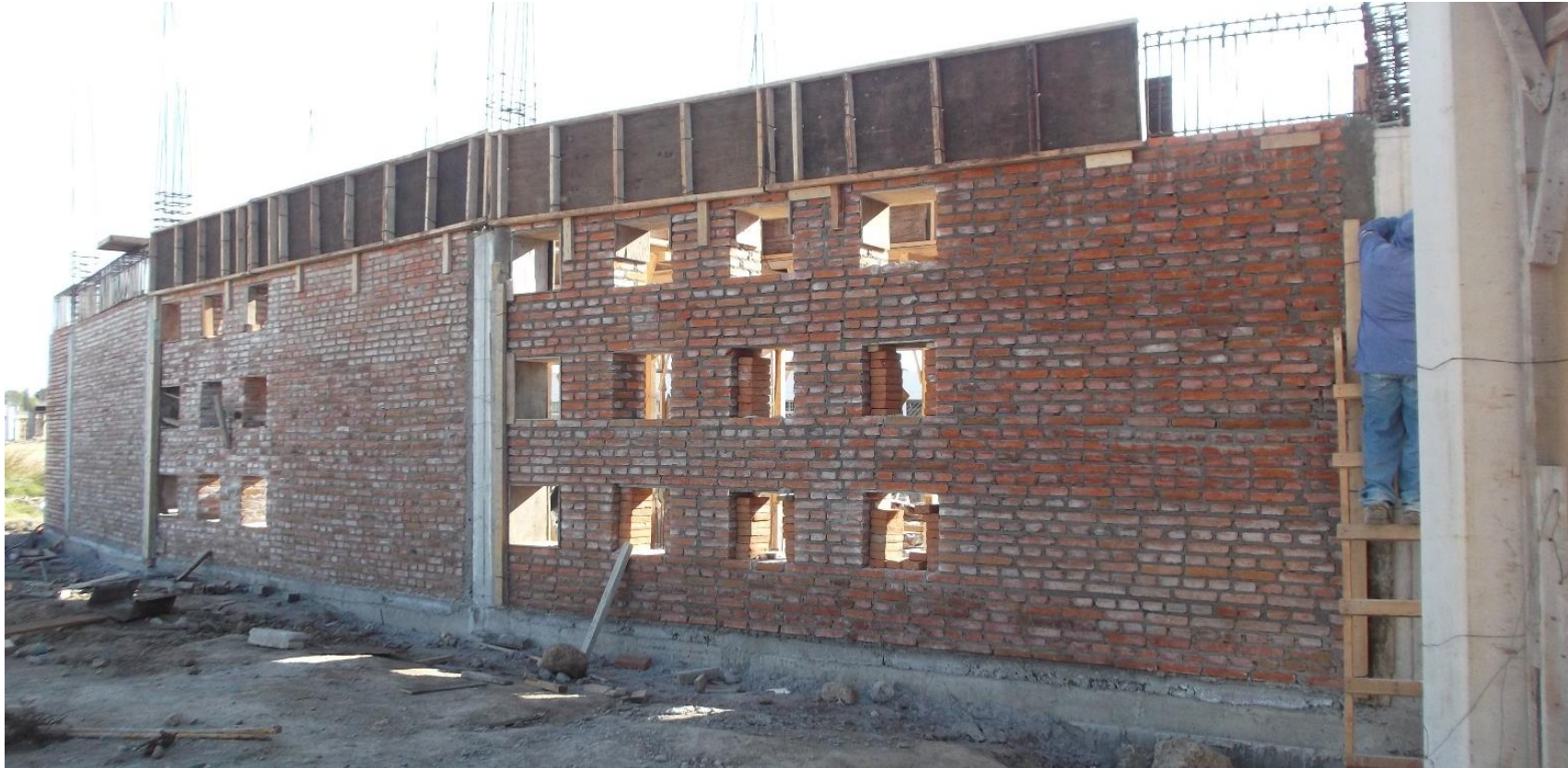
DESPLANTE DE MUROS DE TABIQUE ROJO RECOCIDO EN PLANTA BAJA
