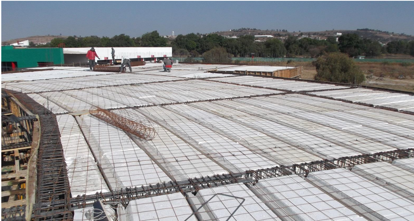
DE VIGUETAS PRETENSADAS Y CASETONES COLOCACION DE POLIESTIRENO EN LOSA DE AZOTEA NIVEL + 7.80 M.
