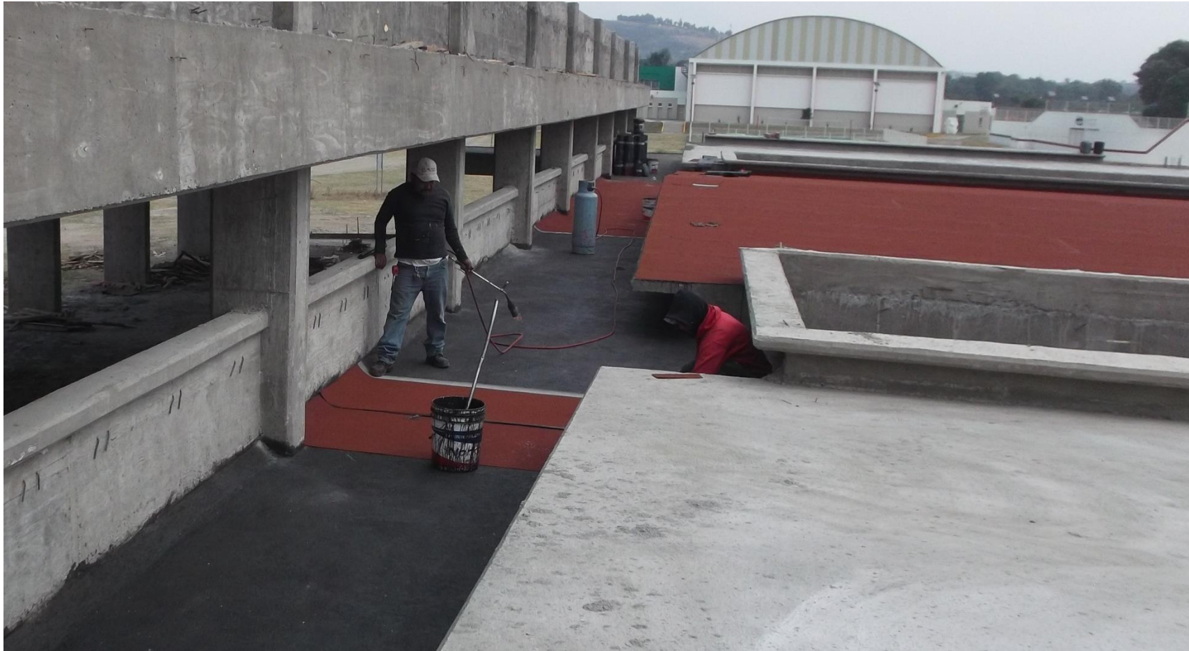
TRABAJOS DE IMPERMEABILIZACION EN LOSA DE AZOTEA
