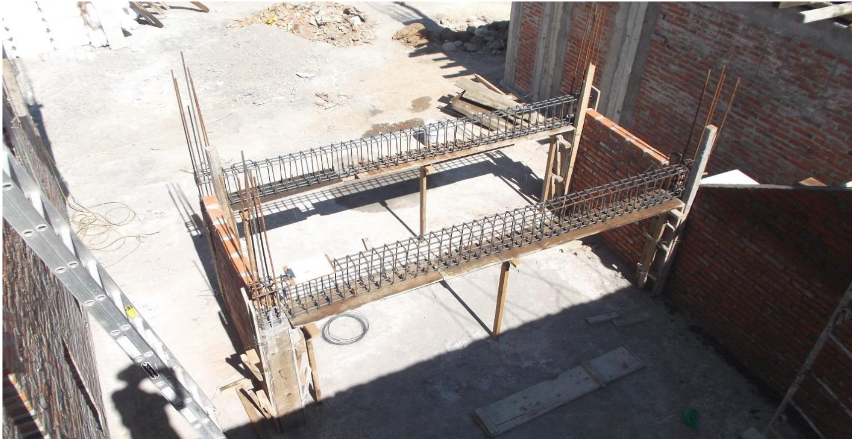
CONSTRUCCION DE MUROS, CIMBRADO Y ARMADO DE ESTRUCTURA DE ESCALERA.
