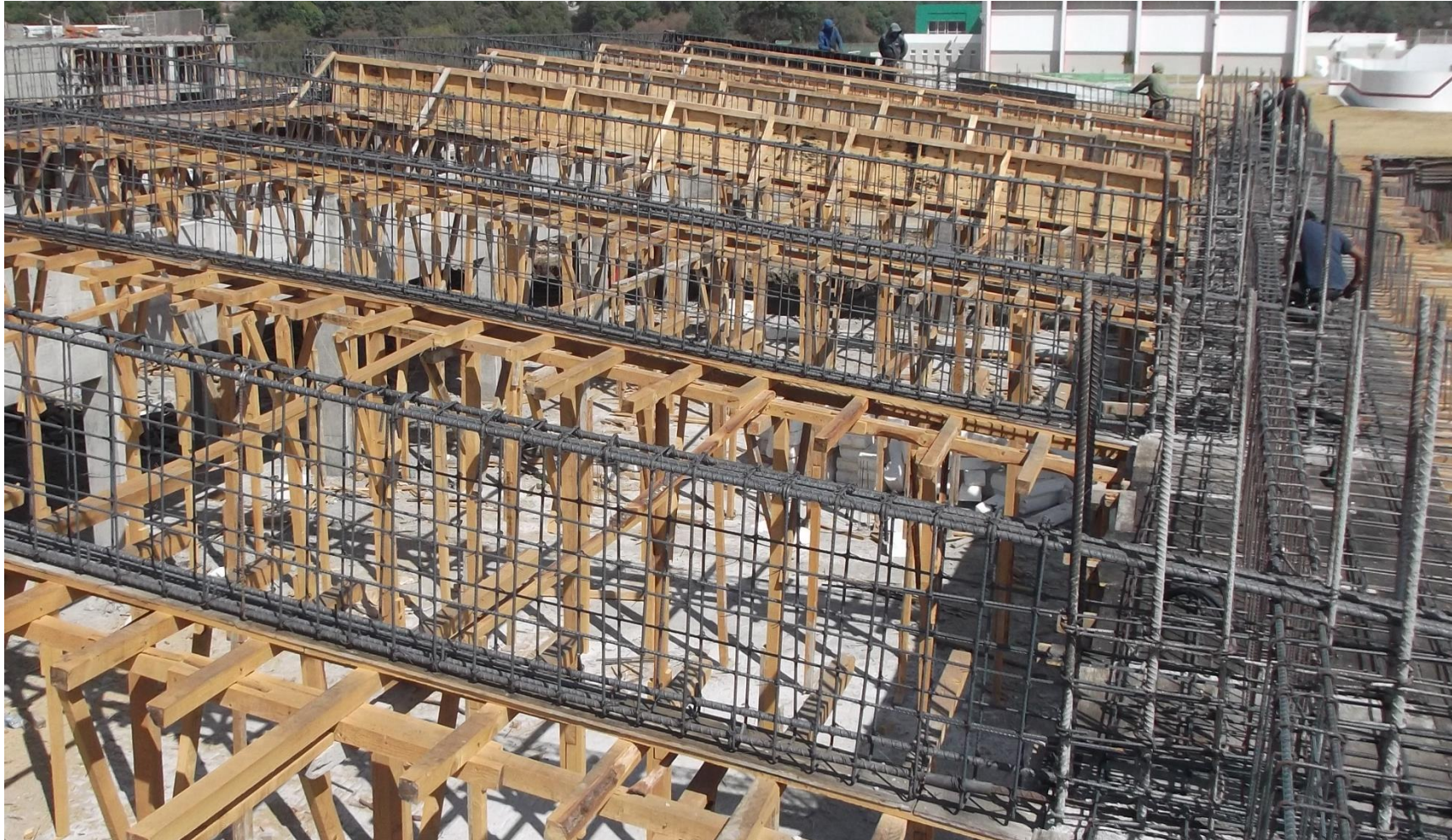
CIMBRADO Y ARMADO DE ACERO EN TRABES Y FALDON.
