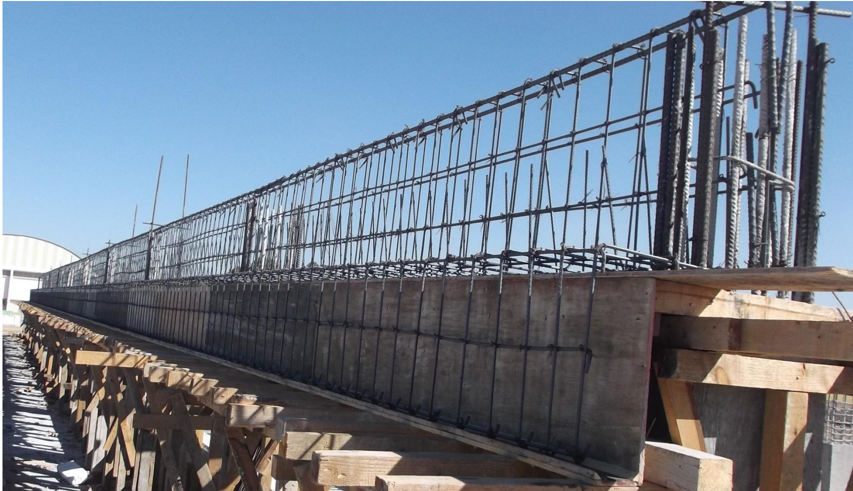
CIMBRADO Y ARMADO DE ACERO EN TRABE Y FALDON
