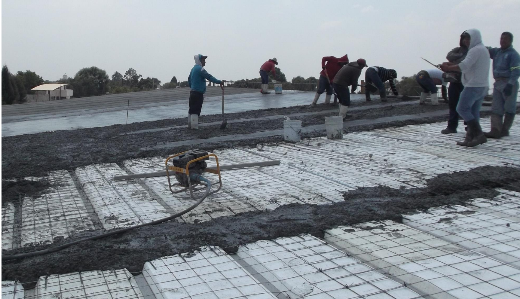
VACIADO DE CONCRETO PREMEZCLADO F' C = 250 KG/CM2 EN LOSA DE AZOTEA.
