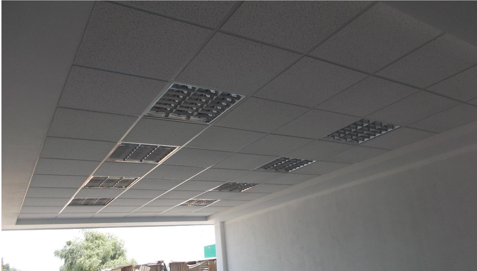
COLOCACION DE PLAFON RETICULAR Y LUMINARIA
