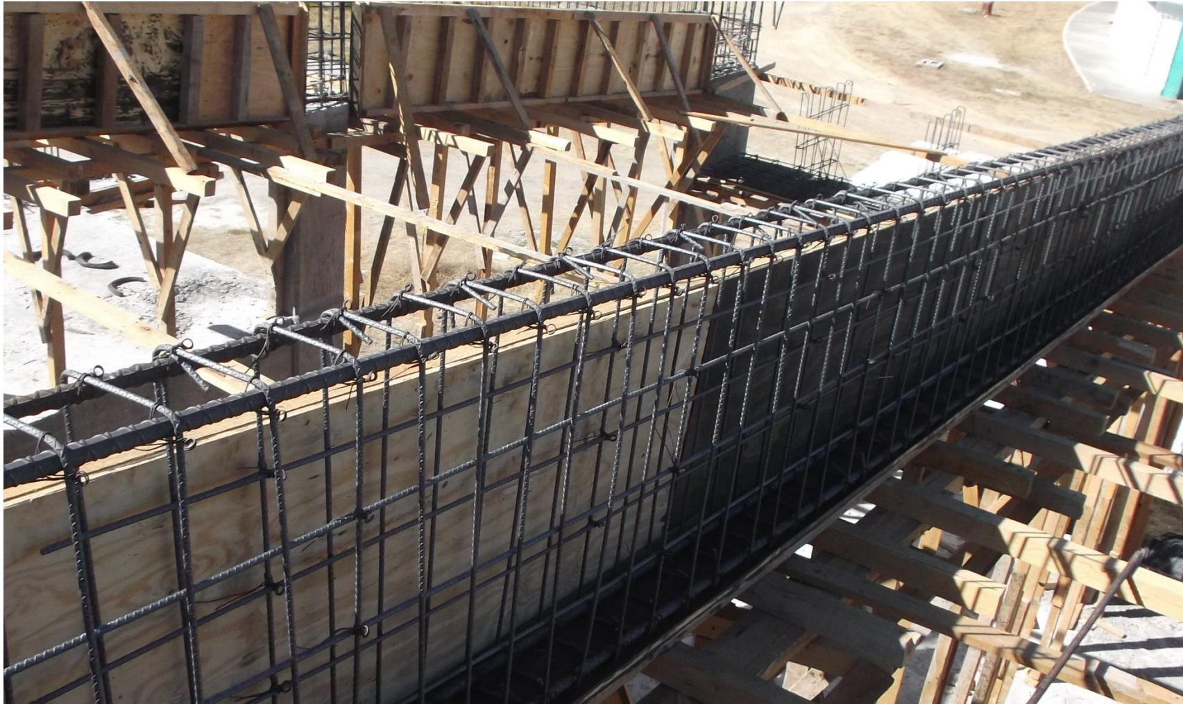
CIMBRA Y ARMADO DE ACERO EN TRABES.
