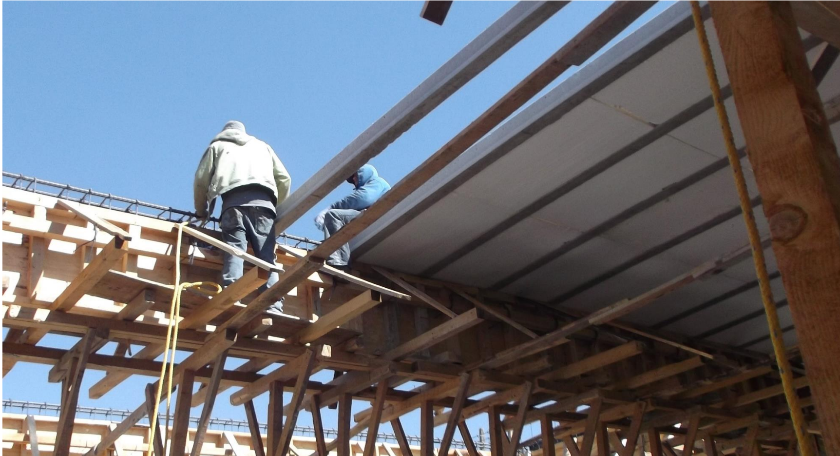
COLOCACION DE VIGUETAS Y CASETON DE POLIESTIRENO PARA VACIADO DE CONCRETO F' C= 250KG/CM2 EN LOSA DE AZOTEA.
