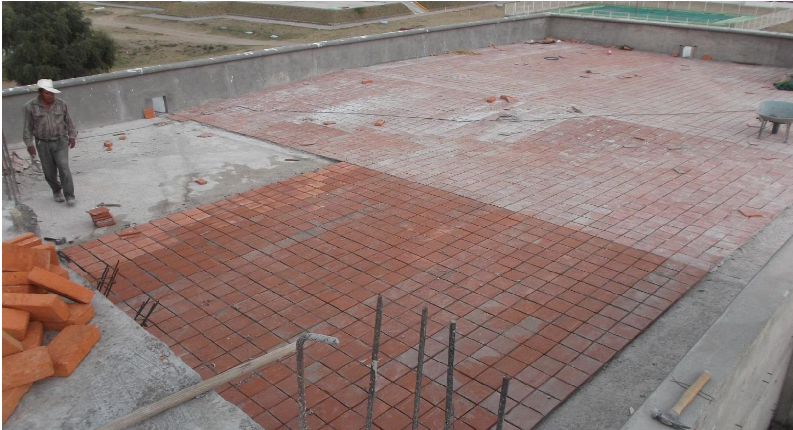
ENLADRILLADO EN LOSA DE AZOTEA NIVEL + 7.80 M.
