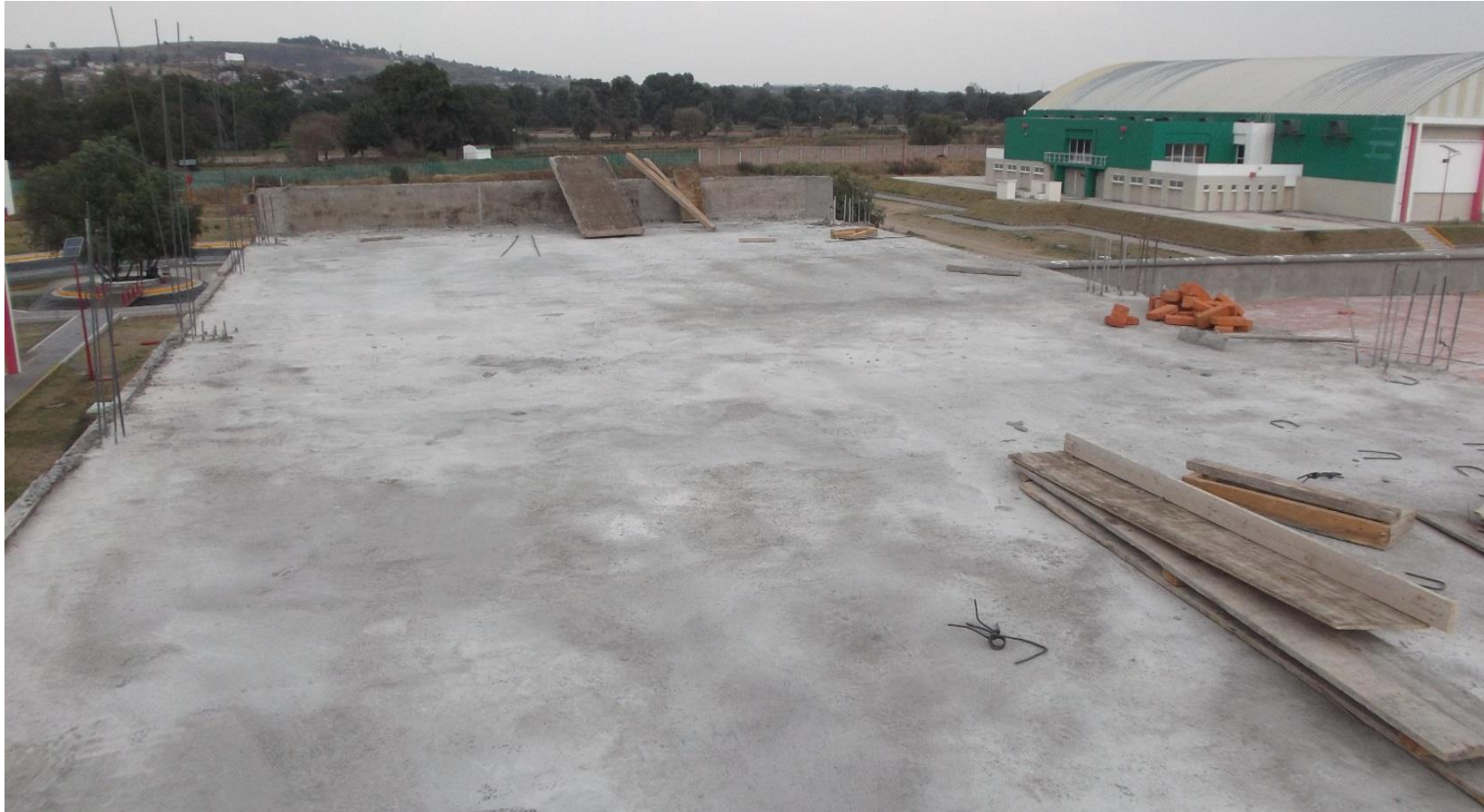
COLADO DE LOZA DE AZOTEA TERCERA ATAPA NIVEL + 9.80 M.
