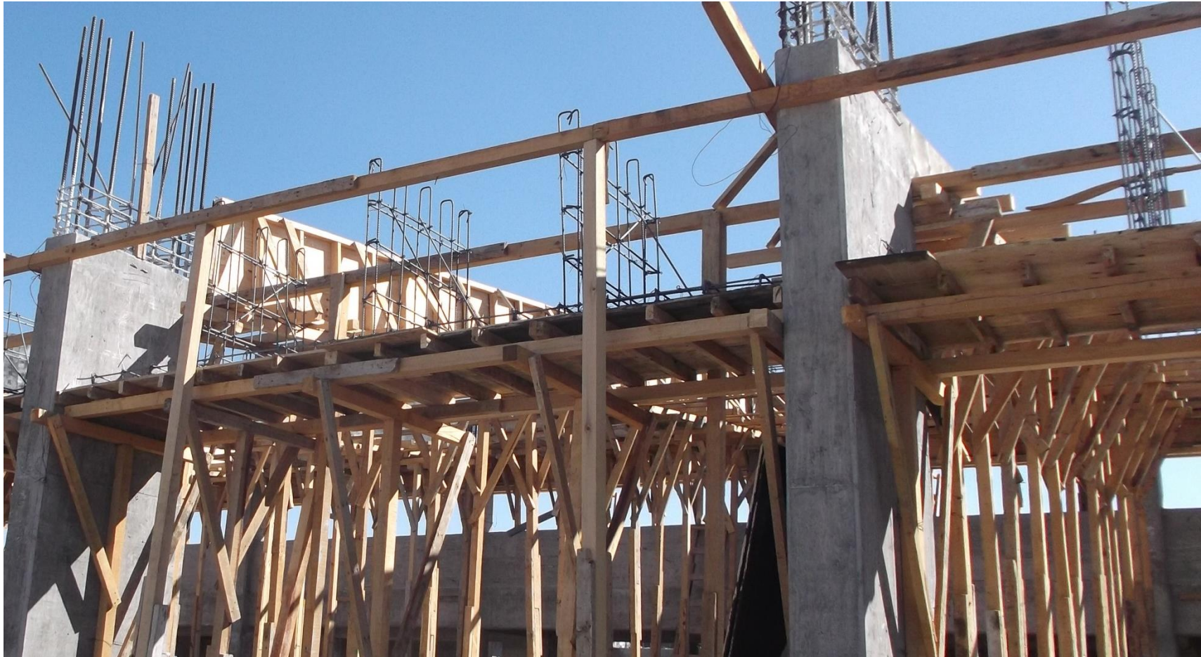
TABAJO DE CIMBRADO Y ARMADO DE ACERO EN PARTE LUZ
