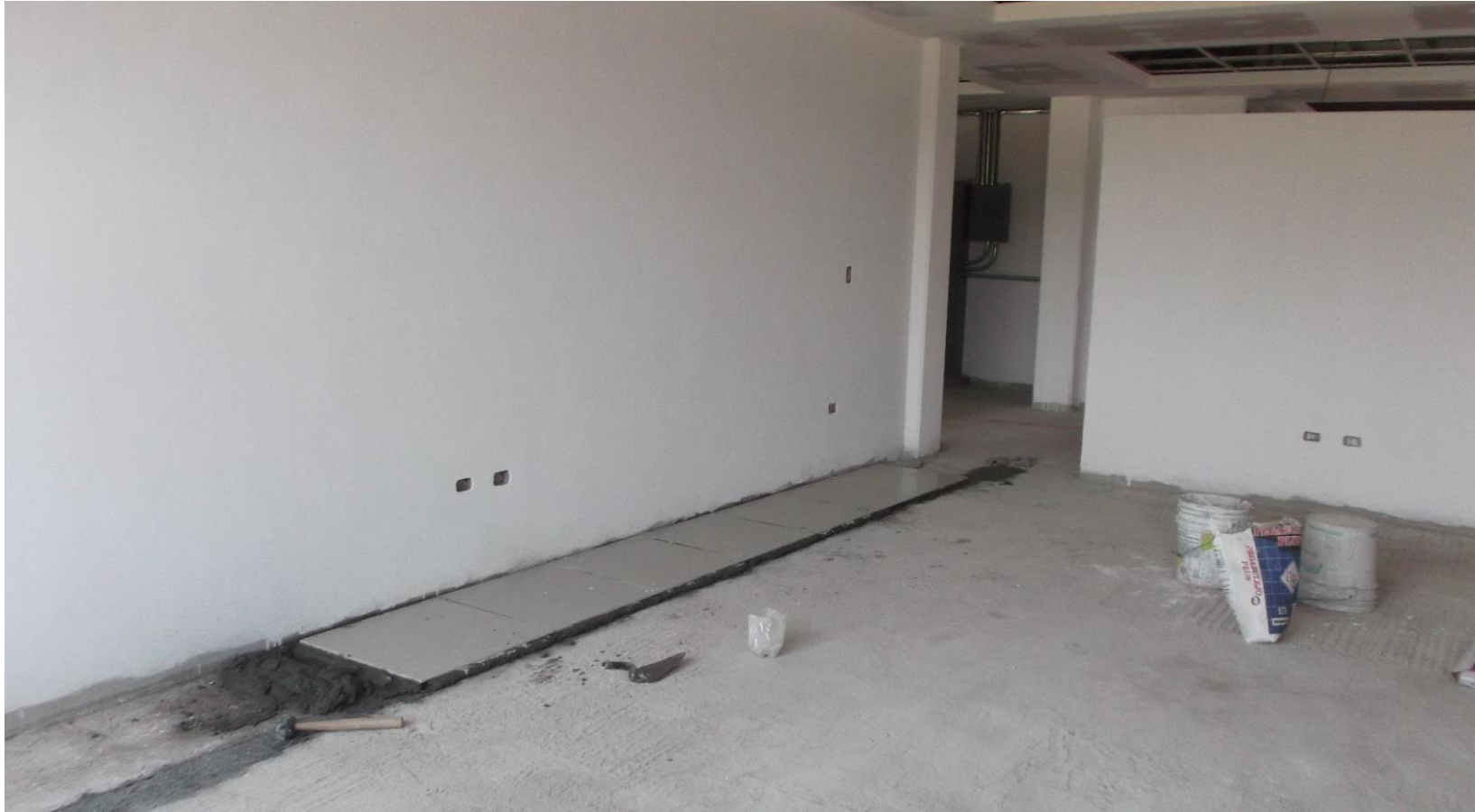
APLICACIÓN DE SELLADOR (FONDED) PARA RECIBIR PINTURA VINILICA EN MUROS DE PLANTA BAJA.
