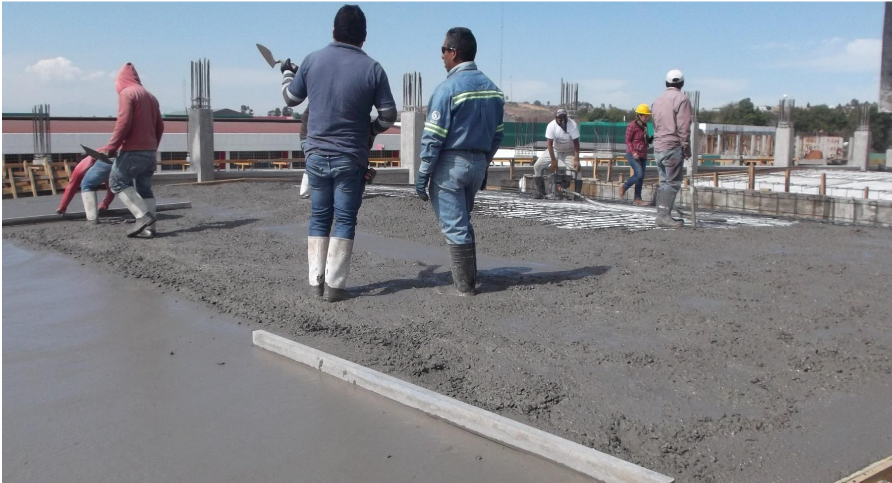
VACIADO DE CONCRETO PREMEZCLADO EN LOSAS RESISTENCIA F'c = 250 KG/CM2
