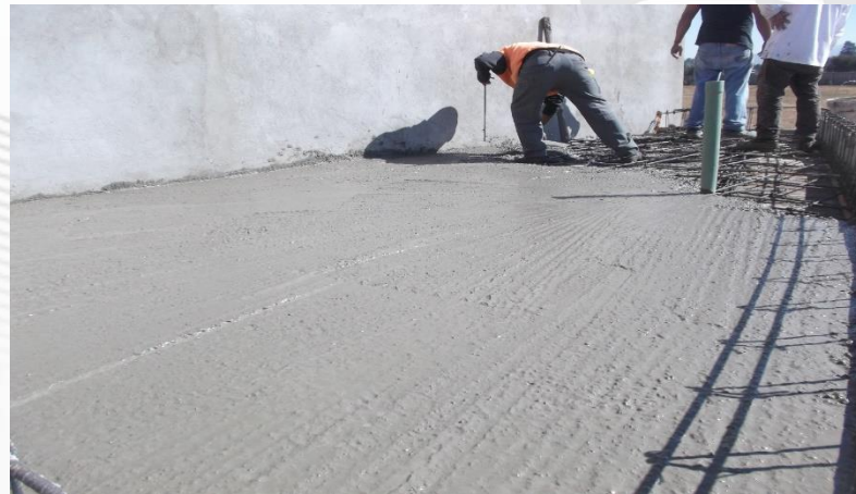
EDIFICIO LT-3. COLADO DE LOSA DE CONCRETO HECHO EN OBRA F' C=200 KG/CM2 EN ÁREA DE ALMACÉN DE RESIDUOS TÓXICOS.
