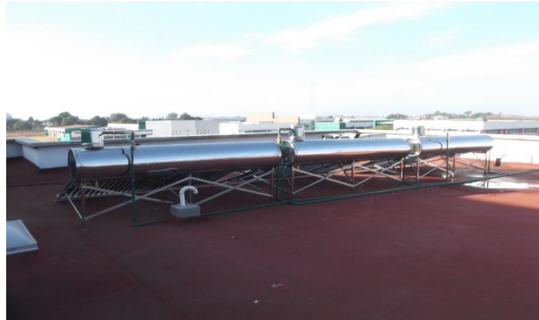
GIMNASIO UNIVERSITARIO: SUMINISTRO, COLOCACIÓN Y CONEXIÓN DE CALENTADORES SOLARES EN AZTEA DEL GIMNASIO
