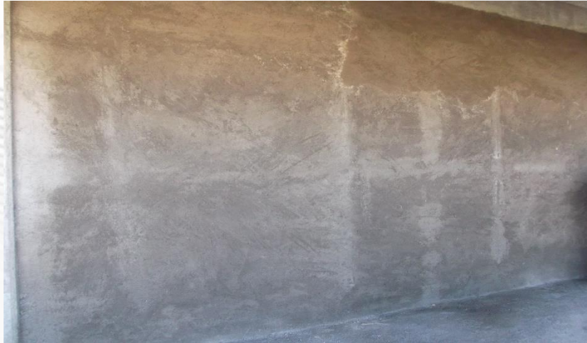
APLANADO EN MUROS INTERIORES A BASE DE MORTERO CEMENTO-CAL-ARENA PROP. 1:2:6
