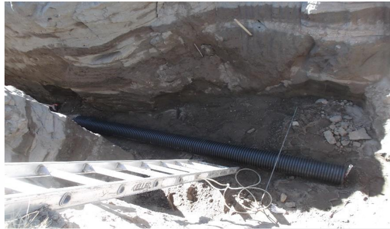
OBRA EXTERIOR: TENDIDO DE TUBO ADS DE 20 CM. DIÁMETRO (POLIETILENO DE ALTA DENSIDAD) PARA RED DE DRENAJE
