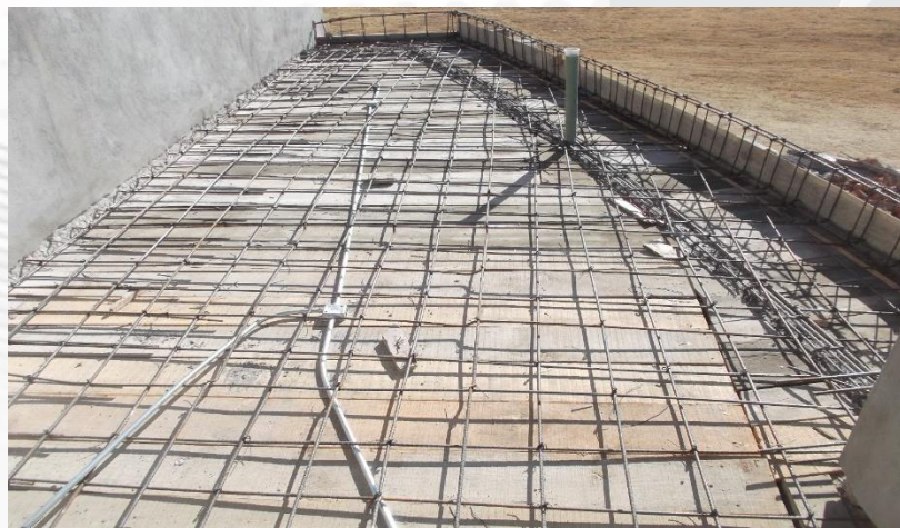
EDIFICIO LT-3. CIMBRADO Y TENDIDO DE ACERO DE REFUERZO E INSTALACIONES ELÉCTRICAS PARA COLADO DE LOSA EN ÁREA DE ALMACÉN DE RESIDUOS TÓXICOS.
