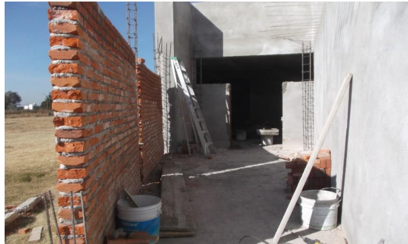
EDIFICIO LT-3. CONSTRUCCIÓN DE MUROS DE TABIQUE ROJO RECOCIDO EN ÁREA DE ALMACÉN DE RESIDUOS TÓXICOS.
