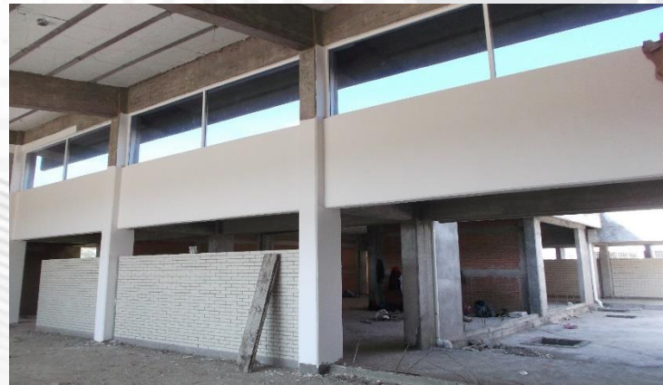
EMPLASTECIMIENTO EN ELEMENTOS DE CONCRETO (COLUMNAS, TRABES) INTERIORES PARA RECIBIR ACABADO FINAL DE PINTURA
