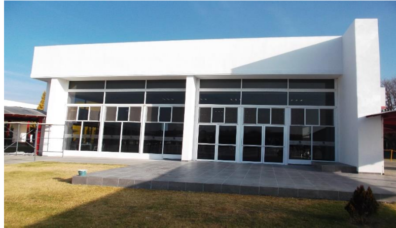
CAFETERÍA: SUMINISTRO Y COLOCACIÓN DE CANCELERÍA COLOR BLANCO LÍNEA 3" CON PUERTAS ABATIBLES EN TERRAZA EXTERIOR
