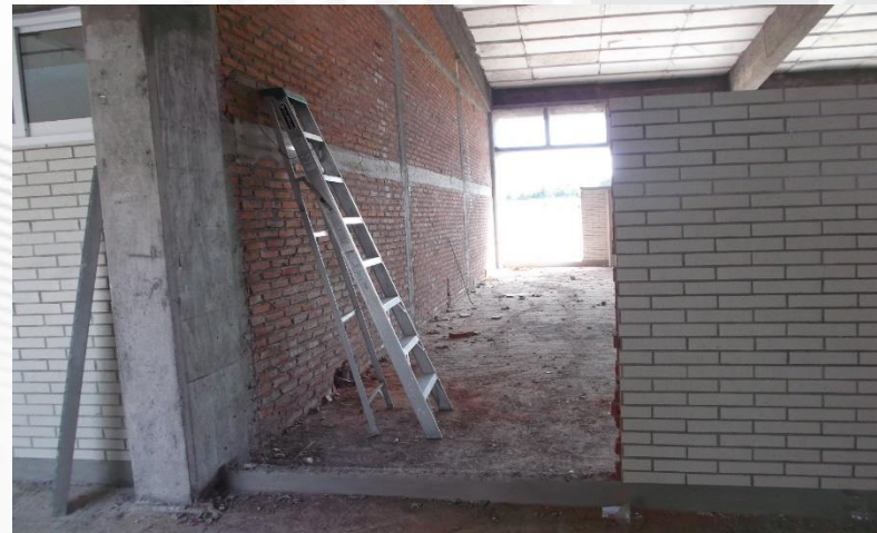
EDIFICIO LT-3: DEMOLICIÓN DE MUROS EXISTENTES TIPO SANTA JULIA PARA LA ADAPTACIÓN PUERTAS DE ACCESO Y SALIDA DE EMERGENCIA EJES A' Y C' /12-13
