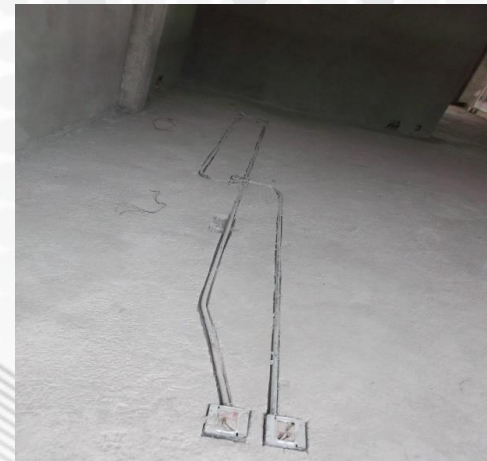
INSTALACIÓN DE SALIDAS ELÉCTRICAS POR LOSA DE CIMENTACIÓN A BASE DE TUBO CONDUIT GALVANIZADO P.D.
