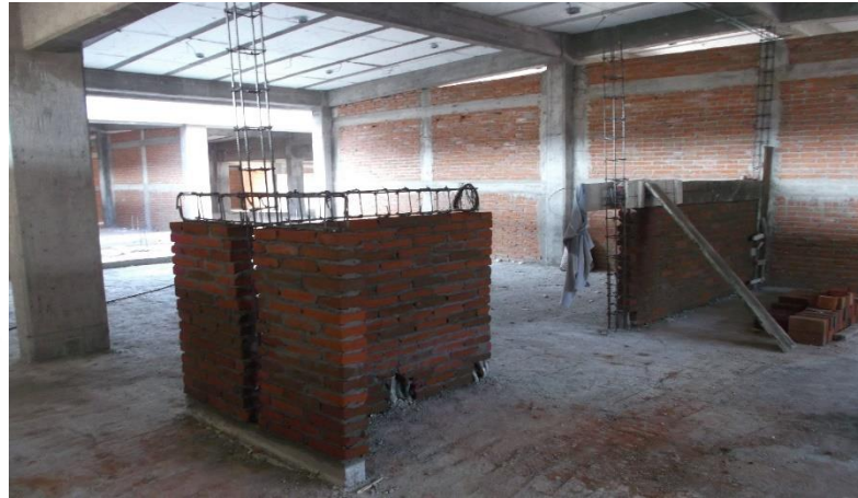
EDIFICIO LT-3. CONSTRUCCIÓN DE MUROS DE TABIQUE ROJO RECOCIDO EN ALMACÉN DE CRISTALERÍA Y OFICINA DE LABORATORISTAS
