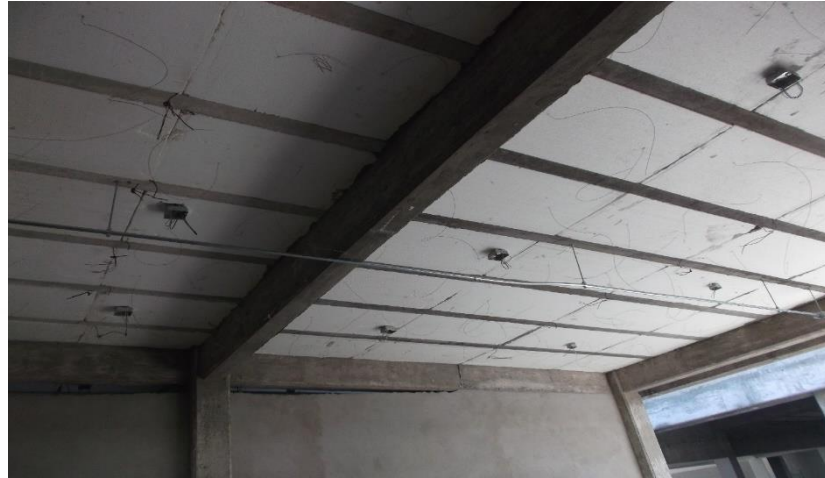
INSTALACIÓN DE SALIDAS ELÉCTRICAS POR PLAFÓN A BASE DE TUBO CONDUIT GALVANIZADO P.D
