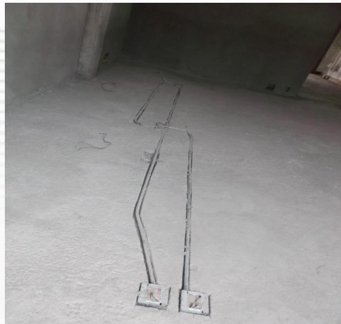
INSTALACIÓN DE SALIDAS ELÉCTRICAS POR LOSA DE CIMENTACIÓN A BASE DE TUBO CONDUIT GALVANIZADO P.D.
