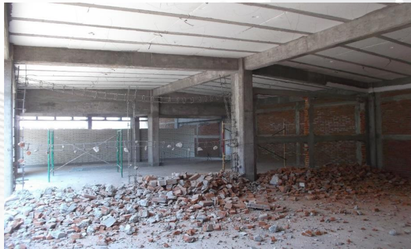
DEMOLICIÓN DE MUROS EXISTENTES PARA LA ADAPTACIÓN DE LABORATORIO DE QUÍMICA GENERAL SOLICITADA POR EL DIRECTOR DE CARRERA
