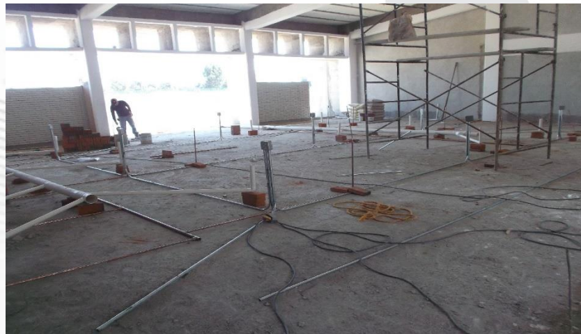
EDIFICIO LT-3. TENDIDO DE INSTALACIONES ELÉCTRICA, HIDRÁULICAS Y SANITARIAS PARA LABORATORIOS DE QUÍMICA.
