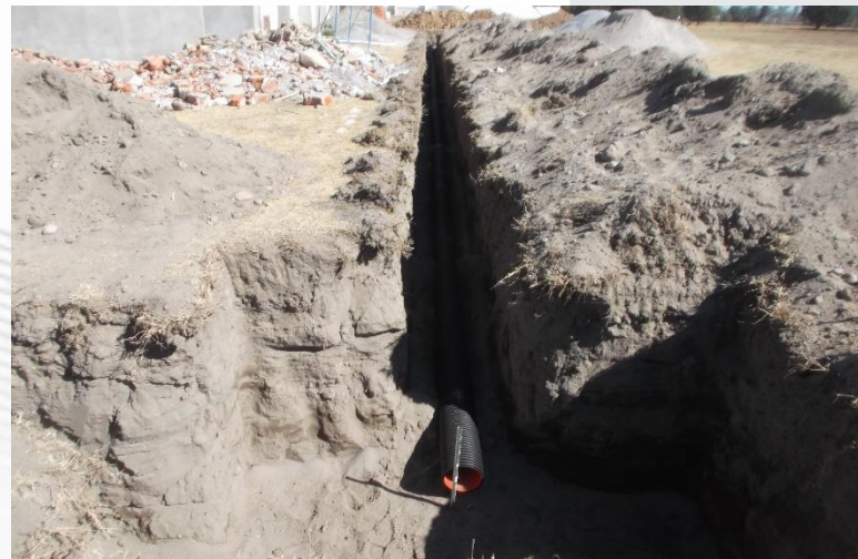
OBRA EXTERIOR: TENDIDO DE TUBO ADS DE 20 CM. DIÁMETRO (POLIETILENO DE ALTA DENSIDAD) PARA RED DE DRENAJE
