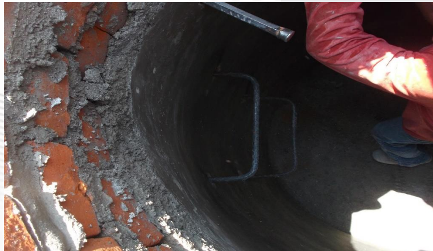
OBRA EXTERIOR: DESPLANTE DE MUROS PARA LA CONSTRUCCIÓN DE POZOS DE VISITA DE LA RED DE DRENAJE EXTERIOR
