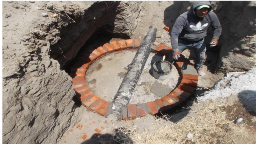
OBRA EXTERIOR: DESPLANTE DE MUROS PARA LA CONSTRUCCIÓN DE POZOS DE VISITA DE LA RED DE DRENAJE EXTERIOR
