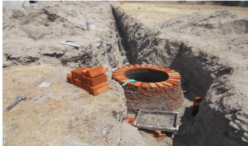
OBRA EXTERIOR: CONSTRUCCIÓN DE POZO DE VISITA PARA LE RED DE DRENAJE EXTERIOR
