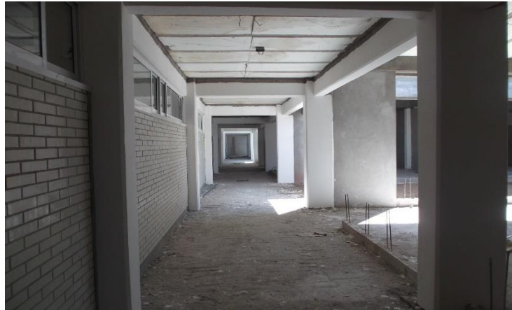
EMPLASTECIMIENTO EN ELEMENTOS DE CONCRETO (COLUMNAS, TRABES) INTERIORES PARA RECIBIR ACABADO FINAL DE PINTURA
