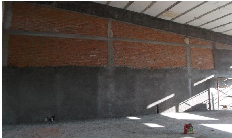
EDIFICIO LT-3. CONSTRUCCIÓN DE MUROS DE TABIQUE ROJO RECOCIDO EN LABORATORIOS DE QUÍMICA.
