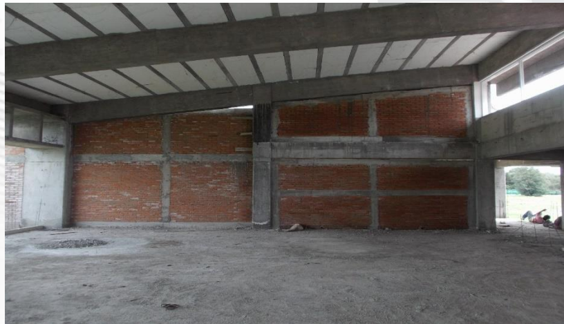
EDIFICIO LT-3. CONSTRUCCIÓN DE MUROS DE TABIQUE ROJO RECOCIDO EN LABORATORIOS DE QUÍMICA.
