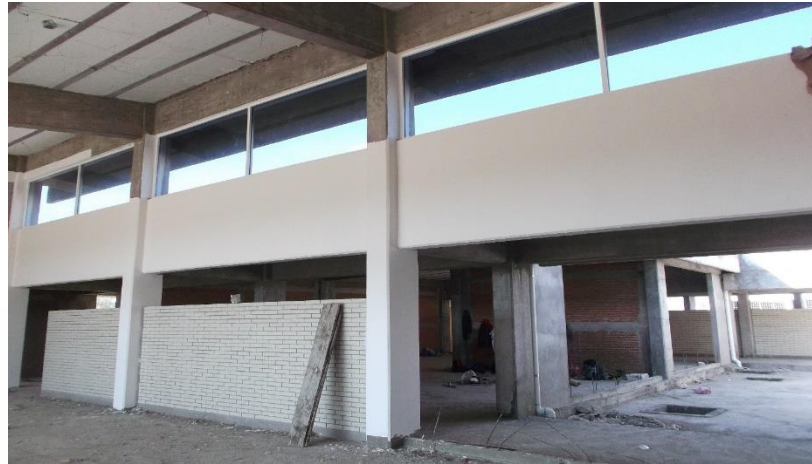
EDIFICIO LT-3. EMPLASTE CIMENTO DE ELEMENTOS DE CONCRETO APARENTE (TRABES, COLUMNAS) PARA RECIBIR ACABADO DE PINTURA
