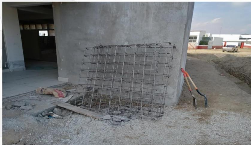
**EXCAVACIÓN Y TENDIDO DE PLANTILLA PARA LA CONSTRUCCIÓN DE CISTERNA CON CAPACIDAD DE 20 M3, DESPALME EN ZONA DE BANQUETAS Y EXCAVACIÓN PARA CONSTRUCCIÓN DE GUARNICIONES, RELLENO CON MATERIAL INERTE EN ZONA DE BANQUETAS Y HABILITADO DE ACERO DE REFUERZO PARA CONSTRUCCIÓN DE ZAPATAS AISLADAS.**
