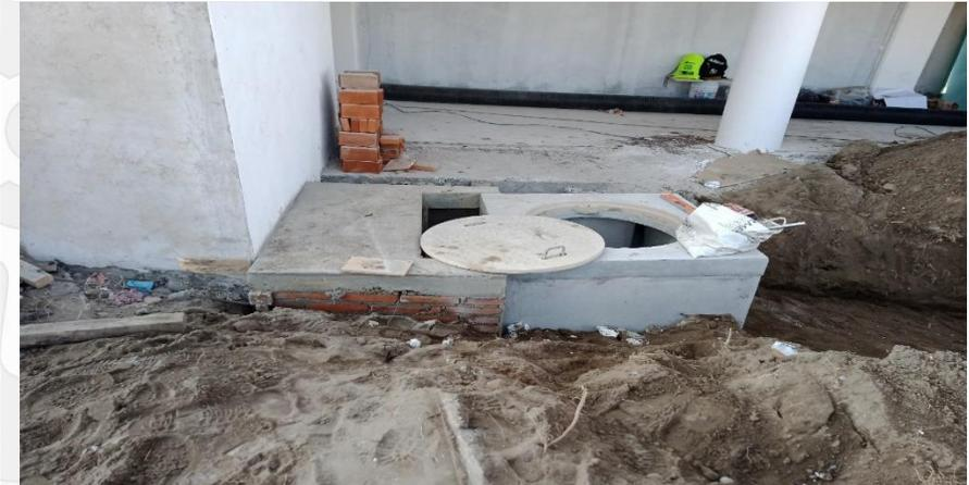
**CONSTRUCCION DE MURETES DE ENRASE PARA CONTENER RELLENOS COMPACTADOS EN ZAPATAS AISLADAS, CONSTRUCCIÓN DE BANQUETAS, SUMINISTRO DE ACERO DE REFUERZO EN LOSA DE CISTERNA Y SUMINISTRO DE REGISTRO PREFABRICADO PARA RECIBIR TRANSFORMADOR DE 300 KVA.**
