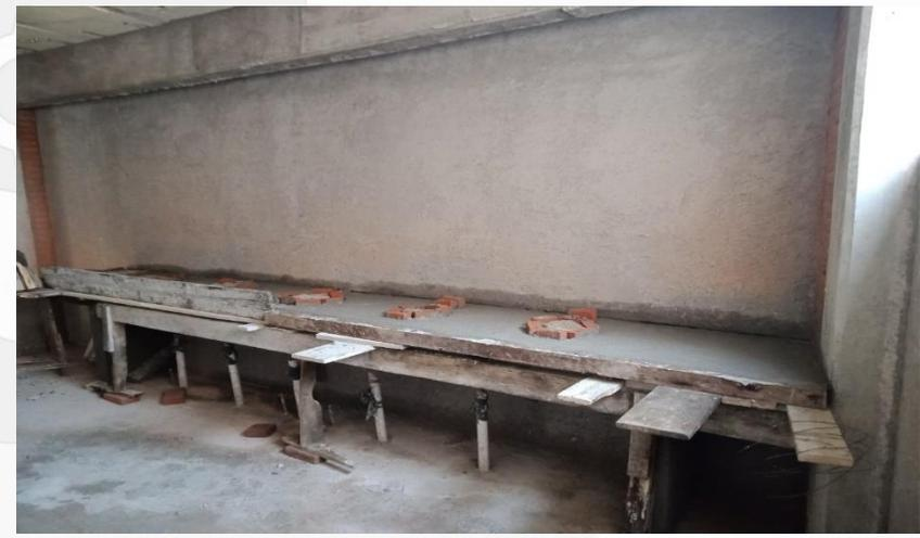
**REPELLADOS DE CEMENTO ARENA EN MUROS INTERIORES DE BAÑOS Y CONSTRUCCIÓN DE MESETAS DE CONCRETO PARA INSTALACIÓN DE OVALINES**
