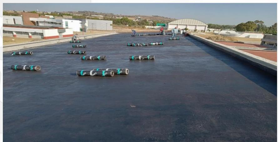
**HABILITADO DE ACERO DE REFUERZO PARA CONSTRUCCION DE DADOS Y ZAPATAS AISLADAS. CIMBRADO EN ZAPATAS (16 PZAS.) APLICACIÓN DE PRIMER ASFALTICO HIDROPRIMER EN LOSA DE AZOTEA NIVEL 6.61 M.**
