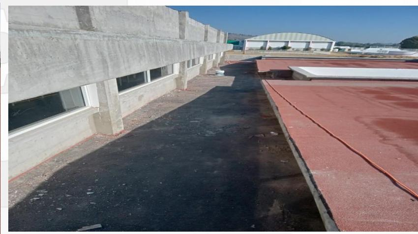
**EXCAVACIÓN EN CEPAS POR MEDIOS MECÁNICOS PARA INSTALACIÓN DE DUCTOS PARA RED ELÉCTRICA, RETIRO DE MEMBRANA IMPERMEABILIZANTE EN MAL ESTADO, SUMINISTRO Y COLOCACIÓN DE MEMBRANA IMPERMEABILIZANTE PREFABRICADA A.P.P. DE 4MM. ESPESOR EN AZOTEA NIVEL 6.61 M.**
