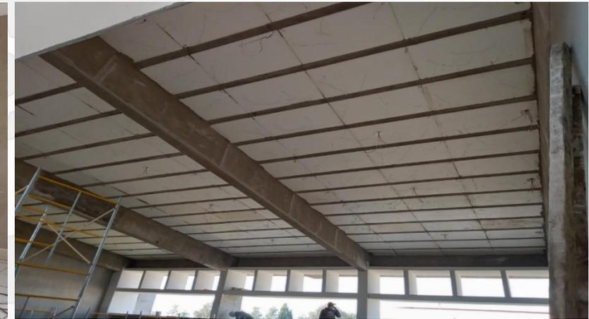
**EMPLASTE CIMIENTO EN ELEMENTOS ESTRUCTURALES (PARTELUCE Y COLUMNAS) FACHADA PONIENTE Y CABLEADO PARA SALIDAS ELÉCTRICAS DE CONTACTOS Y LUMINARIAS EN LABORATORIO DE INFRARROJO Y SISTEMAS AUTOMOTRICES**
