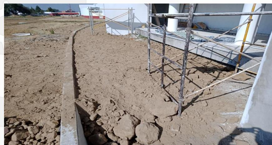
**COLADO EN ZAPATAS AISLADAS Y MUROS EN CISTERNA CON CONCRETO PREMEZCLADO F' C=250 KG/CM<sup>2</sup>, APLICACIÓN DE FONDEO EN MUROS DE FACHADAS PARA RECIBIR ACABADO DE PINTURA VINILICA Y RELLENO CON MATERIAL INERTE COMPACTADO PARA CONSTRUCCIÓN DE BANQUETAS EN ÁREAS EXTERIORES.**
