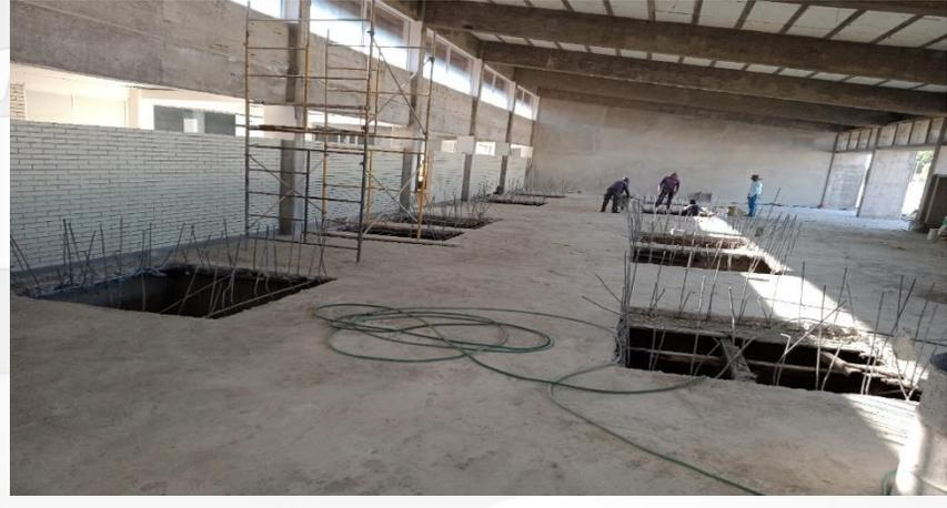
**SONDEO Y RECUPERACIÓN DE SALIDAS ELÉCTRICAS EN MUROS Y DEMOLICIÓN DE LOSA DE CONCRETO PARA CONSTRUCCIÓN DE ZAPATAS AISLADAS EN LABORATORIO DE INGENIERÍA DE SISTEMAS AUTOMOTRICES**
