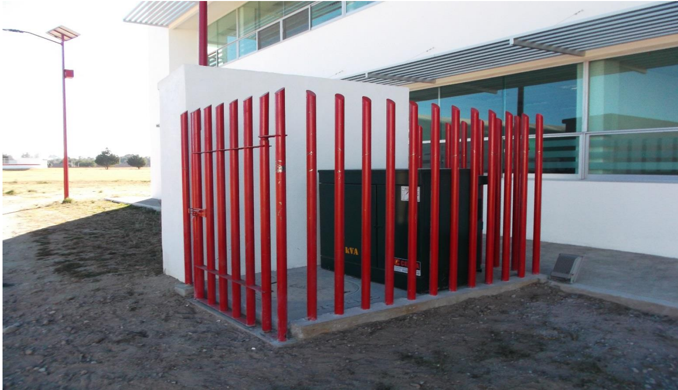
OBRA EXTERIOR: CONSTRUCCIÓN DE CERCADO METÁLICO PARA PROTECCIÓN DE SUBESTACIÓN DE 75 KVA. DEL EDIFICIO DE DOCENCIA UD-5
