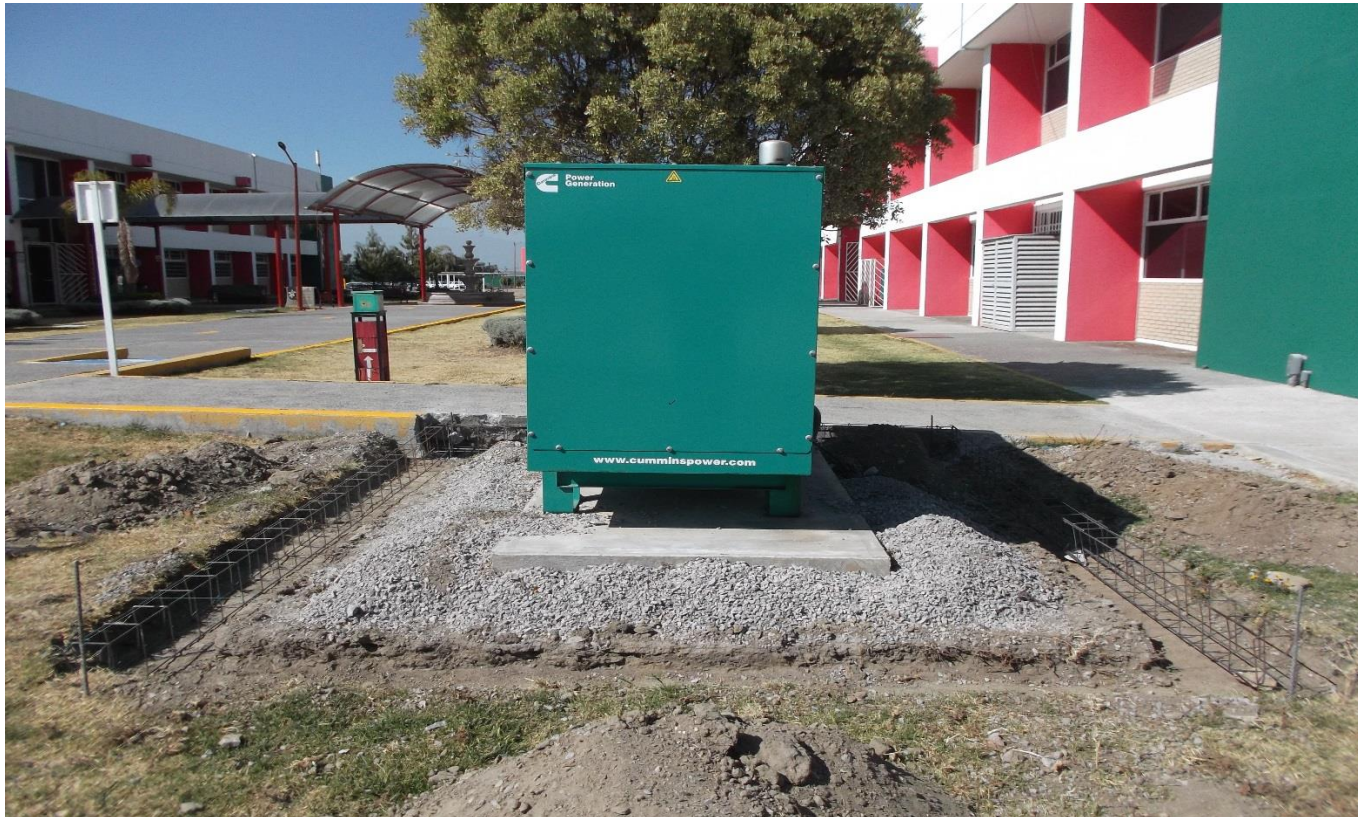
OBRA EXTERIOR: CONSTRUCCIÓN DE CADENA DE CONCRETO PARA RECIBIR CERCADO METÁLICO PARA LA PROTECCIÓN DE PLANTA DE EMERGENCIA
