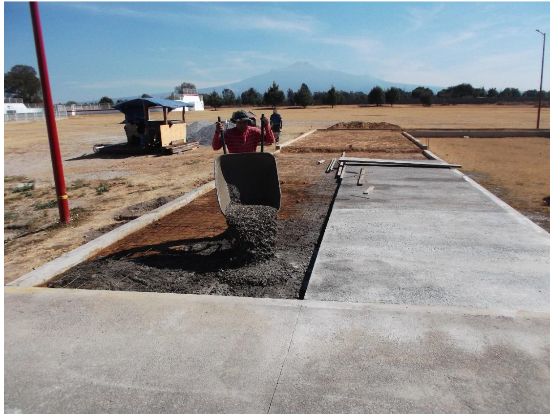
OBRA EXTERIOR: CONSTRUCCIÓN DE PISOS DE CONCRETO ARMADO CON MALLA METÁLICA PARA LA CONTINUACIÓN DEL ANDADOR PRINCIPAL.
