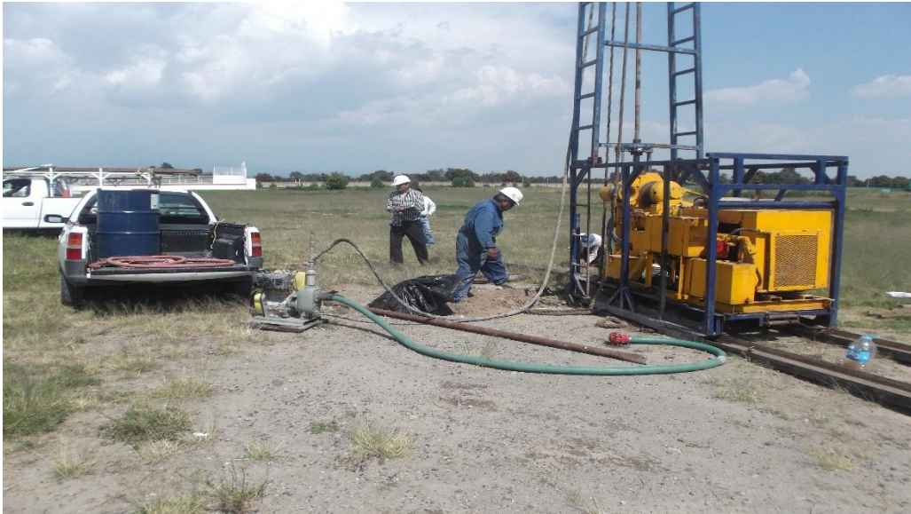
EQUIPO REALIZANDO SONDEO EXPLORATORIO EN EL ÁREA DONDE SE CONSTRUIRA EL EDIF. LT-3.
