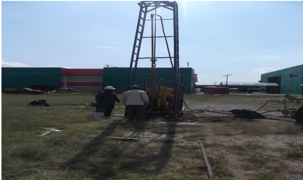
EQUIPO REALIZANDO SONDEO EXPLORATORIO EN EL ÁREA DONDE SE CONSTRUIRA EL EDIF. LT-3.
