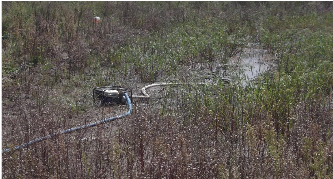
DESALOJO DE AGUA DE LLUVIA ACUMULADA CON BOMBA DE LODOS, EN EL LUGAR DE TRABAJO DEL LAGO .
