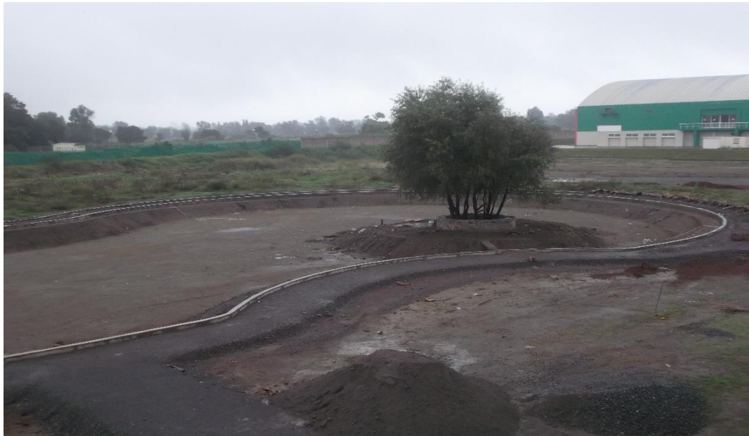
VISTA PANORAMICA DE CONSTRUCCION DE GUARNICIONES EN ANDADORES PERIMETRALES.
