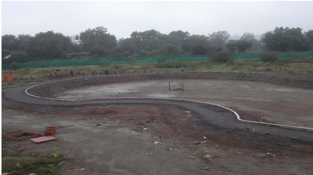
VISTA PANORAMICA DE CONSTRUCCION DE GUARNICIONES Y BASE HIDRAULICA EN ANDADORES.
