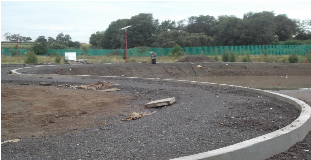
CONSTRUCCION DE GUARNICIONES PARA ANDADORES PERIMETRALES
