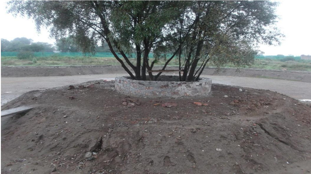
CONSTRUCCION DE ARRIATE DE PIEDRA PARA CONFINAR ARBOLES EXISTENTES
