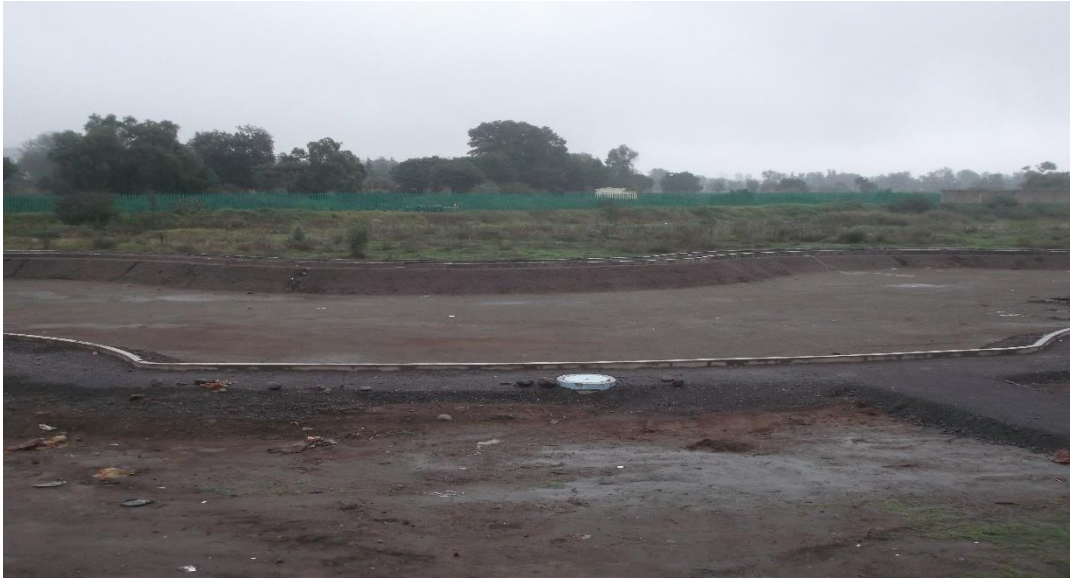
VISTA PANORAMICA DE CONSTRUCCION DE GUARNICIONES EN ANDADORES PERIMETRALES.
