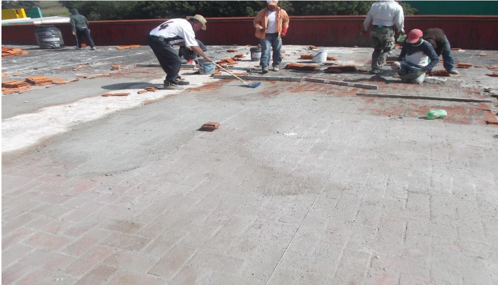
COLOCACION DE ENLADRILLADO EN LOSA DE AZOTEA EDIF. DE DOCENCIA UD-2.
