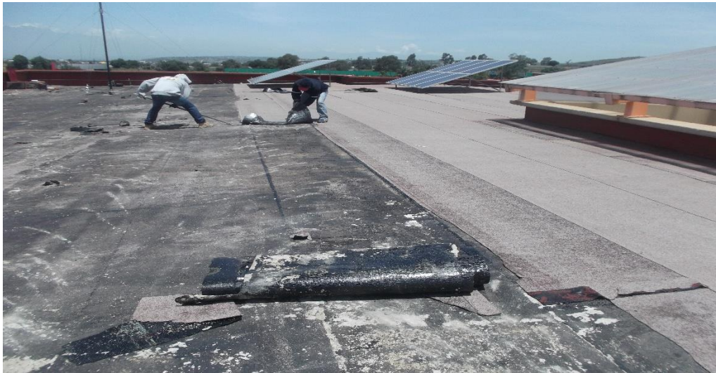
RETIRO DE MEMBRANA PREFABRICADA (VIDA UTIL AGOTADA) EDIF. DOCENCIA UD-2.
