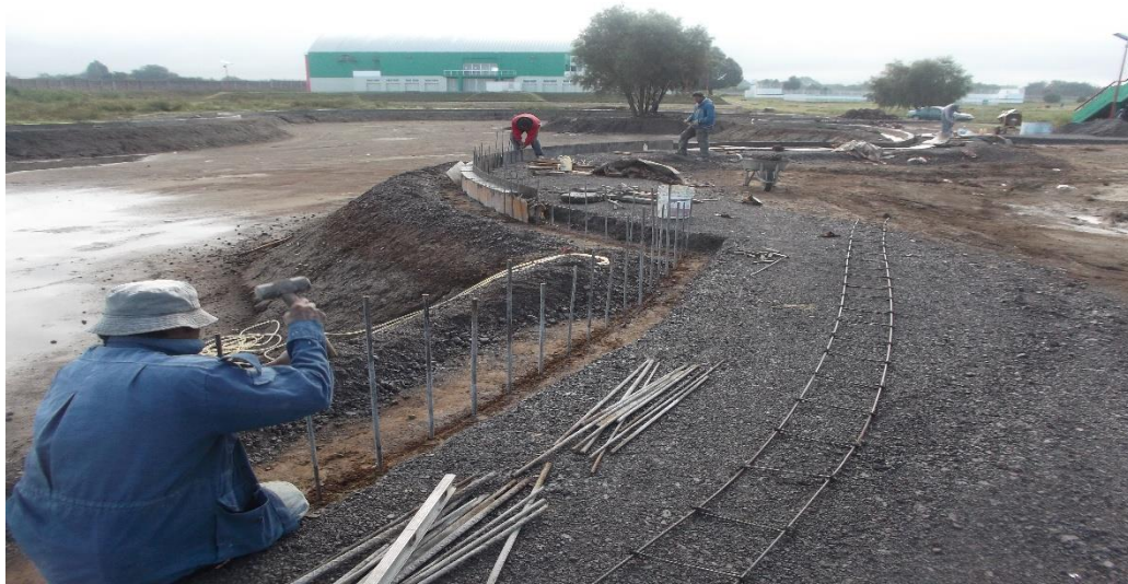
CONSTRUCCION DE GUARNICIONES Y BASE HIDRAULICA EN ANDADORES PERIMETRALES.
