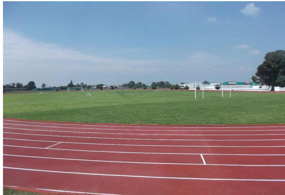
COLOCACION DE PASTO NATURAL EN CANCHA DE FUTBOL SOCCER.
