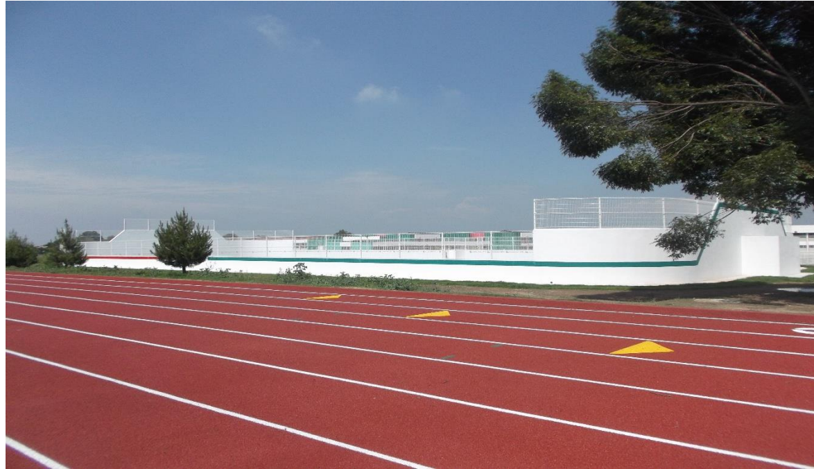
CONSTRUCCION DE CANCHA DE FUTBOL RAPIDO.
