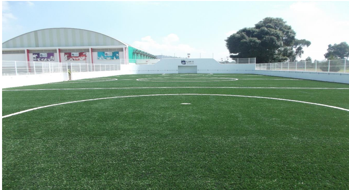
COLOCACION DE PASTO SINTETICO EN CANCHA DE FUTBOL RAPIDO
