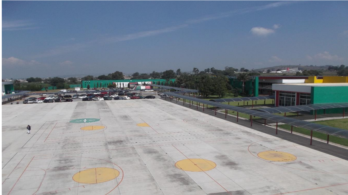
VISTA PANORAMICA DE LA CUBIERTA PLASTICA DE POLICARBONATO EN ANDADORES EXTERIORES.
