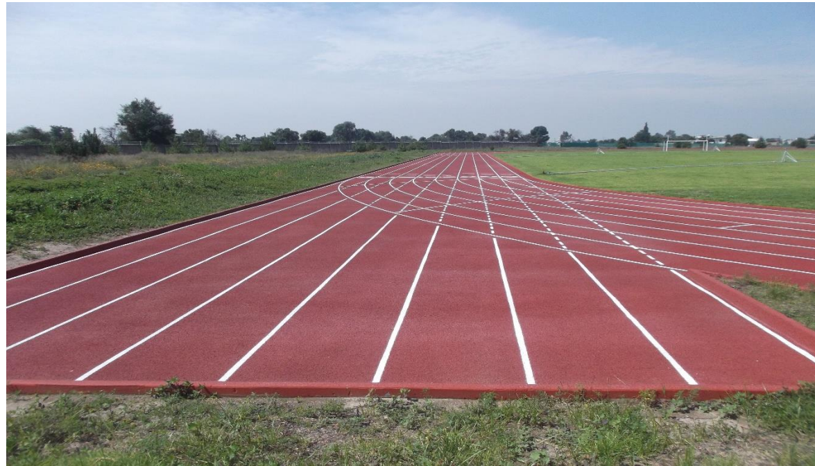
COLOCACION DE CARPETA SINTETICA EN PISTA DE ATLETISMO.
