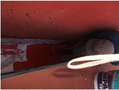
TRABAJOS DE APLICACIÓN DE IMPERMEABLIZANTE POR MEDIO DE TERMOFUCIÓN DE 4 MM DE ESPESOR EN EDIFICIO DE DOCENCIA UD-4
