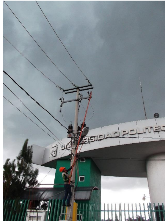
SE SUBEN LAS CUCHILLAS EN LA LINEA DE C.F.E. PARA LA REANUDACION DEL SERVICIO DE ENERGIA ELECTRICA A LA U.P.T.
