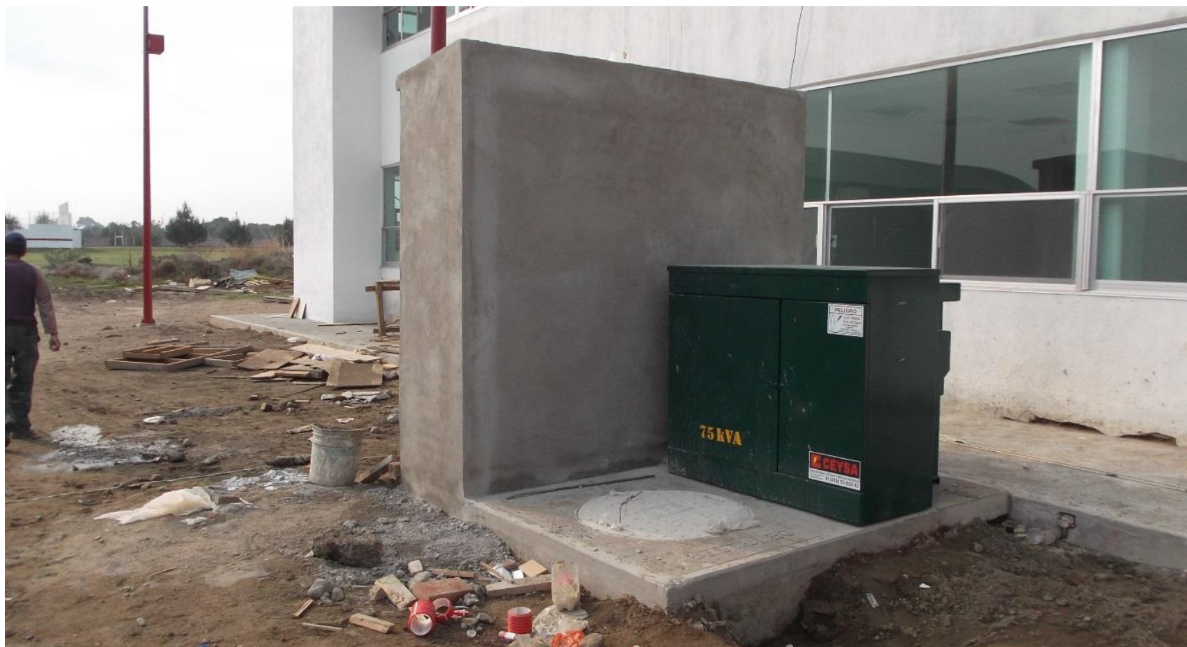
SUMINISTRO DE TRANSFORMADOR TIPO PEDESTAL DE 75 KVA. CONEXIÓN ESTRELLA-ESTRELLA DEVANADO.
