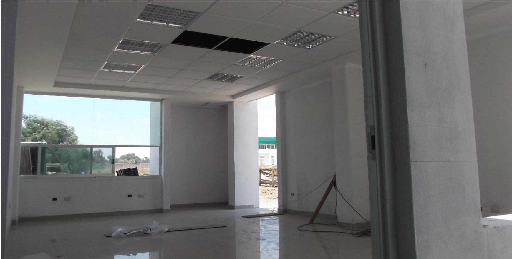
COLOCACION DE LOSETA DE CERAMICA EN PISOS, FALSO PLAFON Y LUMINARIOS TIPO LED DE EMPOTRAR
