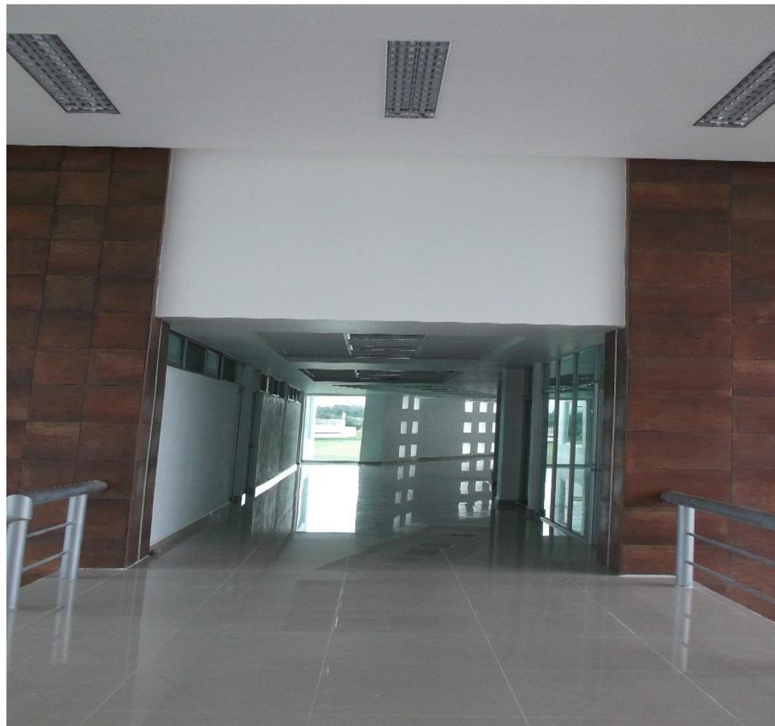
LIMPIEZA INTERIOR DEL EDIFICIO.
