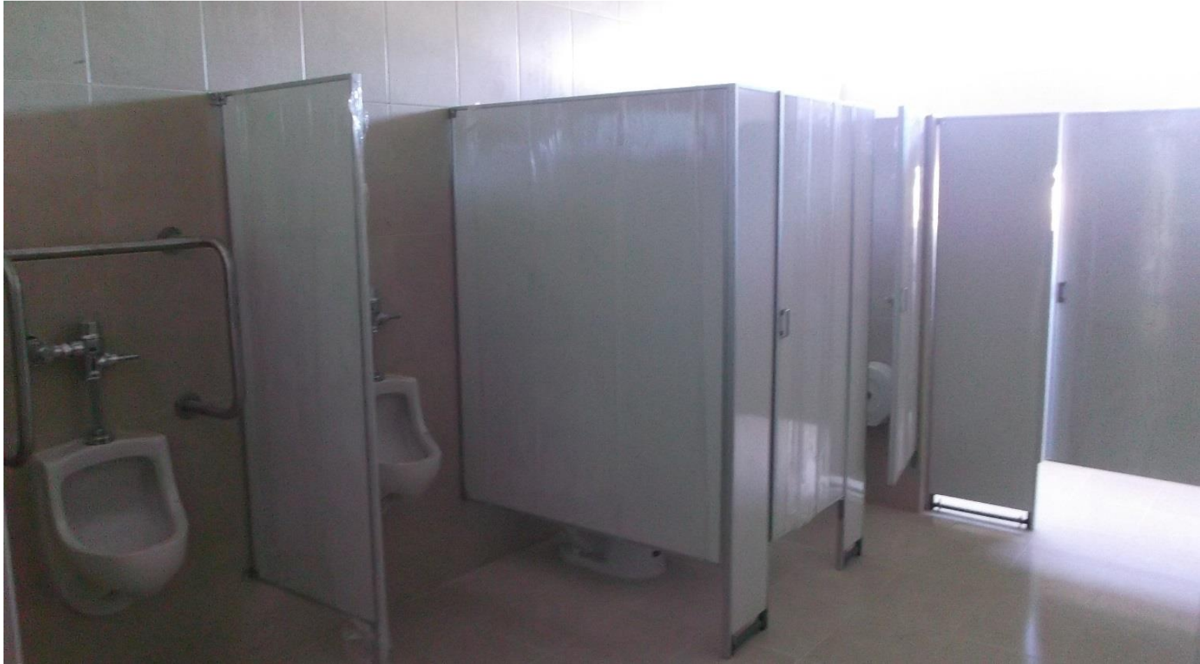
COLOCACION DE MAMPARAS EN BAÑOS HOMBRES PLANTA ALTA Y BAJA
