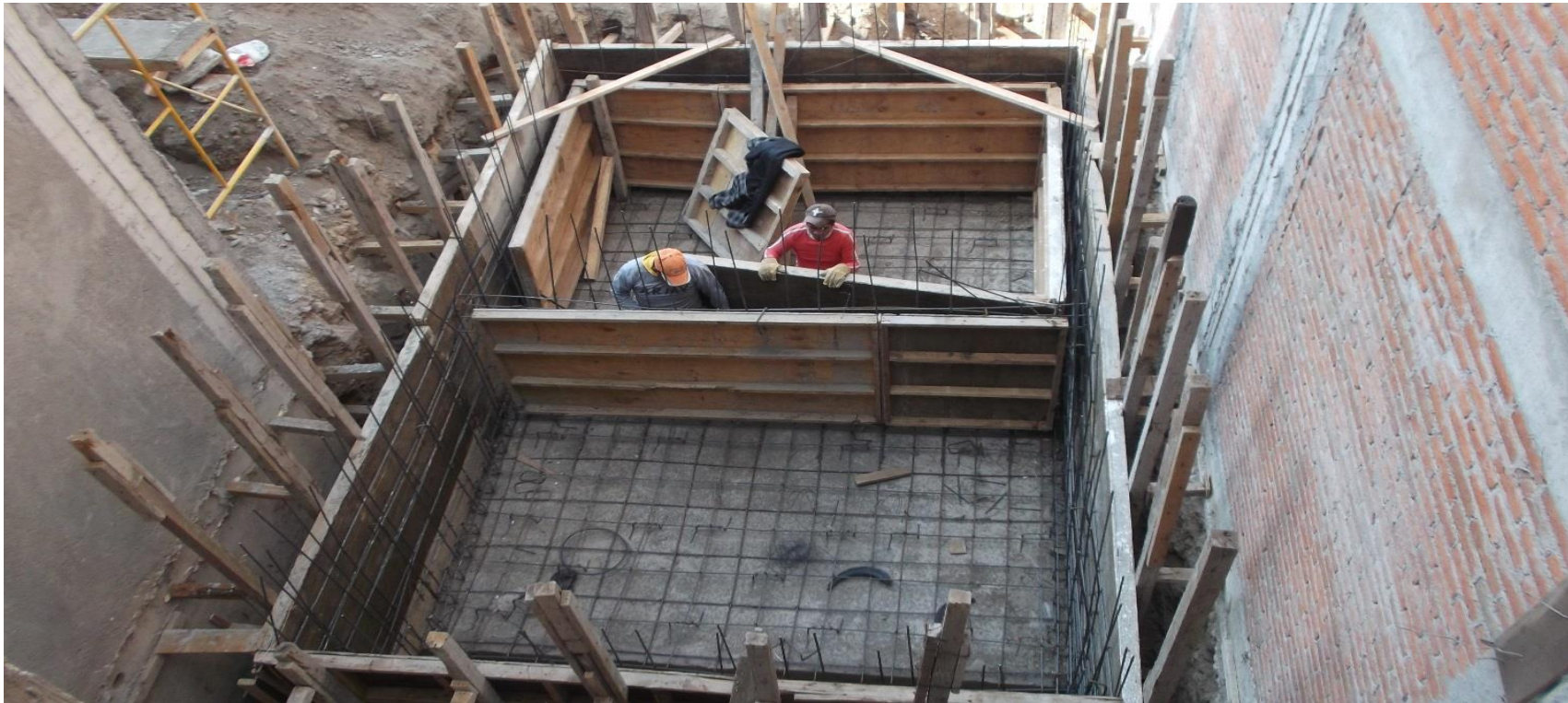
COLOCACIÓN DE ACERO DE REFUERZO EN LOSA Y MUROS DE CISTERNA CAPACIDAD 20 M3.
