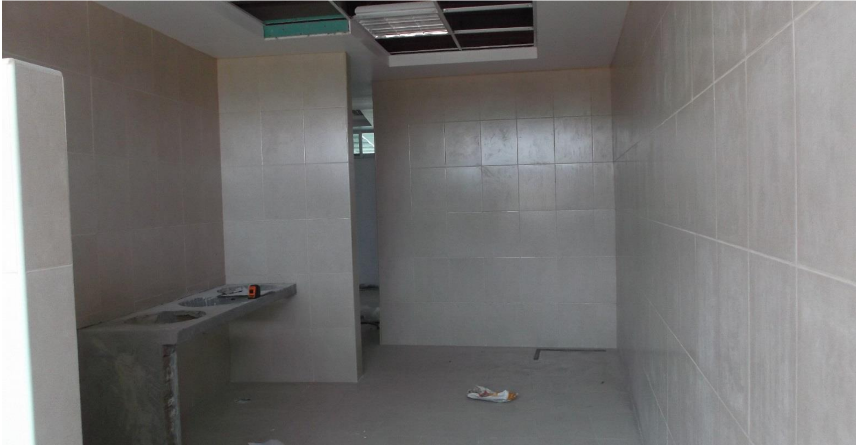
COLOCACIÓN DE LOSETA DE CERÁMICA EN MUROS DE SERVICIOS SANITARIOS PLANTA BAJA
