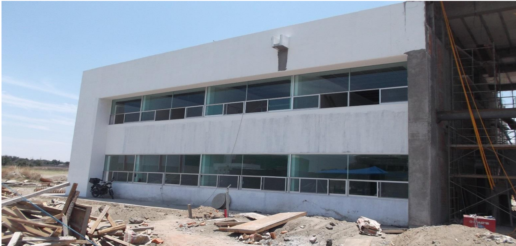
SUMINISTRO Y COLOCACIÓN DE CANCELERÍA DE ALUMINIO Y VIDRIOS TINTEX EN EXTERIORES
