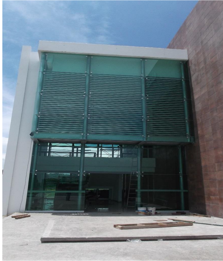
COLOCACIÓN DE ESTRUCTURA METÁLICA Y VIDRIO TEMPLADO TINTEX DE 9 MM. DE ESPESOR EN FACHADA PRINCIPAL.
