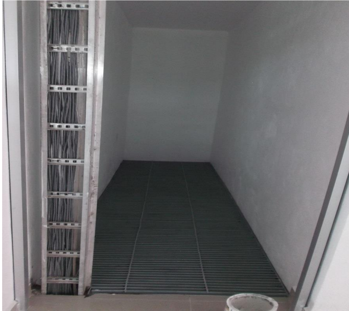
COLOCACIÓN DE REJILLA TIPO IRVING EN DUCTO PLANTA ALTA.
