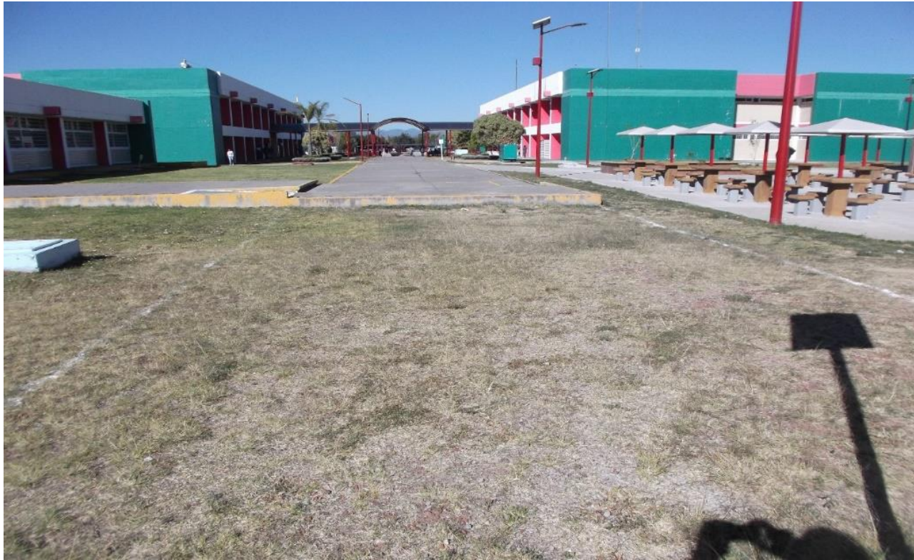
OBRA EXTERIOR: TRAZO Y NIVELACION DE ANDADOR PRINCIPAL PARALELO A LA EXPLANADA DEL EDIFICIO UD-5
