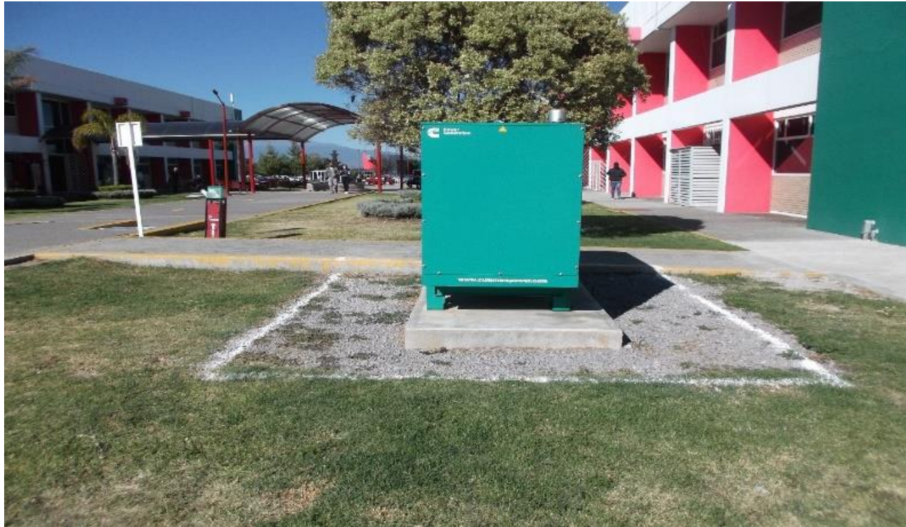
OBRA EXTERIOR: TRAZO Y NIVELACION PARA LA BARRA DE PROTECCION DE LA PLANTA DE EMERGENCIA
