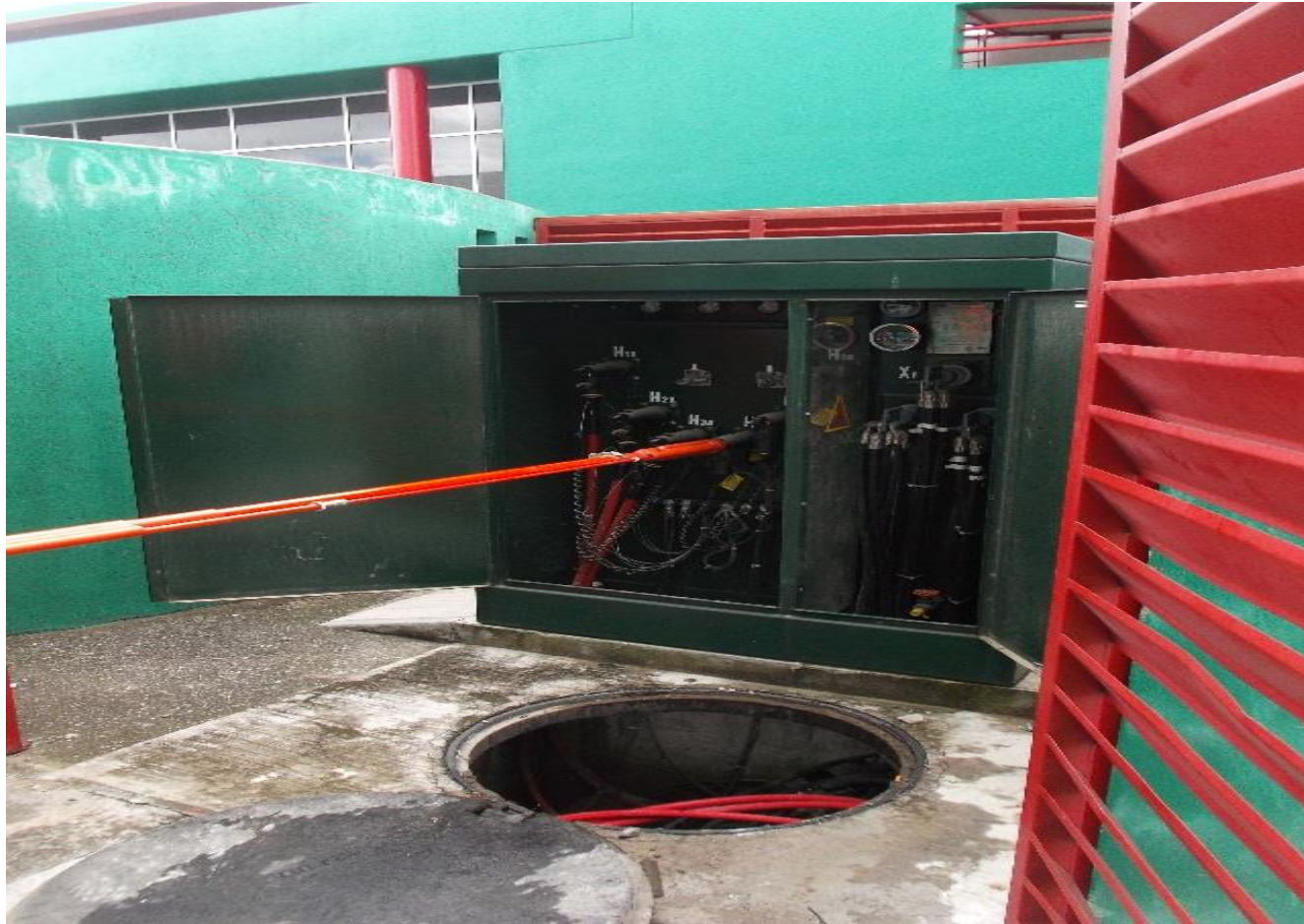
RETIRO DE CODOS TAPON DE MEDIA TENSION DEL LA SUBESTACION DE 500 KVA EXISTENTE
