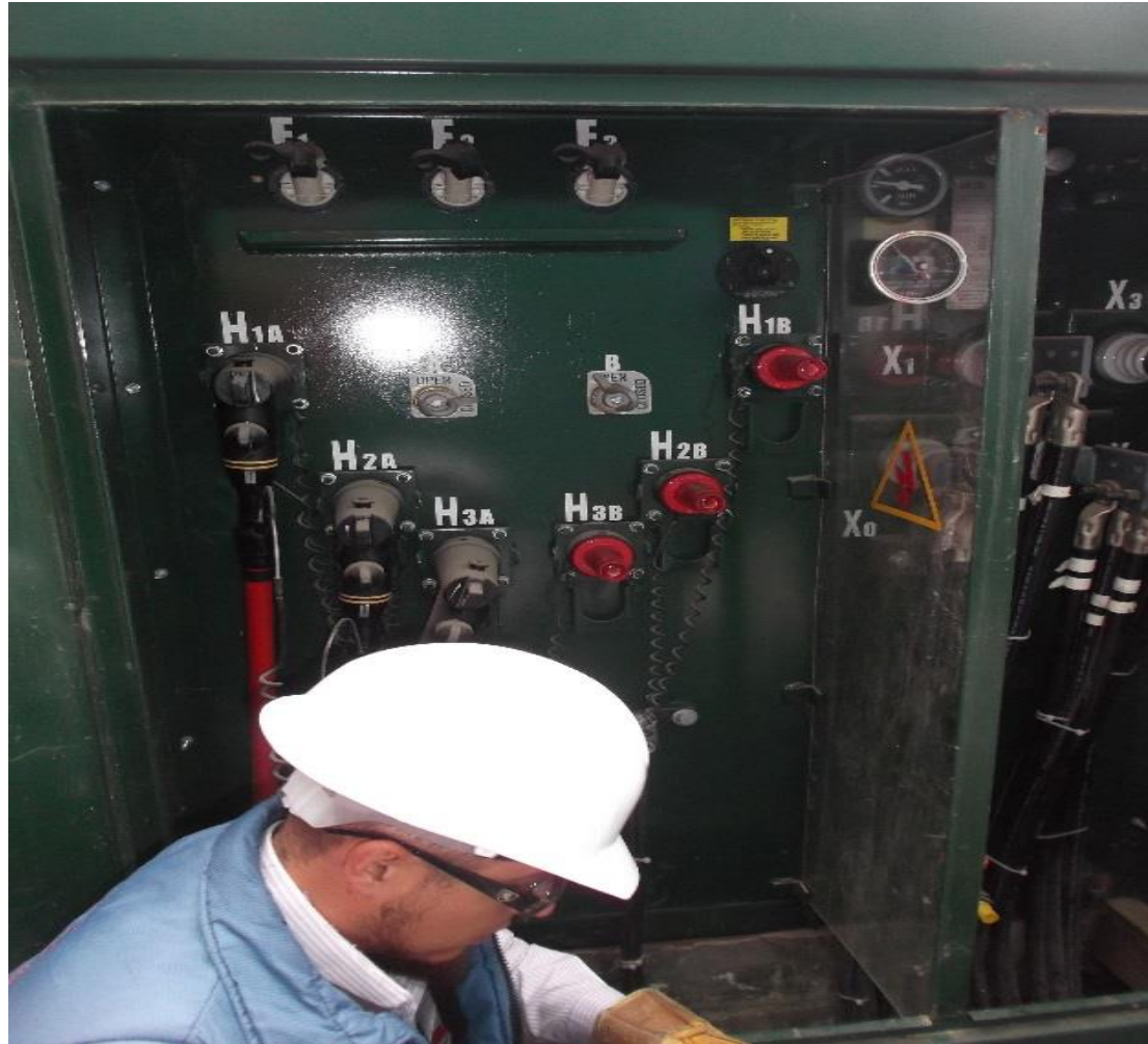
RETIRO DE INSERTOS DE 15 KVA. DE SUBESTACION DE 500 KVA. EXISTENTE.
