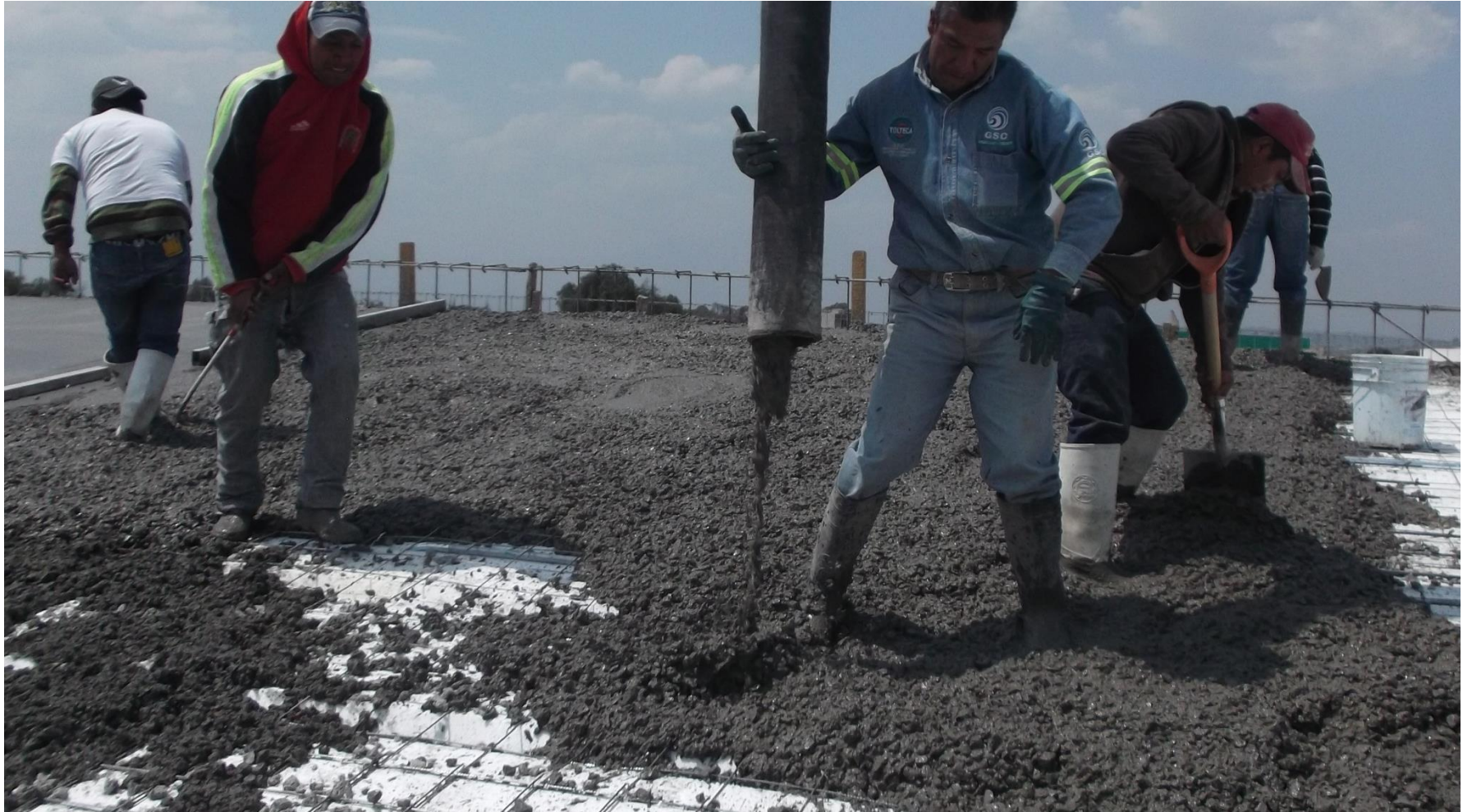
VACIADO DE CONCRETO PREMEZCLADO F' C = 250 KG/CM2 EN LOSA
