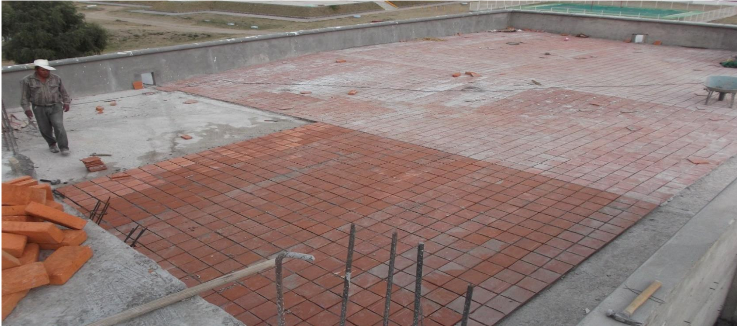
COLOCACION DE ENLADRILLADO EN LOSA DE AZOTEA
