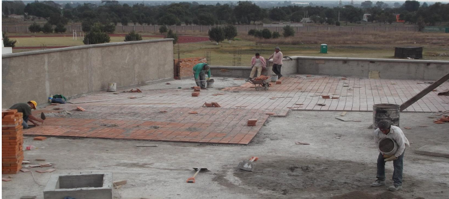
COLOCACION DE ENLADRILLADO EN LOSA DE AZOTEA.
