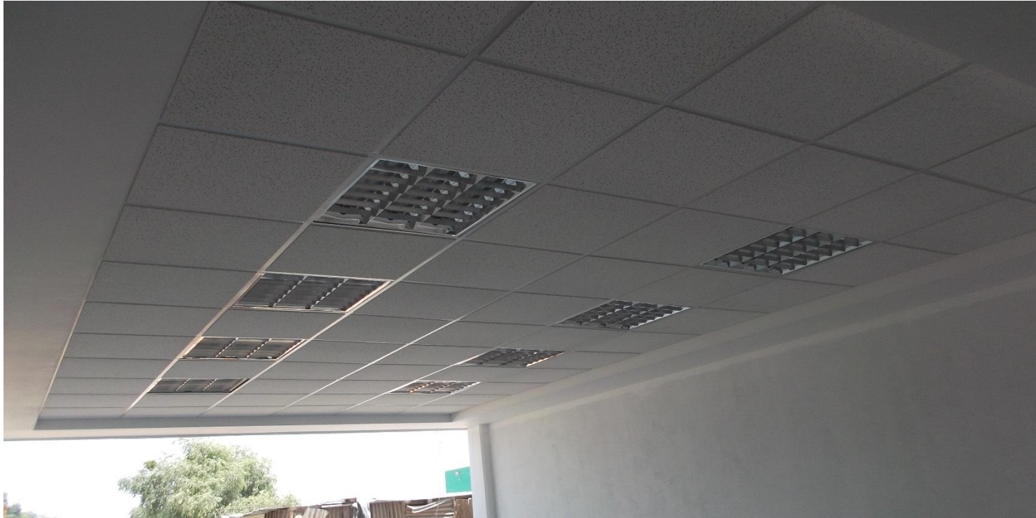
COLOCACION DE PLAFON RETICUAR Y LUMINARIAS TIPO LEDS EN PLANTA BAJA.
