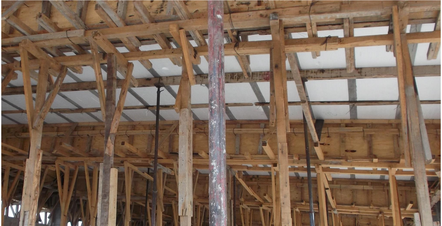
CIMBRA EN TRABES Y LOSA LISTA PARA RECIBIR CONCRETO PREMEZCLADO F'c = 250 \text{ KG/CM}^2
