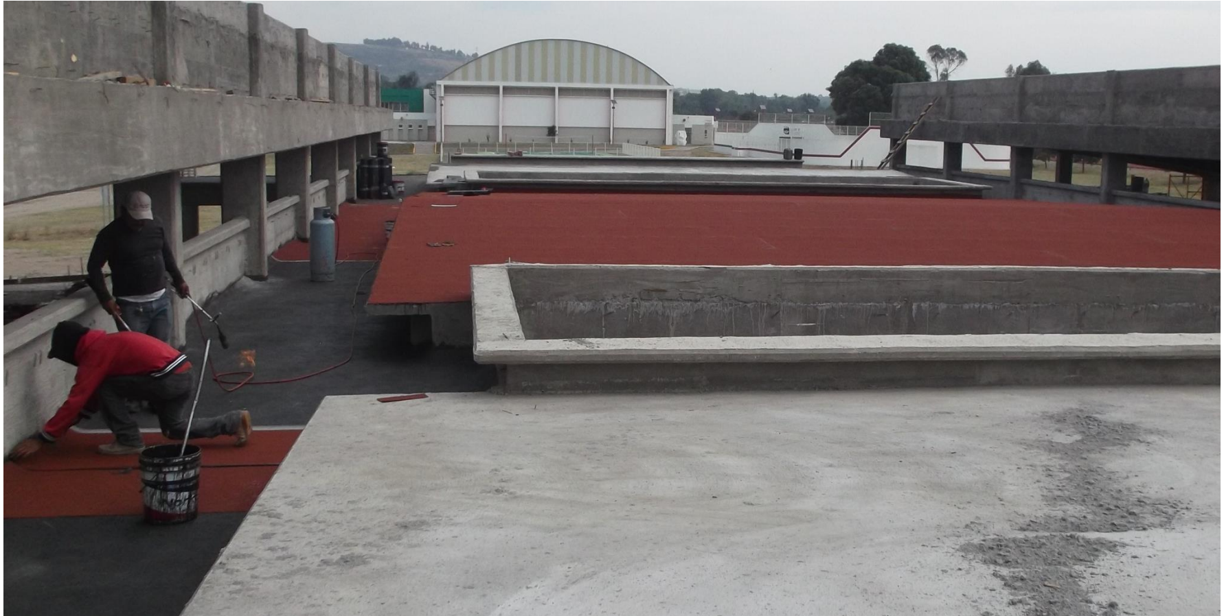
TRABAJOS DE IMPERMEABILIZACIÓN CON MENBRANA GRANULAR ROJO DE POLIPROPILENO ATÁCTICO EN LOSA DE AZOTEA CON CARPETA ASFÁLTICA GRANULAR DE 3.5 MM
