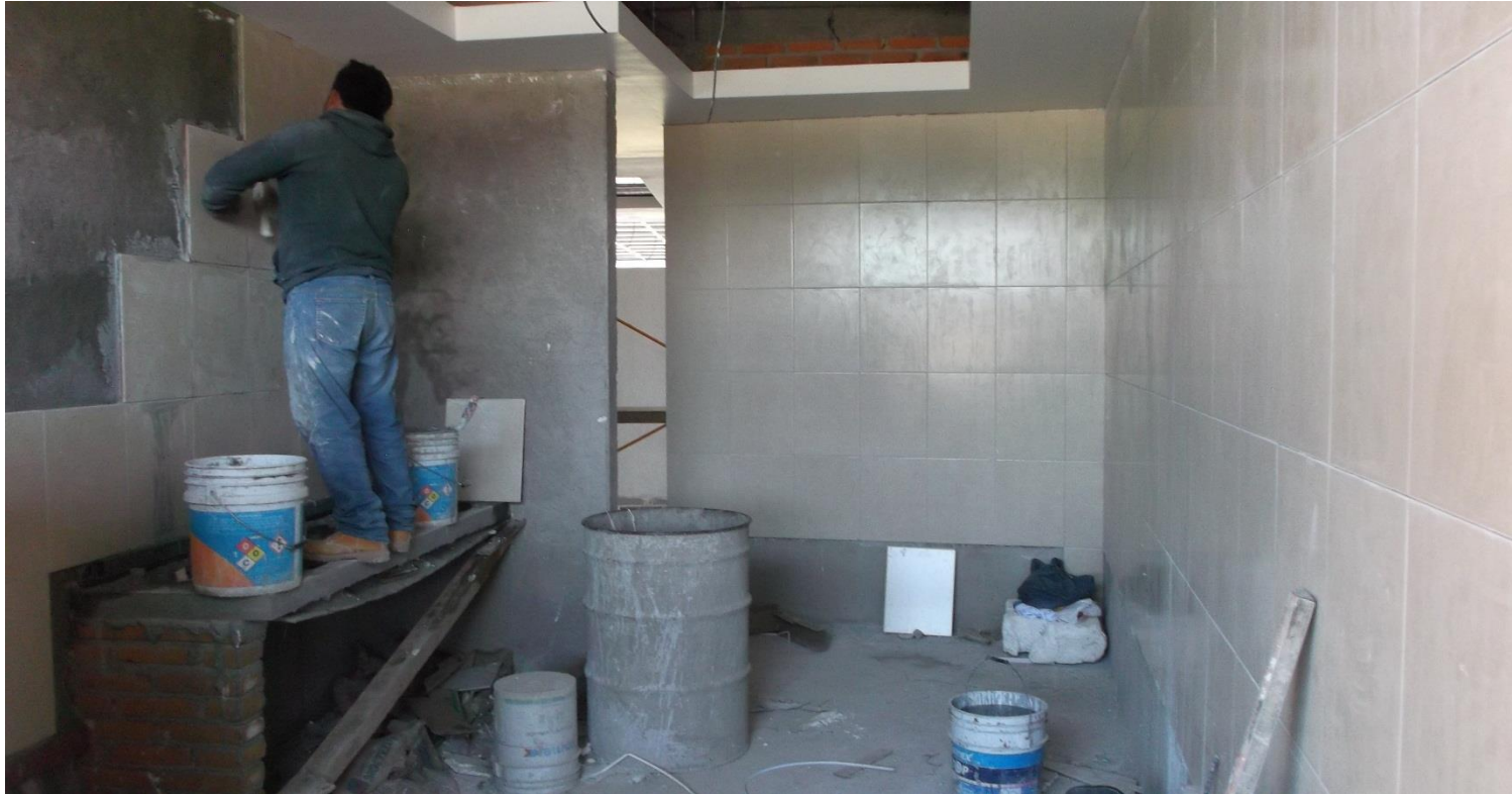
COLOCACION DE LOSETA DE CERAMICA EN MUROS DE SERVICIOS SANITARIOS PLANTA BAJA.
