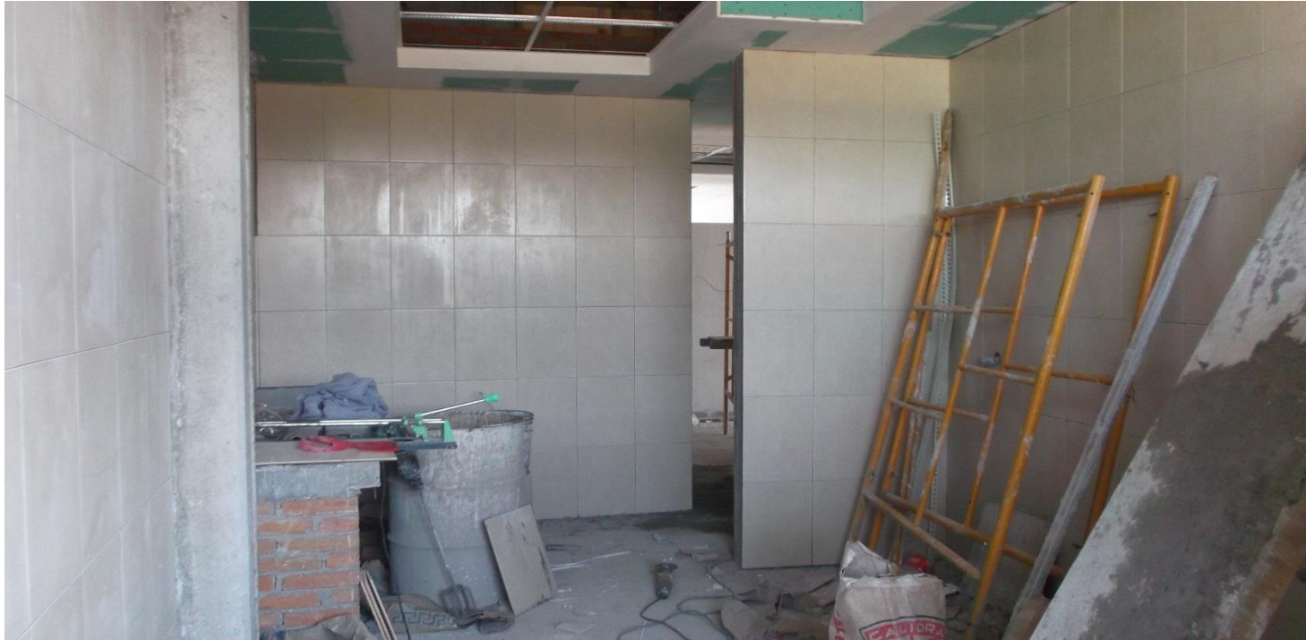
COLOCACION DE LOSETA DE CERAMICA EN MUROS DE SERVICIOS SANITARIOS PLANTA BAJA.
