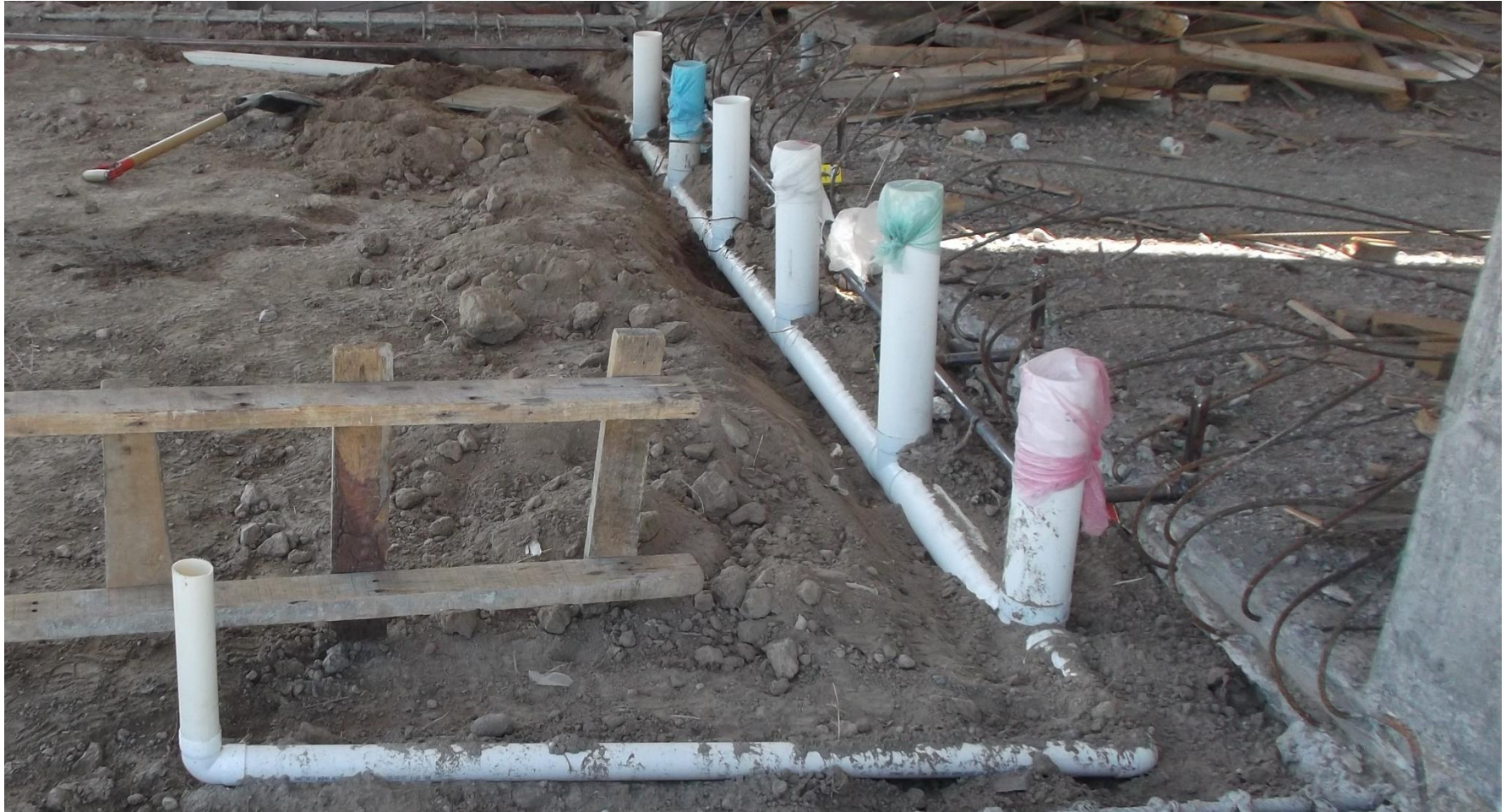
TRABAJOS DE INSTALACIÓN SANITARIA E HIDRÁULICA EN BAÑOS.
