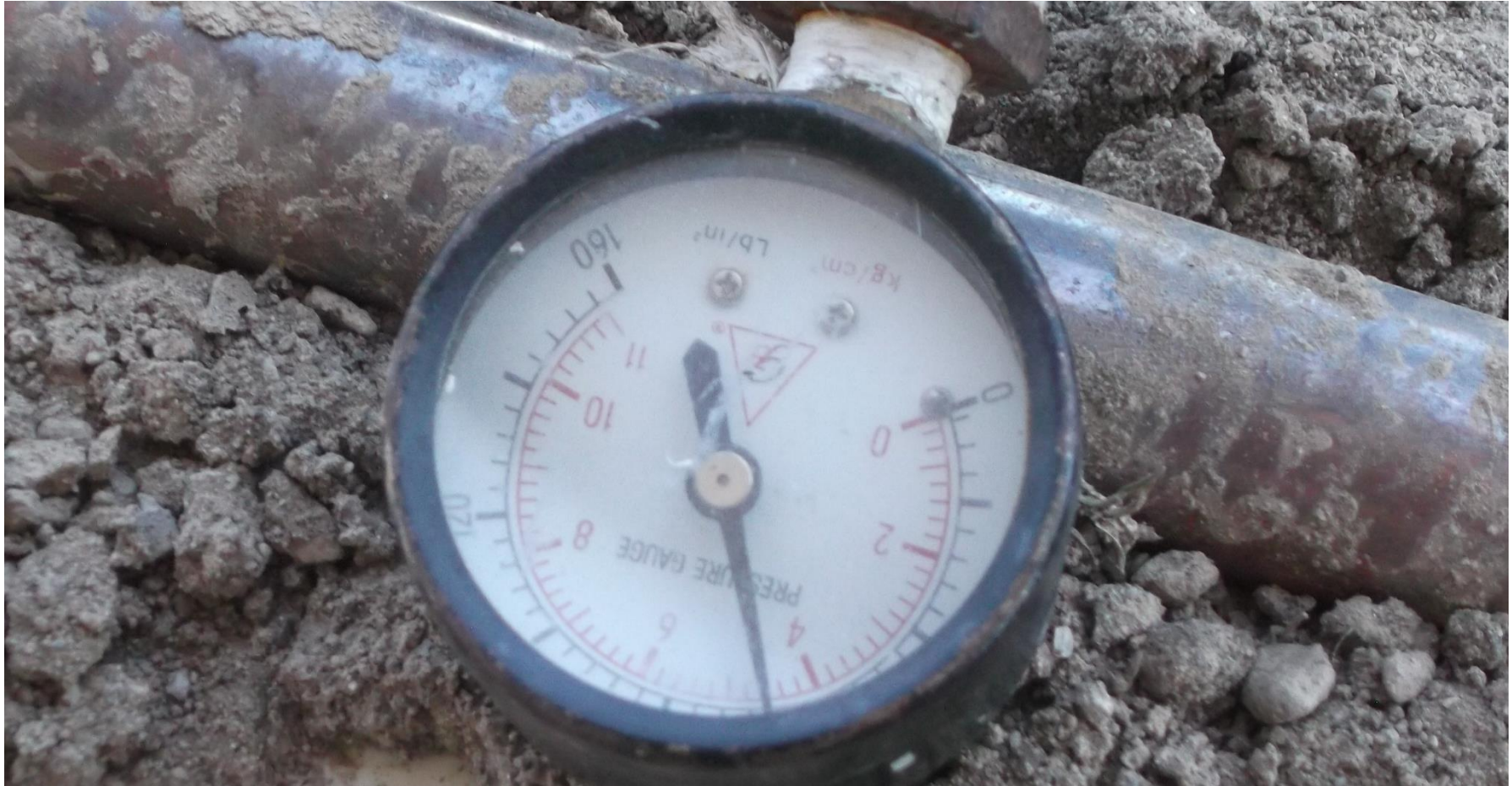
APLICACIÓN DE PRUEBA HIDROSTÁTICA EN INSTALACIÓN HIDRÁULICA PARA DETECTAR FUGAS.
