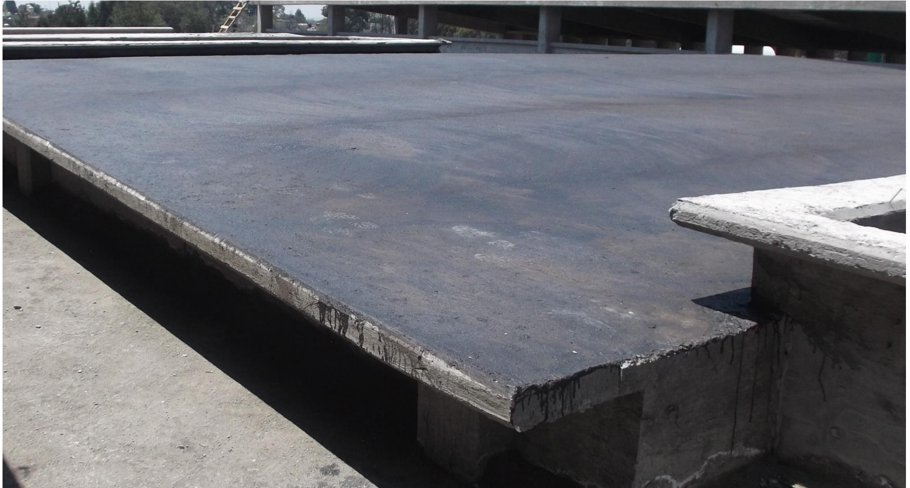
TRABAJOS DE IMPERMEABILIZACIÓN EN LOSA COMO PREPARACIÓN PARA RECIBIR MENBRANA GRANULAR ROJO DE 3.5 MM
