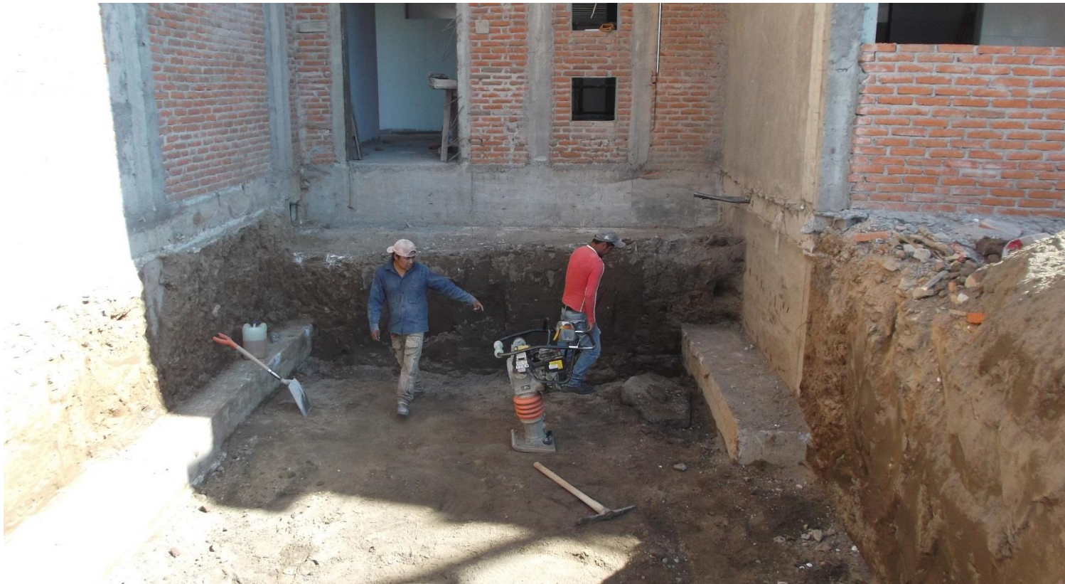
EXCAVACION PARA ALOJAR CISTERNA DE AGUA POTABLE CAPACIDAD 20 M3.
