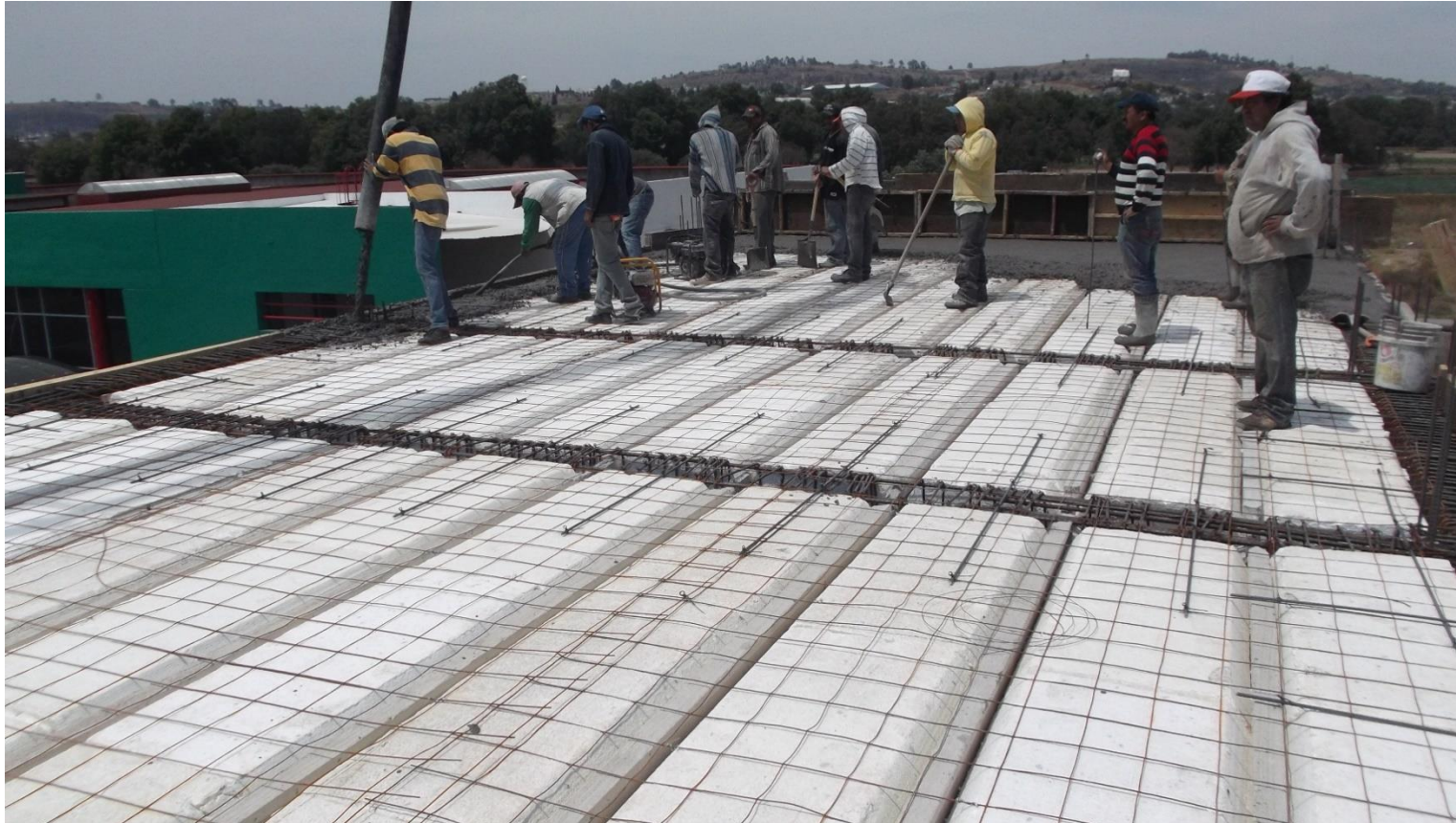
COLOCACION DE VIGUETAS PRETENSADAS Y VOBEDILLAS DE POLIESTIRENO EN LOSA DE AZOTEA TERCERA ETAPA. N+ 9.80 M.
