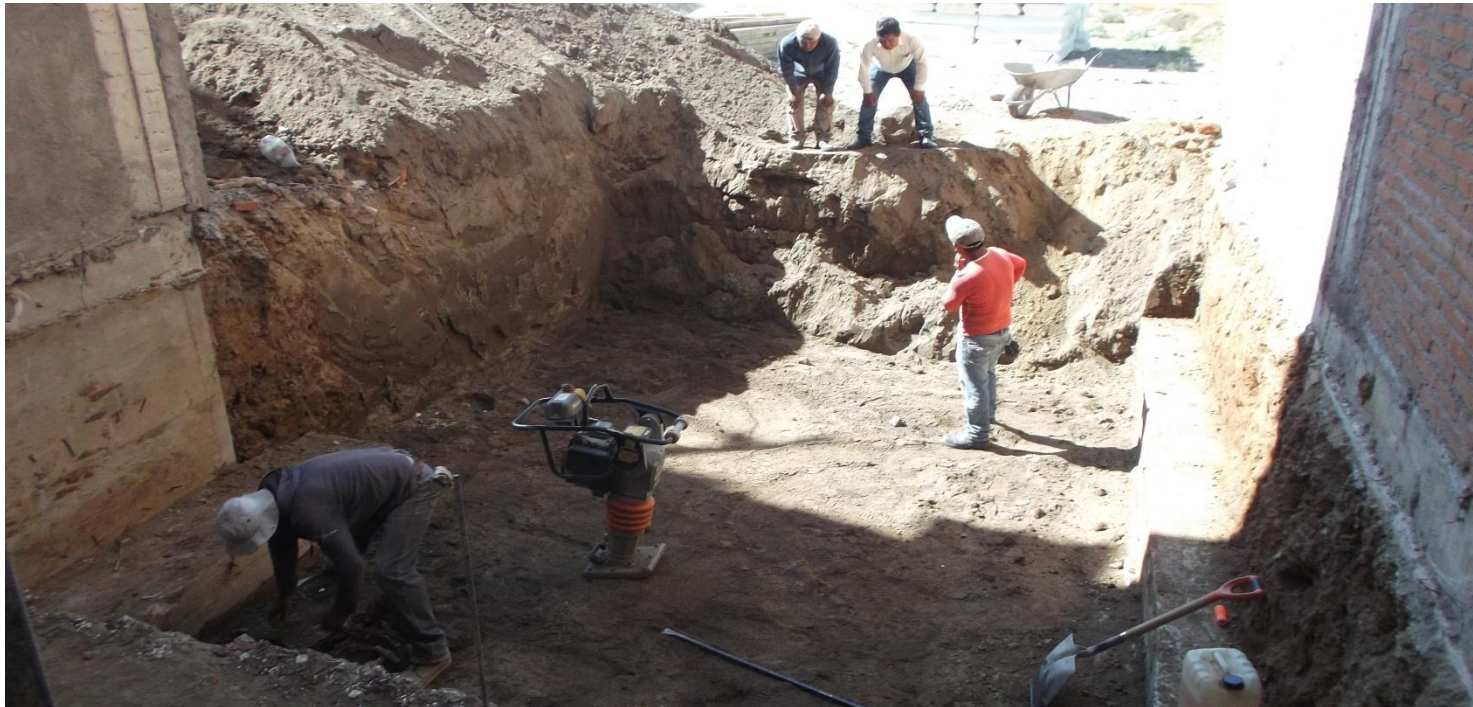
EXCAVACION PARA ALDOJO DE CISTERNA CAPACIDAD 20 M3.
