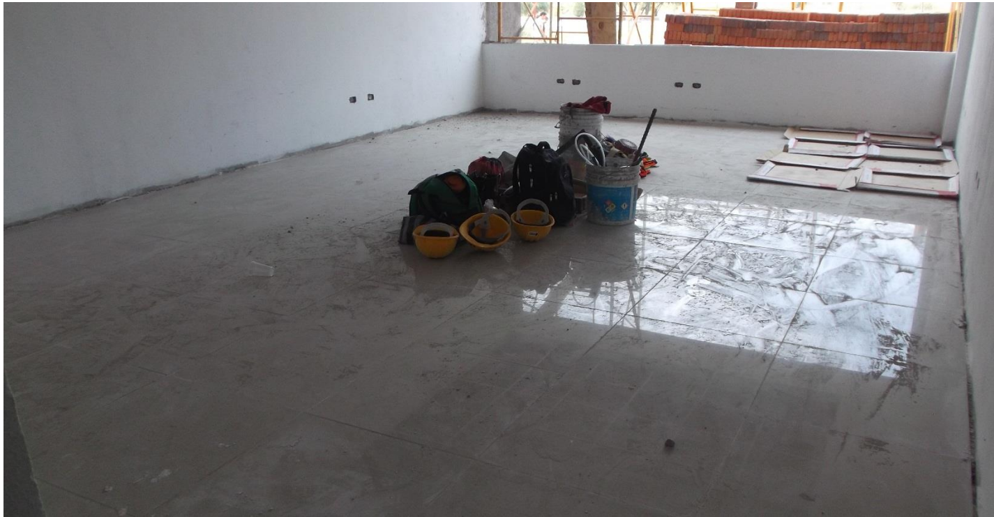
COLOCACION DE LOSETA DE CERAMICA EN PISOS DE PLANTA BAJA.
