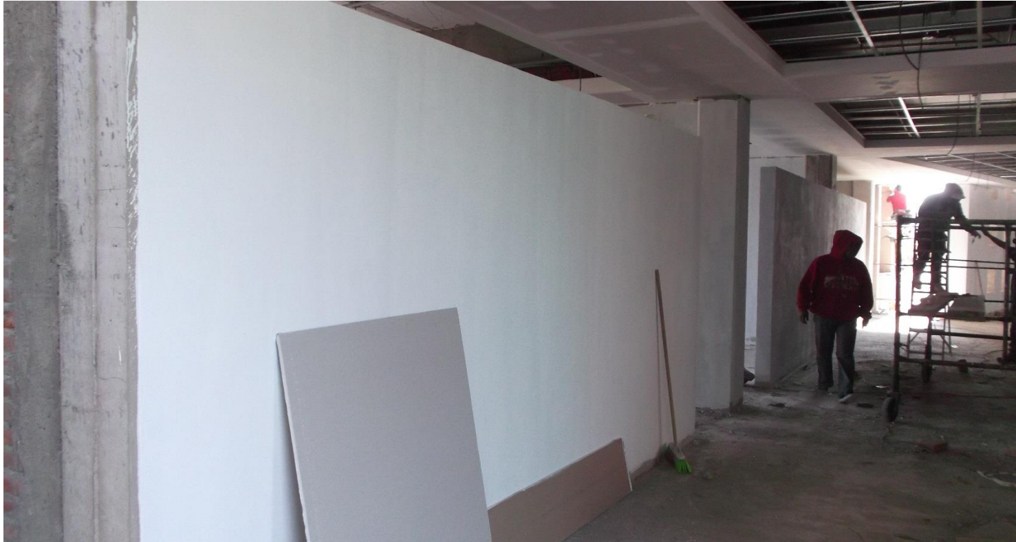
APLICACIÓN DE SELLADOR EN MUROS (FONDEO) PARA RECIBIR PINTURA VINILICA.
