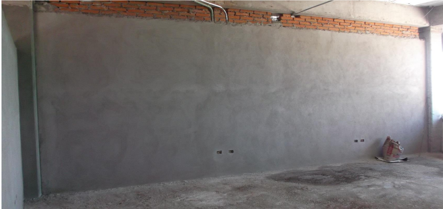
APLANADO EN MUROS DE PLANTA ALTA.
