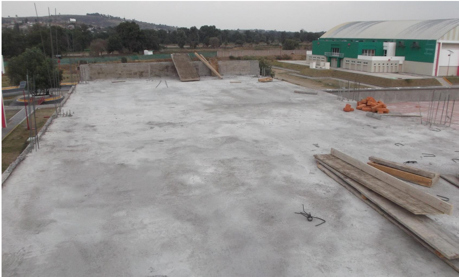
COLADO DE LOSA DE LOSA DE AZOTEA TERCERA ETAPA NIVEL + 9.80 M.
