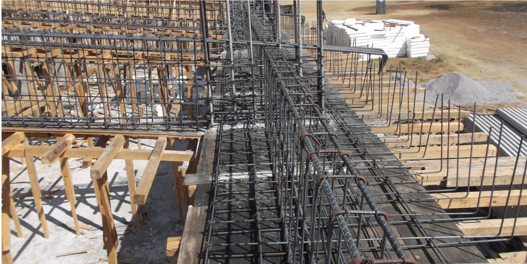
CIMBRADO Y HABILITADO DE ACERO EN TRABES Y FALDÓN.
