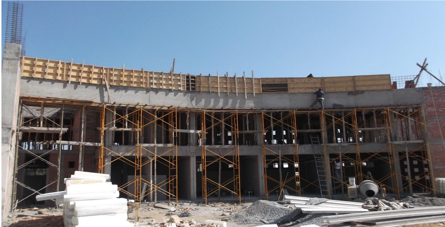
CIMBRADO DE PRETILES DE CONCRETO EN LOSA DE AZOTEA.
