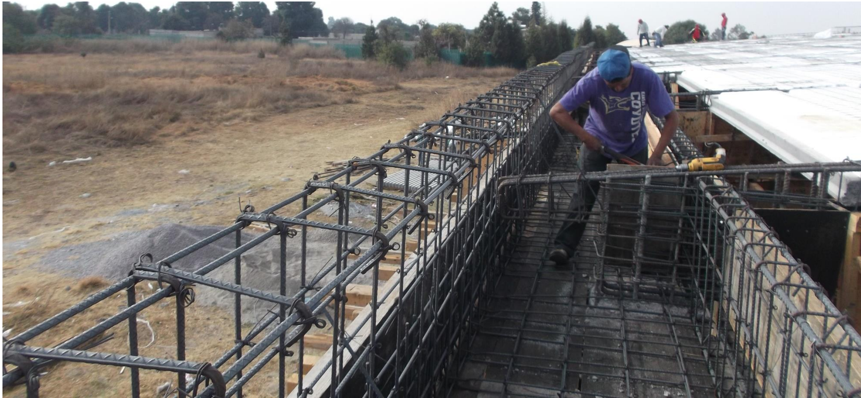
DETALLANDO CARPINTERÍA EN FALDÓN Y TRABE PARA RECIBIR CONCRETO.
