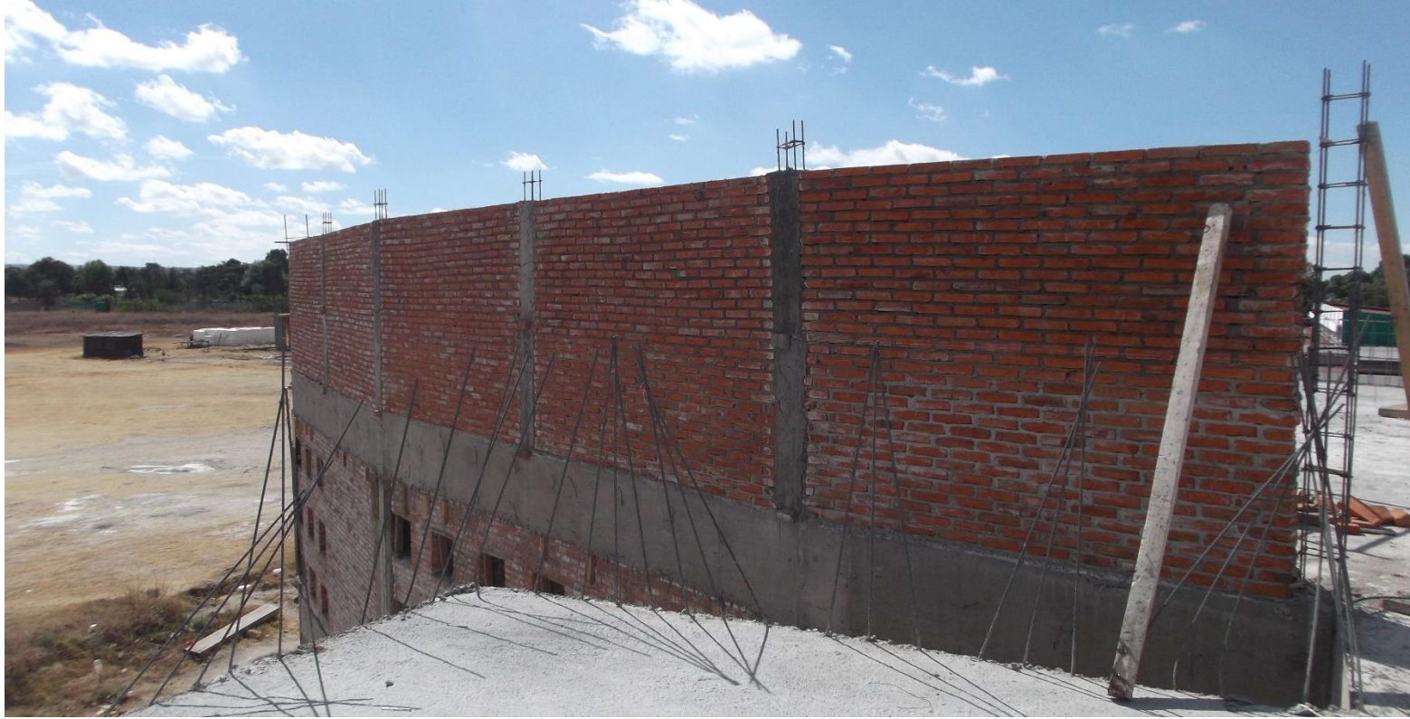
CONSTRUCCIÓN DE MURO PRETEL EN LOSA DE AZOTEA.
