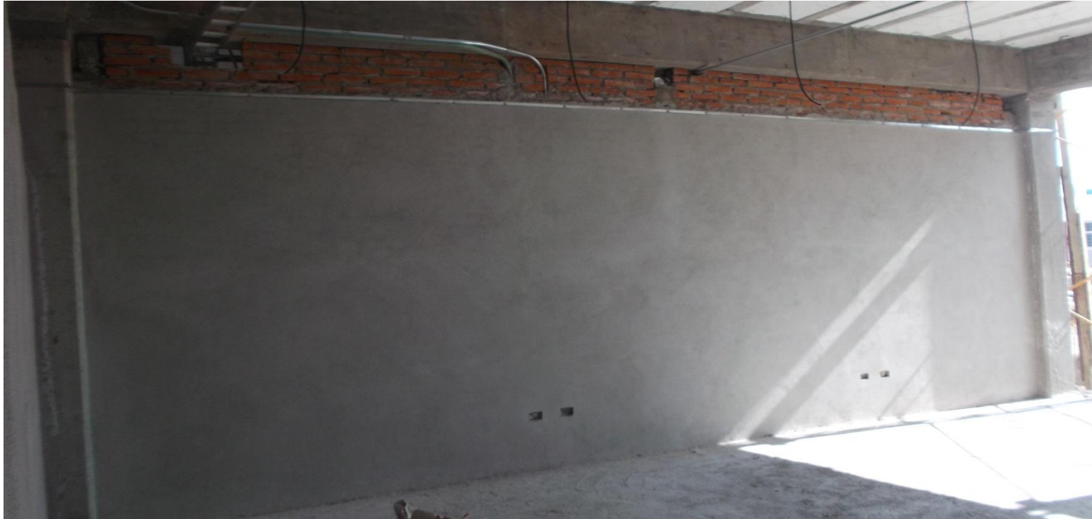
APLANADOS DE MEZCLA EN MUROS INTERIORES DE PLANTA BAJA.
