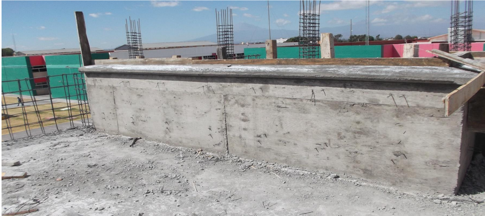
COLADO DE PRETILES EN LOSA DE AZOTEA.
