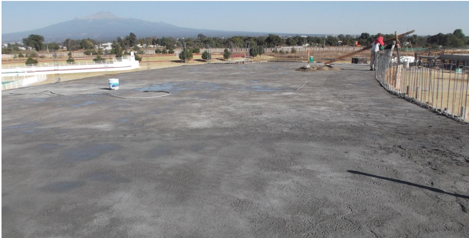
AFINE DE LOSA DE AZOTEA PARA RECIBIR IMPERMEABILIZANTE.
