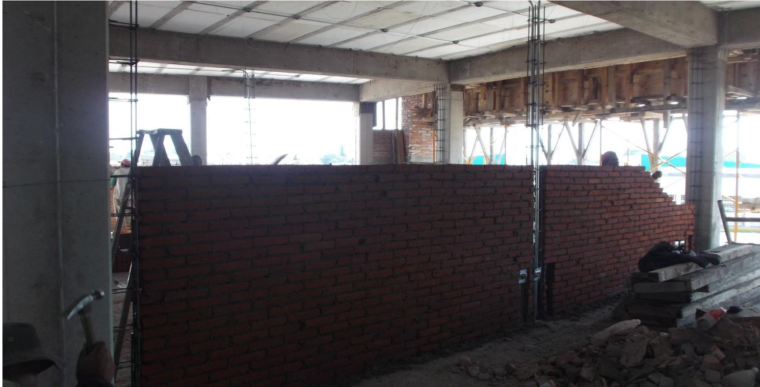
DESPLANTE DE MUROS INTERIORES EN PLANTA ALTA.
