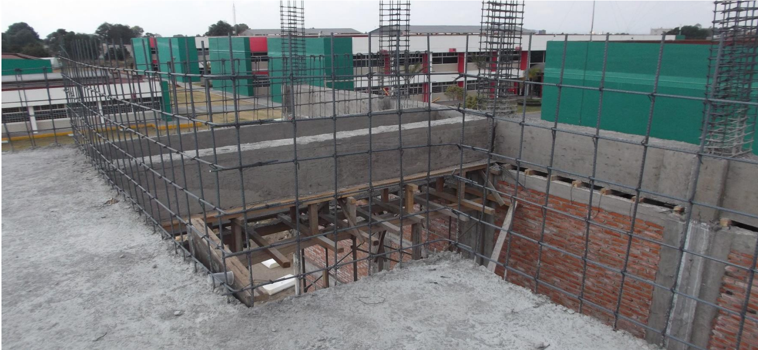
ARMADO DE PRETILES EN LOSA DE AZOTEA CON VARILLA DEL NO. 3 EN AMBOS SENTIDOS.
