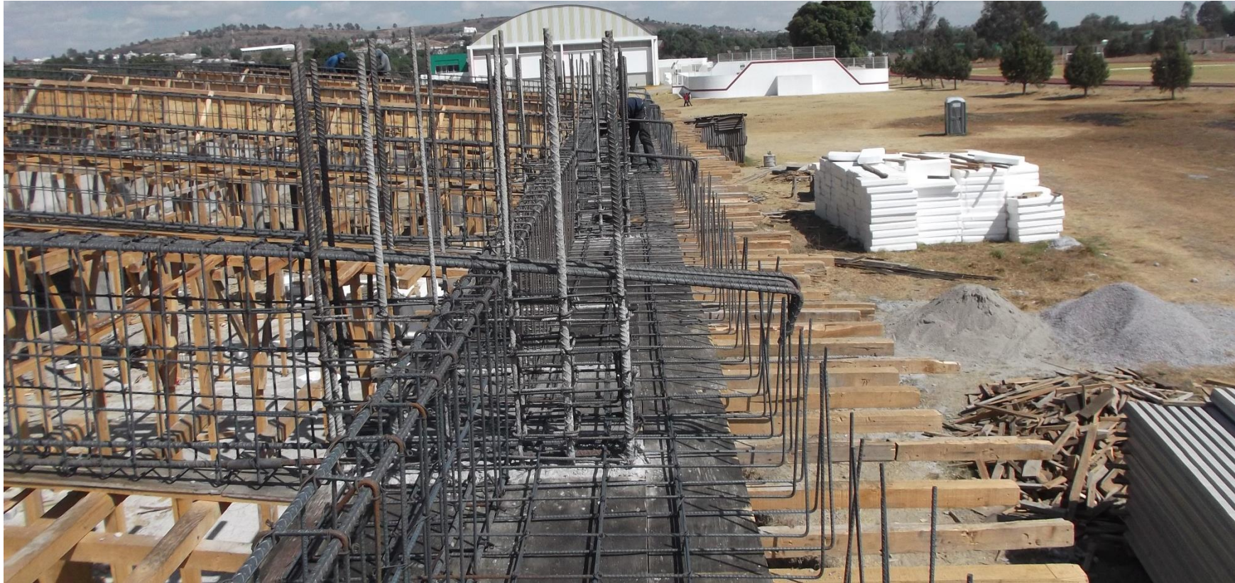
ACERO EN FALDÓN, A UN COSTADO VIGUETAS PRETENSADAS Y CASETONES DE POLI ESTIRENO PARA CONSTRUCCIÓN DE LOSA.
