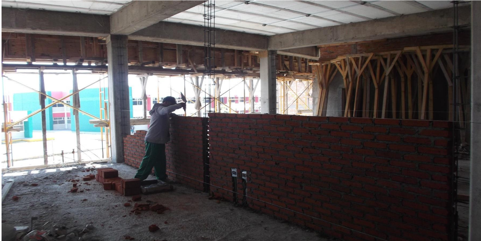
DESPLANTE DE MUROS INTERIORES EN PLANTA ALTA.
