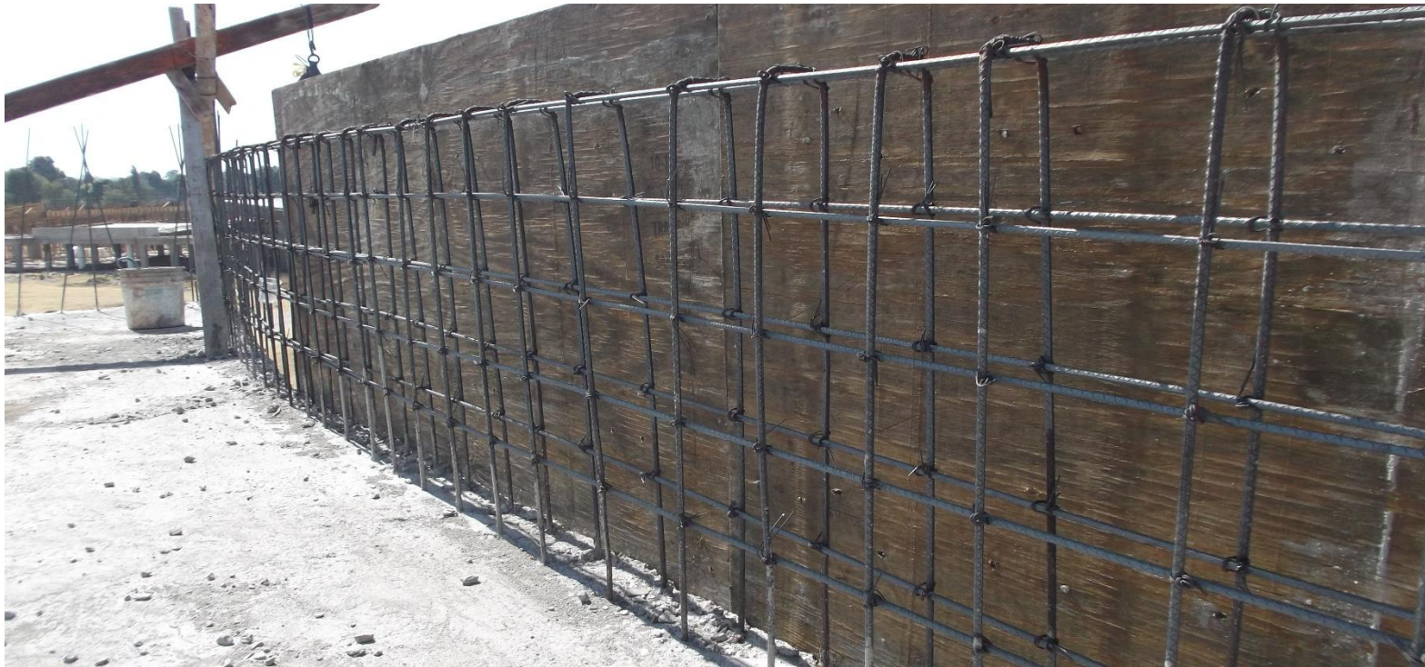
CIMBRADO DE COSTADOS Y ARMADO CON ACERO DE REFUERZO EN PRETILES DE LOSA DE AZOTEA.
