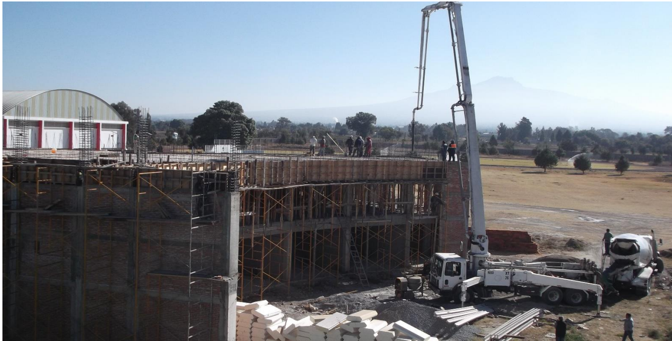
COLADO DE LOSA DE AZOTEA CON CONCRETO Premezclado y bombeado. F' C=250 KG/CM2.
