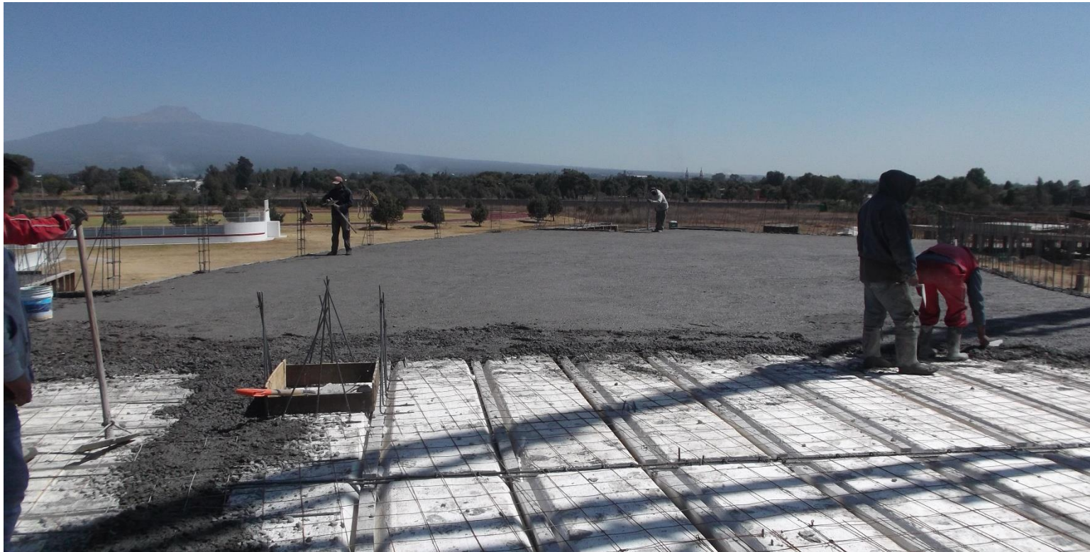
PROCESO DEL COLADO DE LOSA DE AZOTEA.
