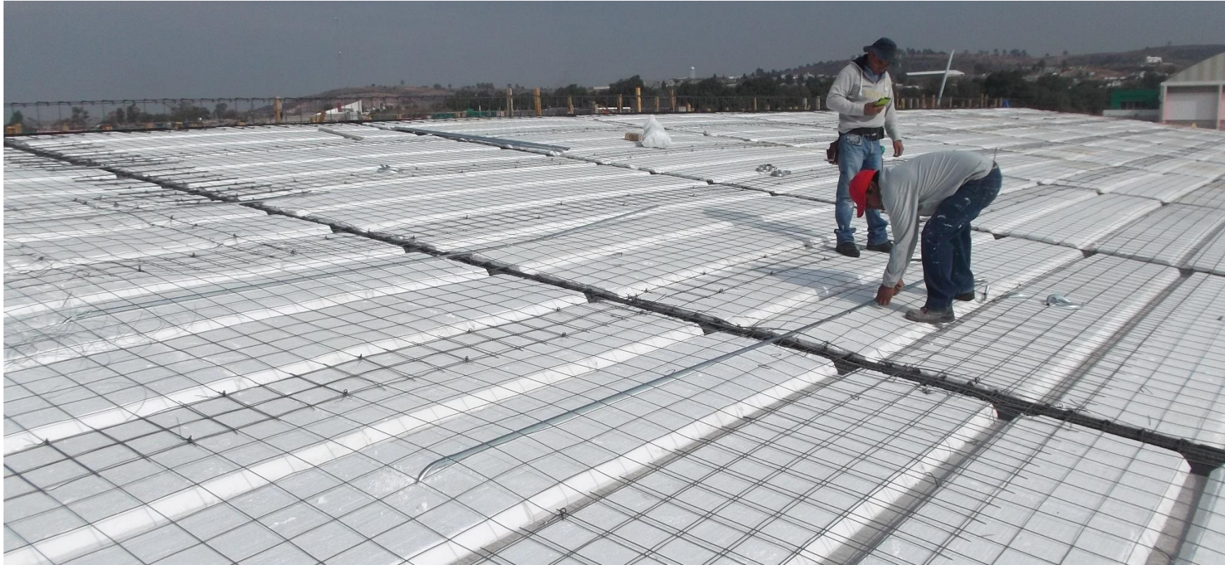
COLOCACIÓN DE TUBO CONDUIT PARA ALOJAR INSTALACIONES ELÉCTRICAS.
