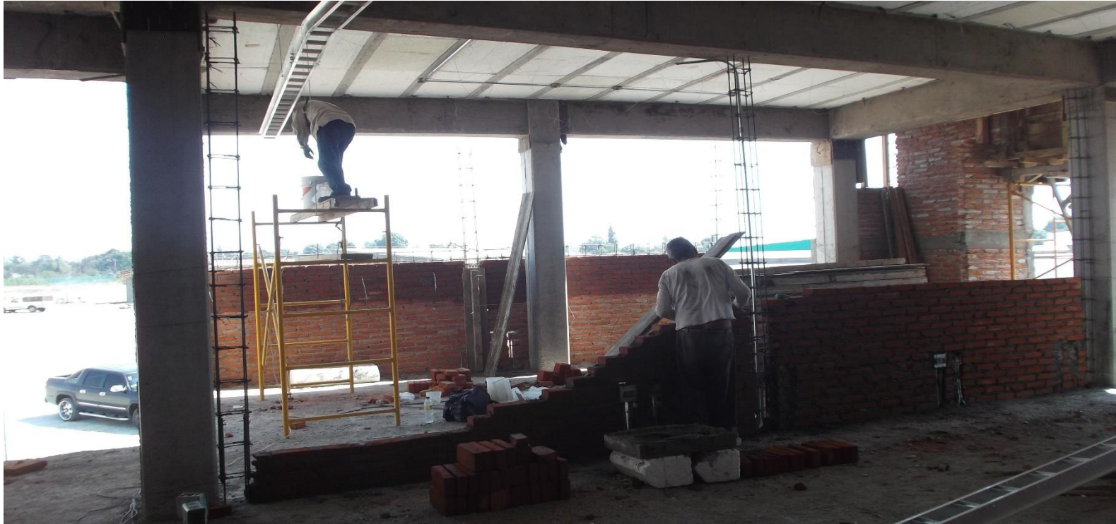
COLOCACIÓN DE INSTALACIONES ELÉCTRICAS Y VOZ Y DATOS EN PLANTA ALTA.
