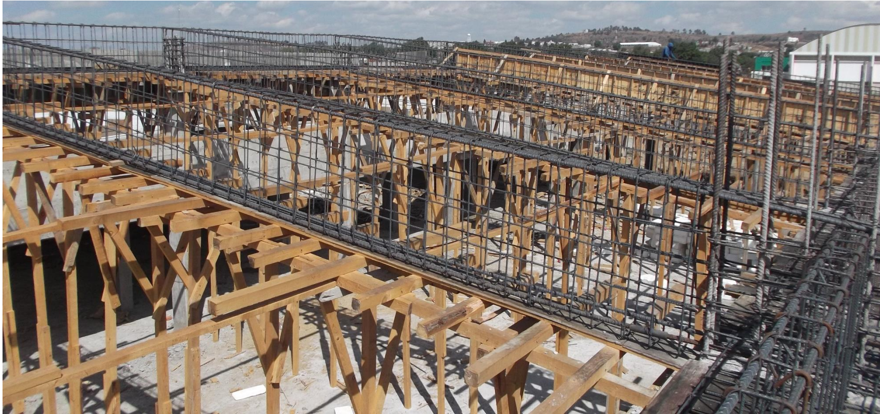
CIMBRADO Y ARMADO DE ACERO EN TRABES.
