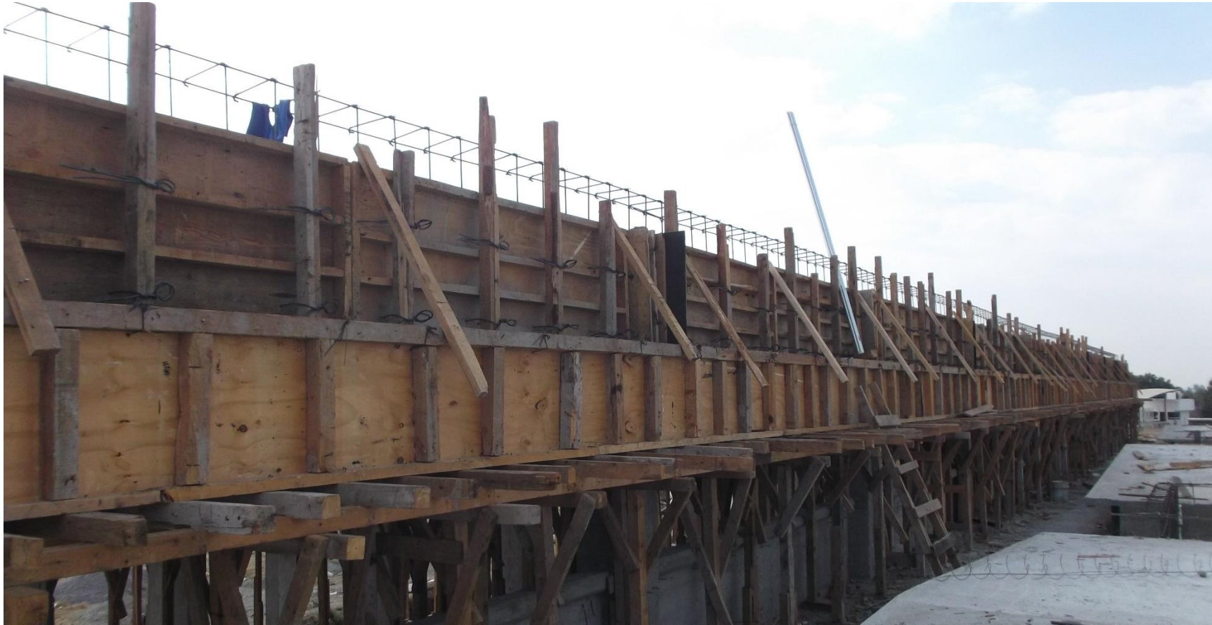
FALDÓN CIMBRADO QUE SERVIRÁ COMO PROTECCIÓN DE PARTE LUZ.
