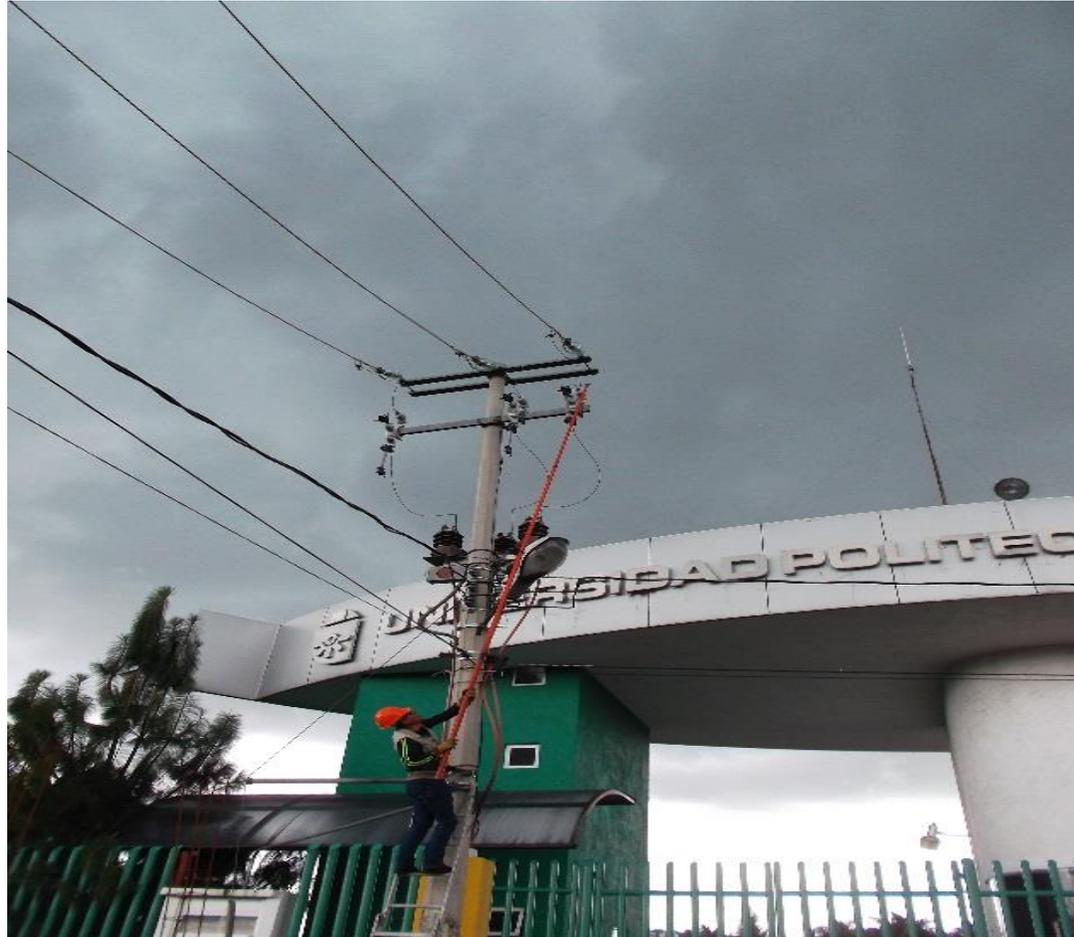
**SE SUBEN LAS CUCHILLAS EN LA LINEA DE C.F.E. PARA LA REANUDACION DEL SERVICIO DE ENERGIA ELECTRICA A LA U.P.T.**
