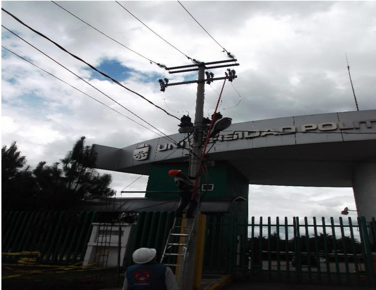
**BAJANDO LAS CUCHILLAS DE LA LINEA DE C.F.E. PARA CORTAR EL SERVICIO DE ENERGIA ELECTRICA AL INTERIOR DE U.P.T.**
