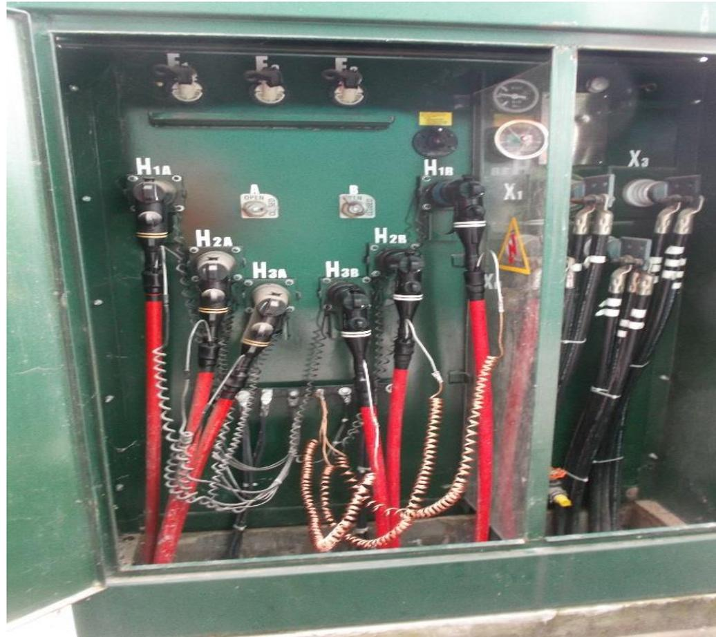
**INSERTOS COLOCADOS PARA 15 KVA. CONECTORES DE OPERACIÓN EN SUBESTACION DE 500 KVA. EXISTENTE**
