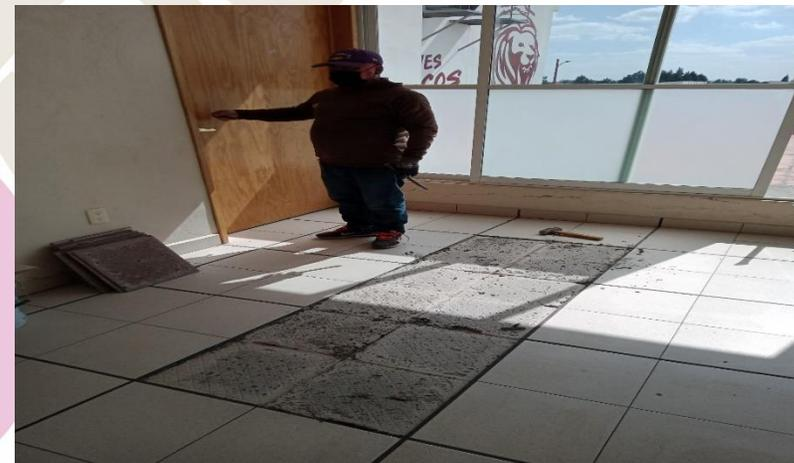
RETIRO DE LOSETAS TIPO PORCELANATO Y LOSETAS DE CERÁMICA ANTIDERRAPANTES 31X31 CM. DEMOLICIÓN DE MORTERO EN PISO DEL AULA 4, PA. EDIF.UD-6 Y EN ÁREA DE CALENTAMIENTO, P.A. GIMNASIO
