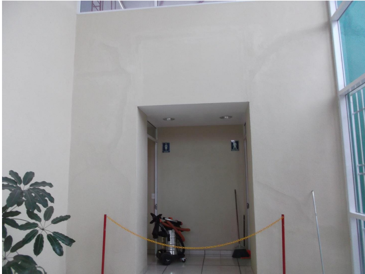
RESANE DE FISURAS EN MUROS EN BIBLIOTECA
