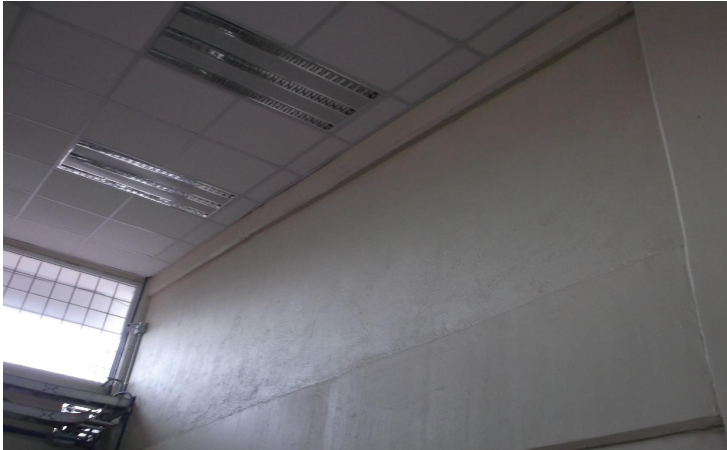
RESANE DE JUNTA FRÍA MURO DIVISORIO CON ESTRUCTURA DE EDIFICIO LT-2
