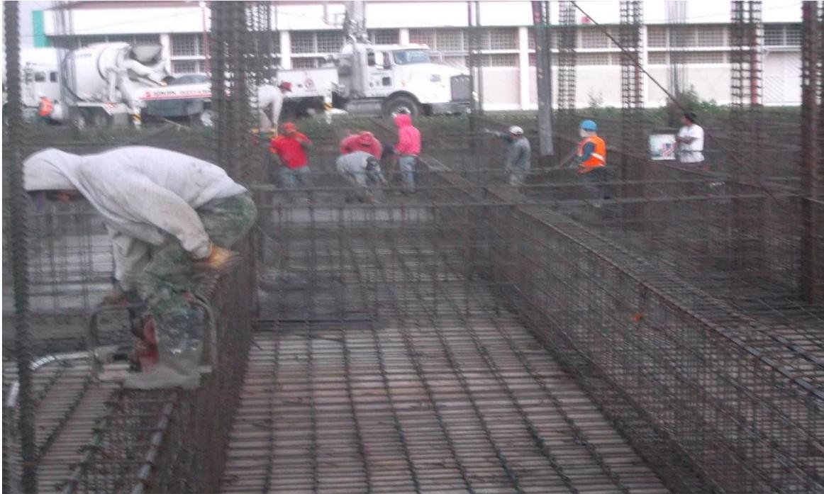
PARA EL MES DE AGOSTO UNA VEZ TERMINADO CON EL HABILITADO DE TODA EL ACERO DE CONTRA TRABES PARRILLAS PARA LOSA SE PROCEDE AL COLADO DE LA LOSA BAJA CON UN CONCRETO PREMEZCLADO Y UNA RESISTENCIA  $f''c = 250 \text{ KG/CM}^2$  INDICADO EN PROYECTO
