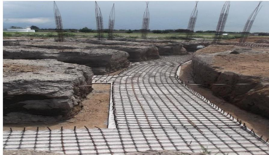
**SUMINISTRO, ARMADO Y COLOCADO DE ACERO DE REFUERZO EN ZAPATAS.**
