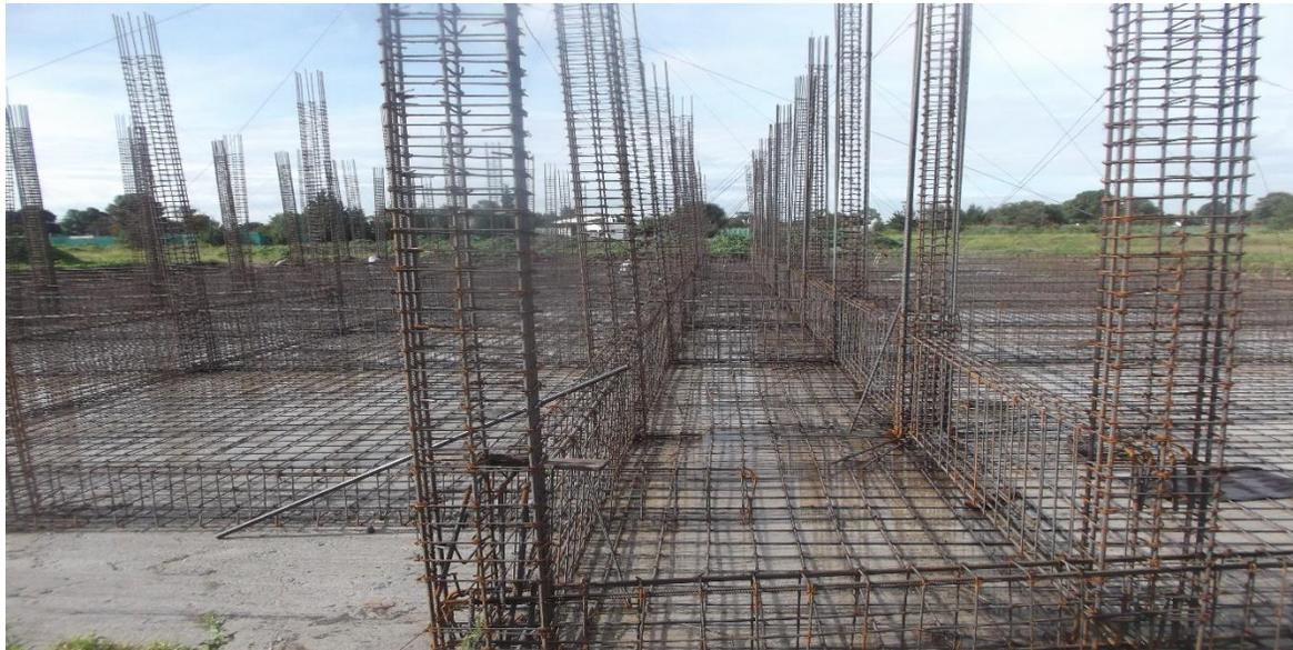
CONTINUAMOS CON LA CONSTRUCCIÓN DE LA OBRA DENOMINADA UNIVERSIDAD POLITÉCNICA DE TLAXCALA CON NUMERO DE CONTRATO **UPT-29-048-2016**, **CÓDIGO UPT-002-2015 EDIFICIO "LT-3"** PRIMERA ETAPA DE LABORATORIO TALLER 3 CUERPO "B" ESTRUCTURA CONCRETO AISLADO Y OBRA EXTERIOR, DEBIDO A LO COMPLEJO DEL ARMADO PARA ESTE MES DE JUNIO SE CONTINUA CON ARMADO DE COLUMNAS Y CONTRA TRAVÉS E HINCADO DE COLUMNAS.
