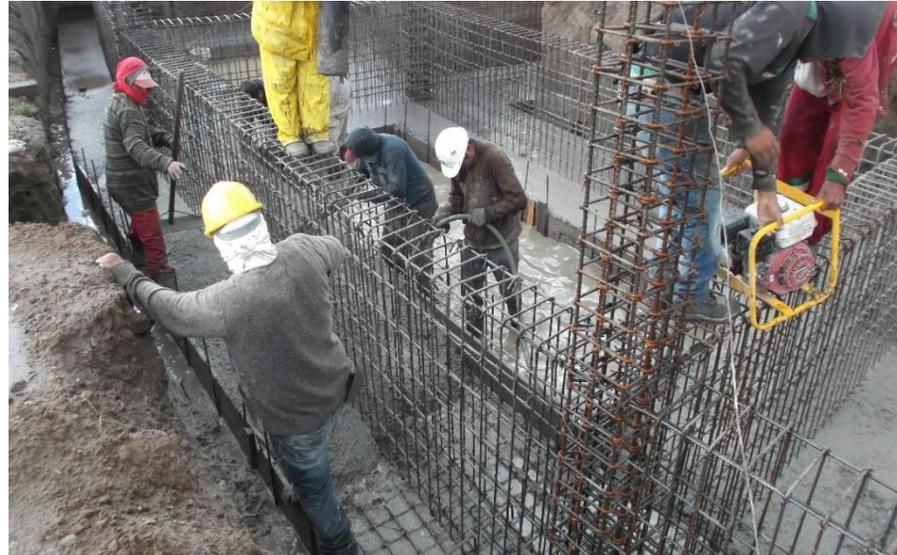
**ARMADO DE TRABES, ZAPATAS Y COLADO DE ZAPATAS.**
