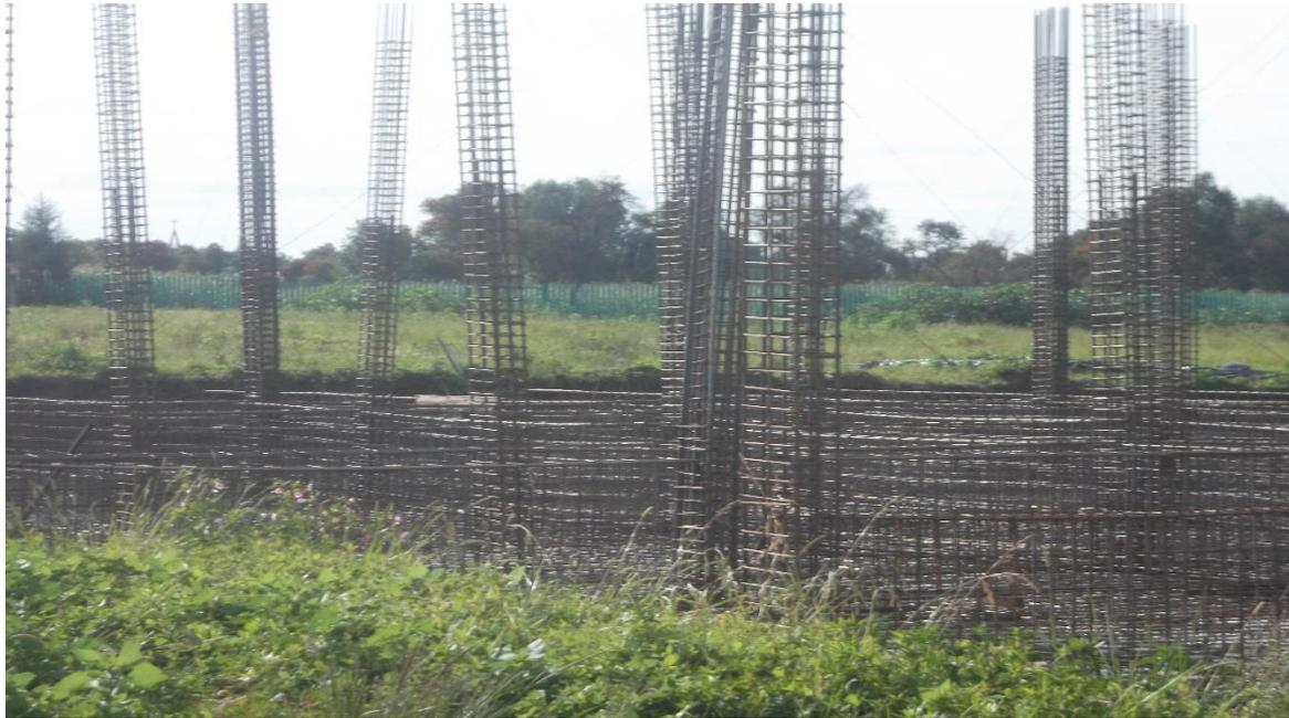
SE CONTINÚAN TODO EL MES DE JULIO CON LOS TRABAJOS DE HABILITADO DE ACERO EN COLUMNAS CONTRA TRABES E HINCADO DE COLUMNAS, ESTE TIPO DE ARMADO NOS INDICA UN FACTOR DE SEGURIDAD ALTO PARA EL CÁLCULO ESTRUCTURAL YA QUE ALBERGARA EN SU MOMENTO UN GRAN CUMULO DE ESTUDIANTES Y PROFESORES.
