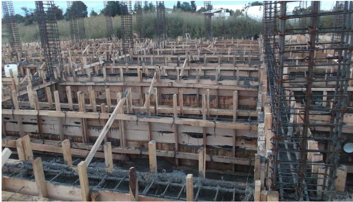
A INICIOS DE LA SEGUNDA SEMANA DE OCTUBRE SE REALIZAN LOS TRABAJOS DE VACIADO DE CONCRETO EN CONTRA TRABES, ESTE CONCRETO ES DE UNA RESISTENCIA DE  $f'c=250 \text{ KG/CM}^2$  DE ACUERDO A NORMA MEXICANA (NMX-C-155-ONNCE-2004).
