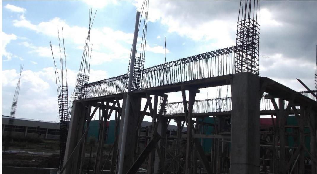
**COLUMNAS DE CONCRETO, CIMBRA DE FONDO Y COLOCACION DE ACERO DE REFUERZO EN TRABES DE ENTREPISO.**
