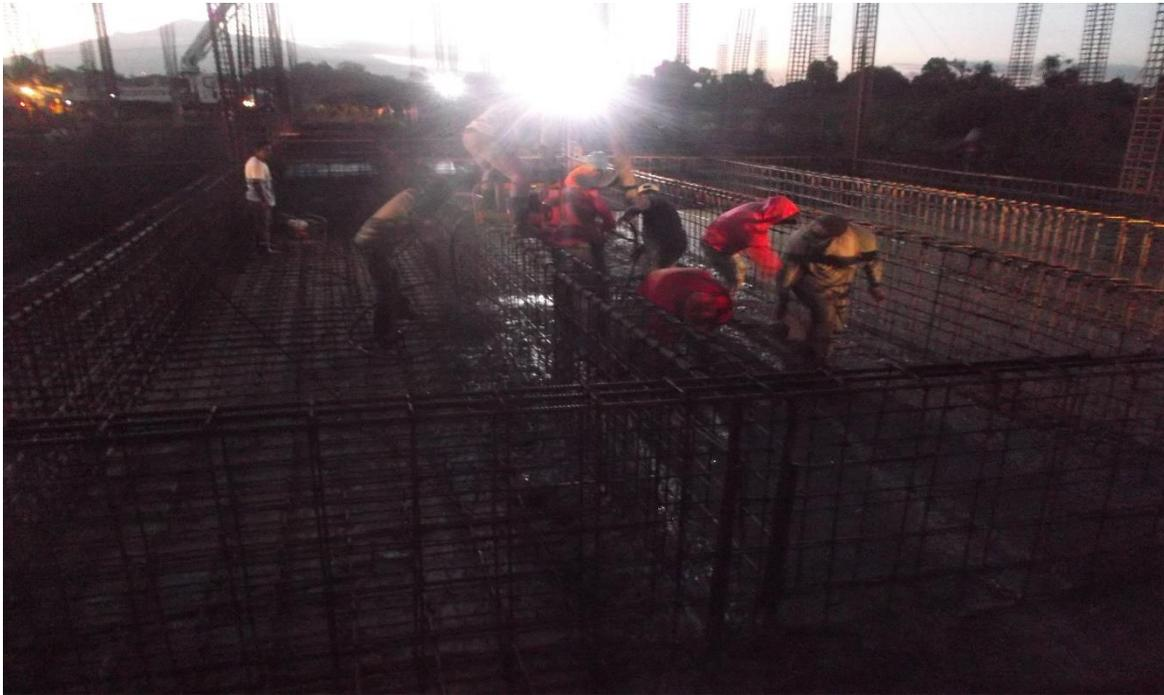
PARA EL MES DE AGOSTO SE SIGUEN CON LOS TRABAJOS DE HABILITADO DE ACERO PARA LA LOSA BAJA YA QUE ESTA LOSA, QUE SERÁ DE UN ESPESOR DE 20 CENTÍMETROS, CONTENDRÁ TAMBIÉN UNA DOBLE PARRILLA, POR MOTIVOS DE CÁLCULO EL ACERO ES DEL #4. ESPECIFICADO EN PROYECTO.
