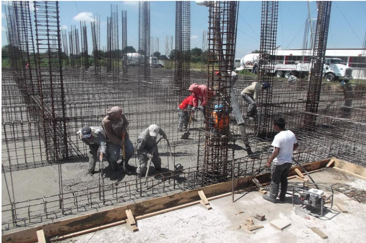
UNA VEZ TENDIDO Y VIBRADO DEL CONCRETO SE PROCEDE A HACER TRABAJO DE APISONAMIENTO EN LA LOSA CON PISONES DE MADERA PARA EXPULSAR POSIBLES BURBUJAS DE AIRE QUE PUDIERAN QUEDAR ATRAPADAS EN EL CONCRETO, ESTO PARA ASEGURAR UNA LOSA FIRME Y CONSISTENTE, ADEMÁS DEL CURADO DEL CONCRETO PARA QUE ALCANCE LA RESISTENCIA REQUERIDA
