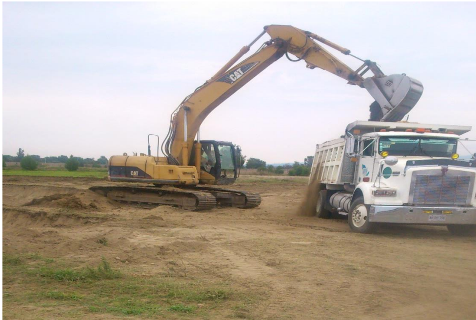
TRABAJOS DE EXCAVACIÓN Y ACARREOS DE MATERIAL PRODUCTO DE LA EXCAVACIÓN.
