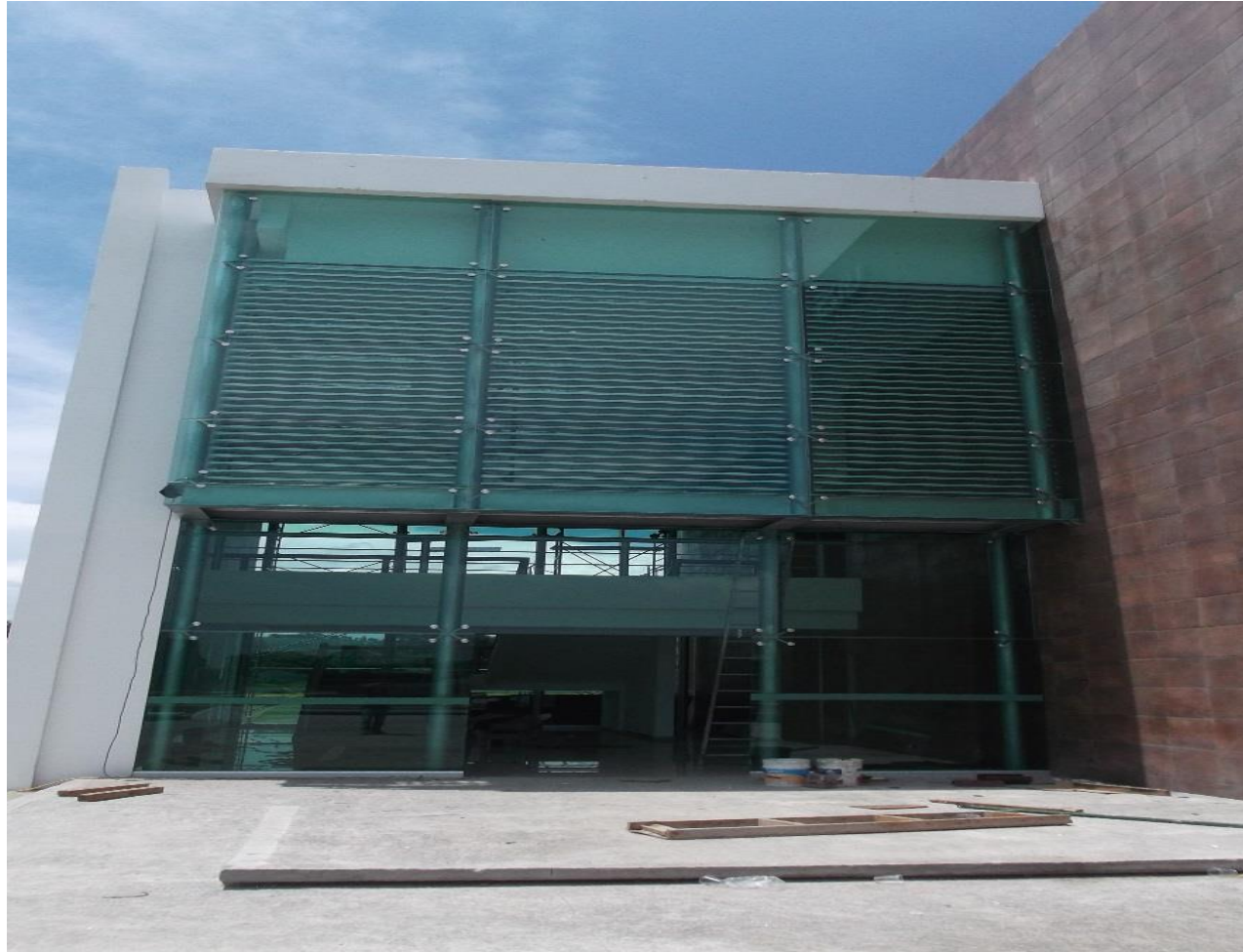
COLOCACION DE ESTRUCTURA METALICA Y MODULOS DE VIDRIO TINTEX DE 9MM. EN FACHADA PRINCIPAL
