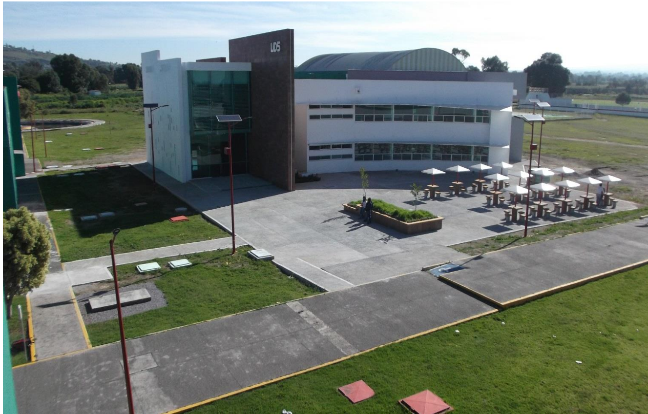
PANDRAMICA FACHADA SUR EDIFICIO UD-5 (OBRA CONCLUIDA).
