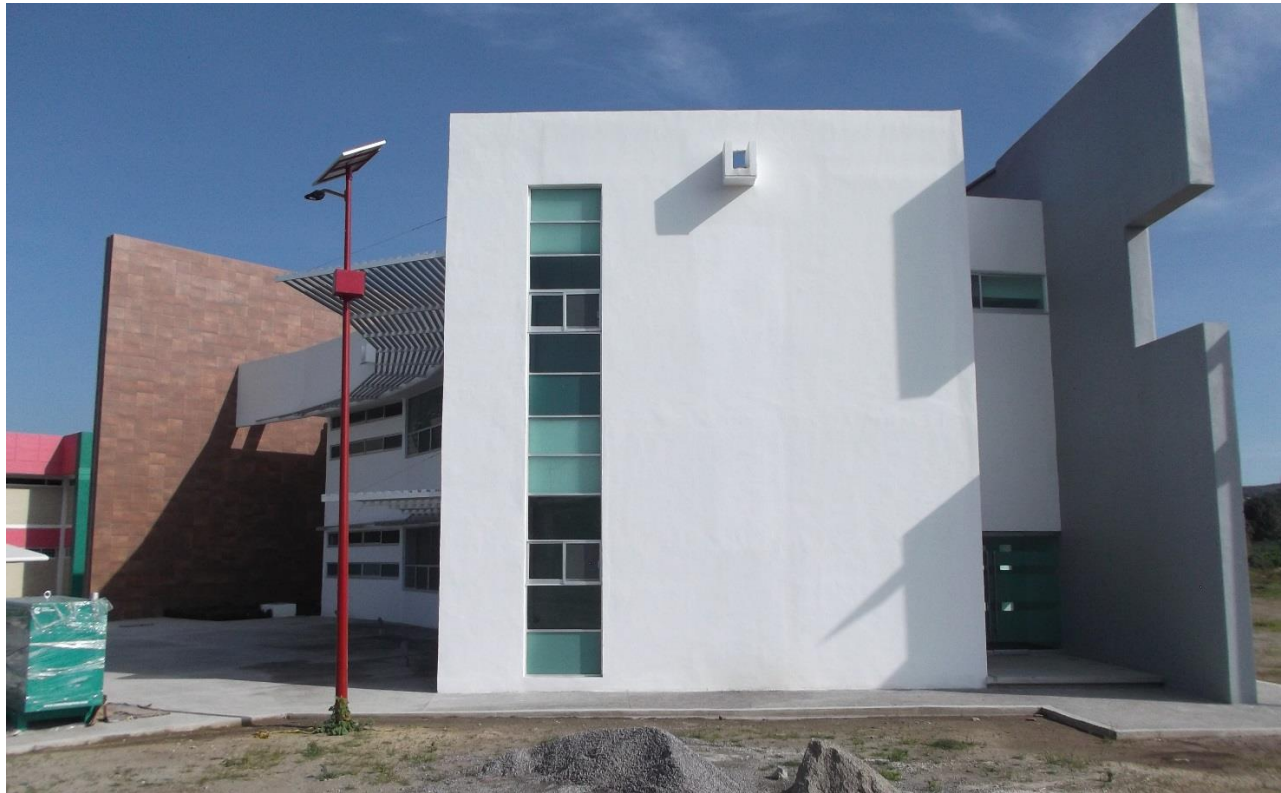
VISTA DE LA FACHADA ORIENTE SALIDA DE HEMERGENCIA EDIFICIO UD-5 (OBRA CONCLUIDA).
