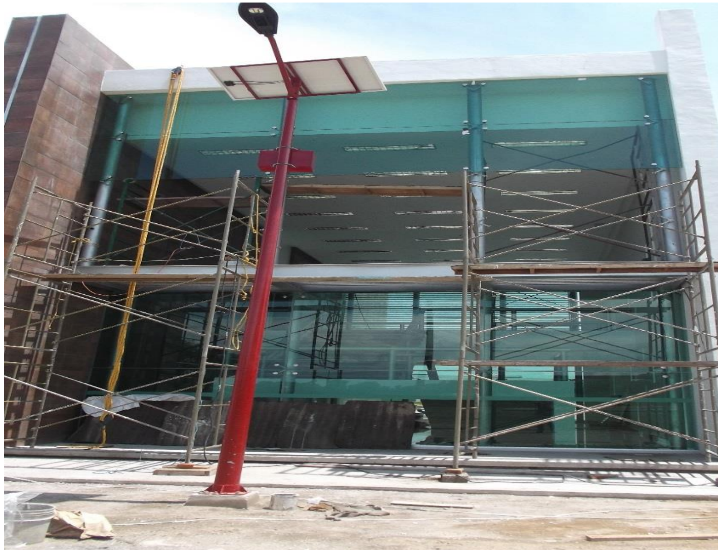
COLOCACION DE ESTRUCTURA METALICA Y MODULOS DE VIDRIO TINTEX DE 9 MM. FACHADA POSTERIOR
