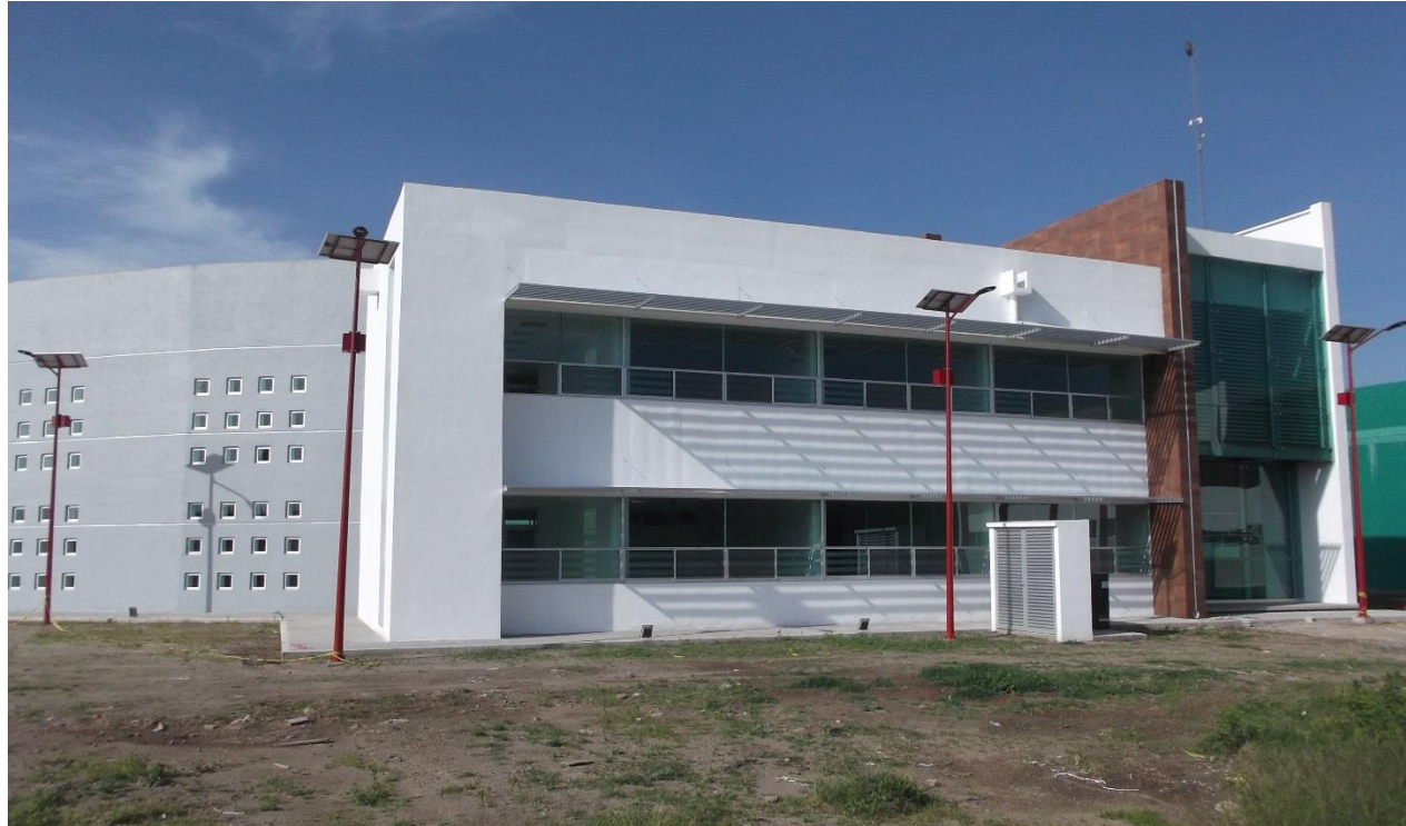
FACHADA POSTERIOR/NORTE EDIFICIO UD-5 (OBRA CONCLUIDA).
