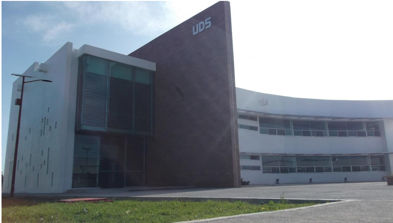
VISTA DE LA FACHADA DE ACCESO PRINCIPAL, AL EDIFICIO UD-5 (OBRA CONCLUIDA).
