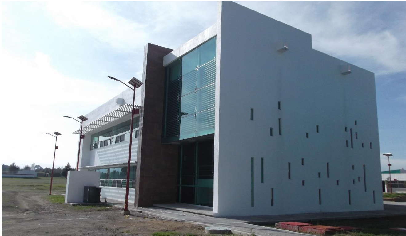
FACHADA PONIENTE/NORTE EDIFICIO UD-5 (OBRA CONCLUIDA).
