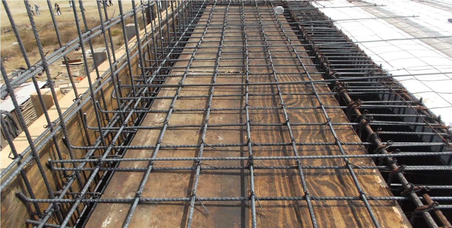
CIMBRADO Y ARMADO EN LOSAS MACISAS DE LOSA DE AZOTEA.
