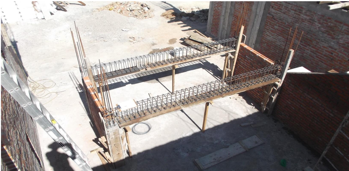
CIMBRADO DE FONDOS Y COLOCACION DE ACERO DE REFUERZO EN TRABES DE ESCALERA.
