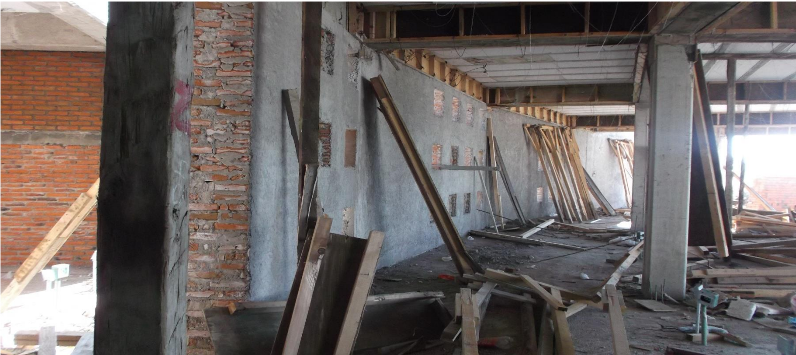
REPELLADOS EN MUROS INTERIORES DE PLANTA BAJA.
