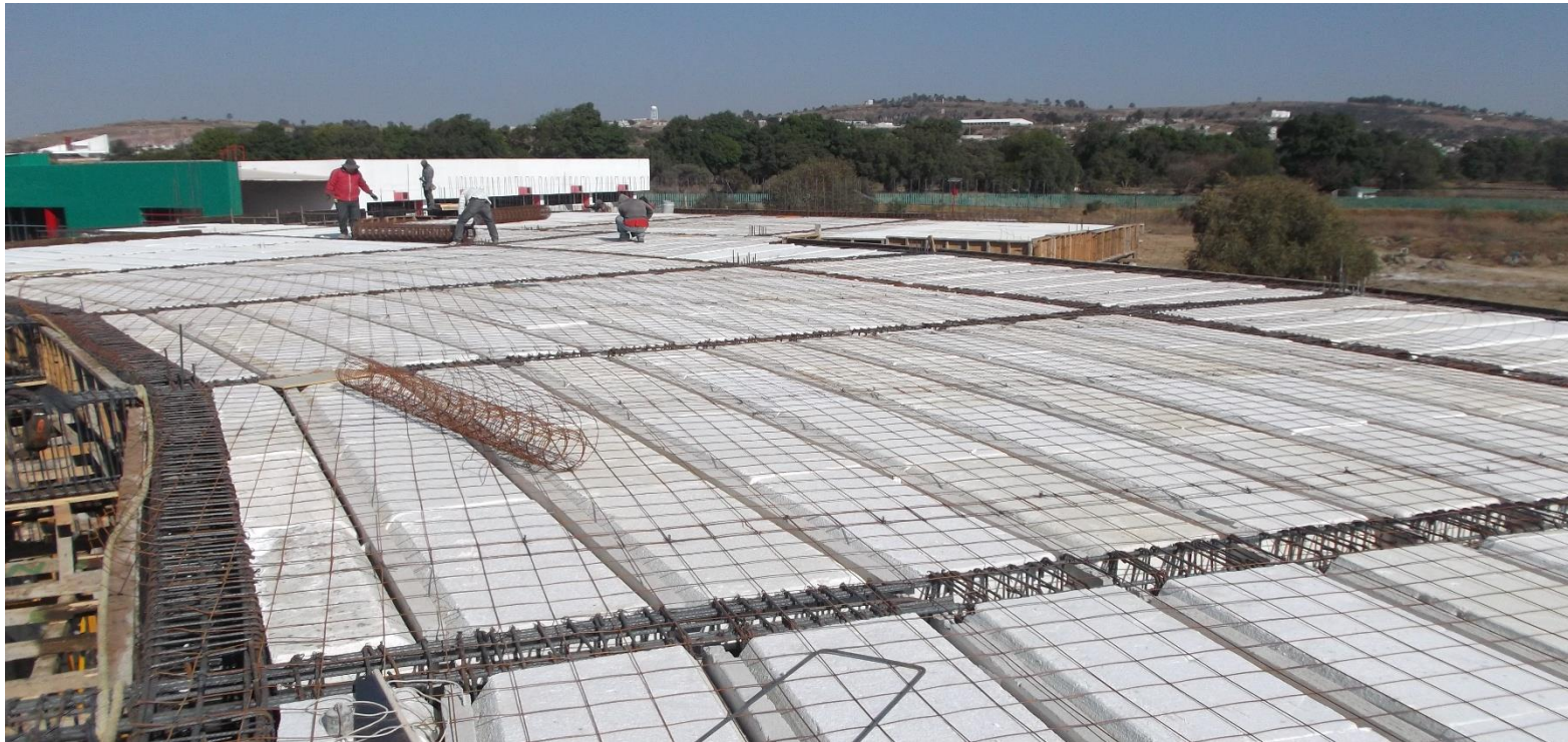
COLOCACION DE VIGUETAS Y CASETONES EN LOSA DE AZOTEA.
