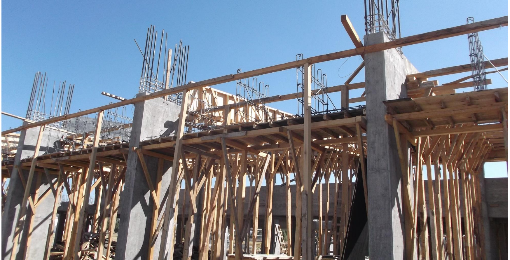
TRABAJOS DE CIMBRADO Y HABILITADO DE ACERO EN PARTE LUZ HORIZONTAL Y VERTICAL.
