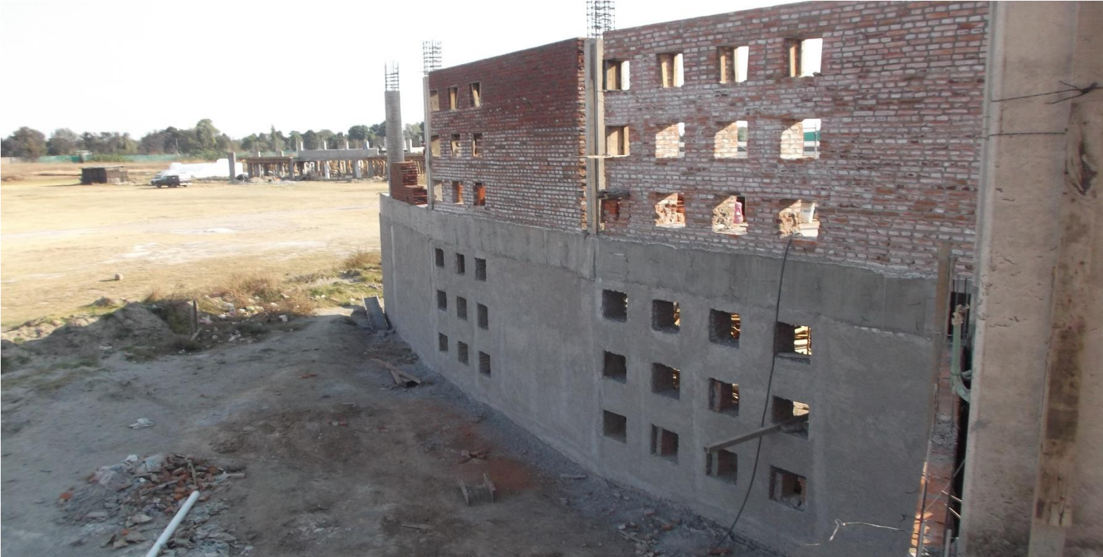
CONSTRUCCION DE MUROS EXTERIORES EN Y REPELLADOS EN FACHADAS.
