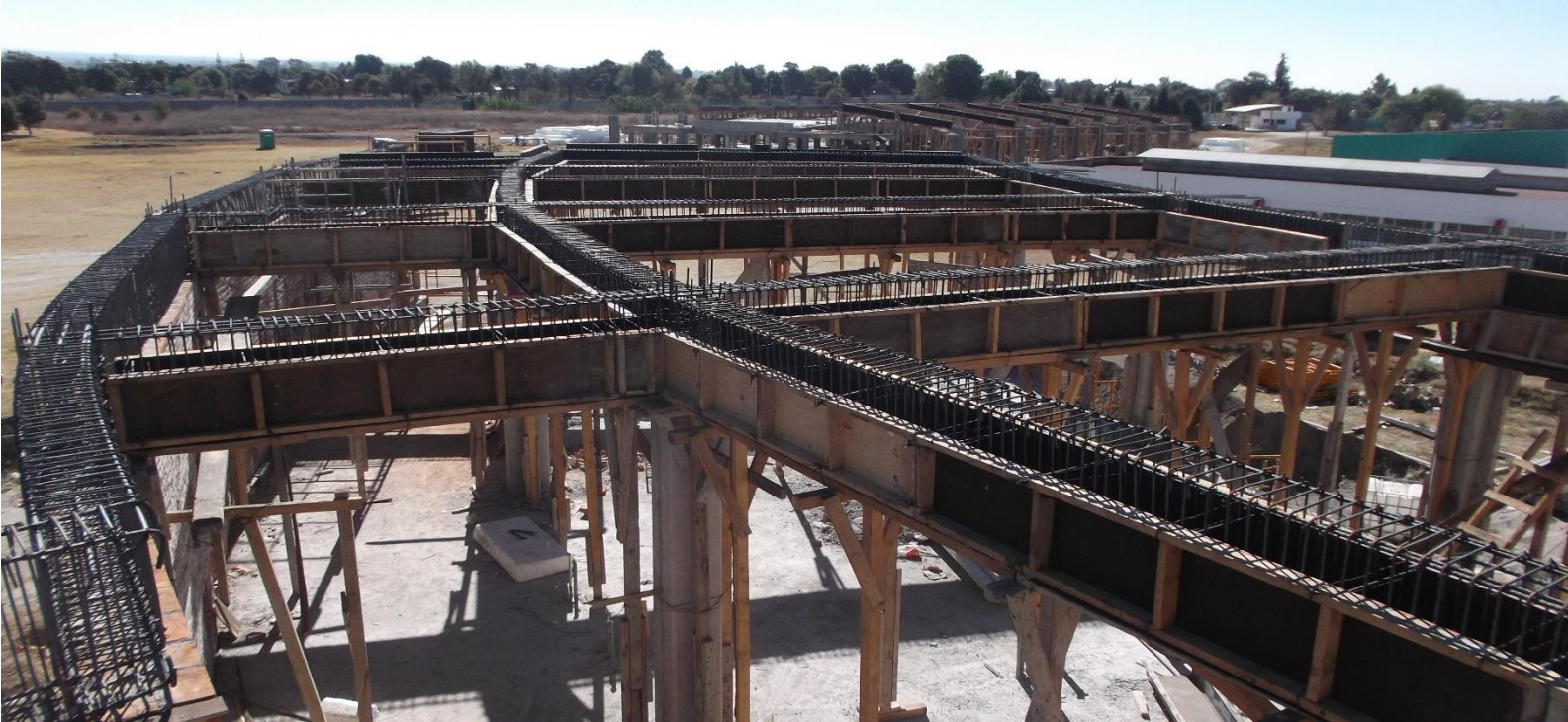
CIMBRADO DE COSTADOS Y ARMADO CON ACERO DE REFUERZO EN TRABES DE LOSA DE AZOTEA.
