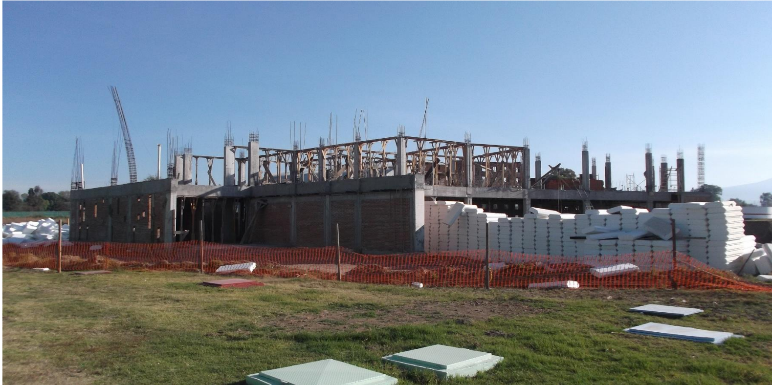
COLADO DE COLUMNAS, CIMBRADO DE FONDOS Y ARMADO CON ACERO DE REFUERZO EN TRABES DE LOSA DE AZOTEA.
