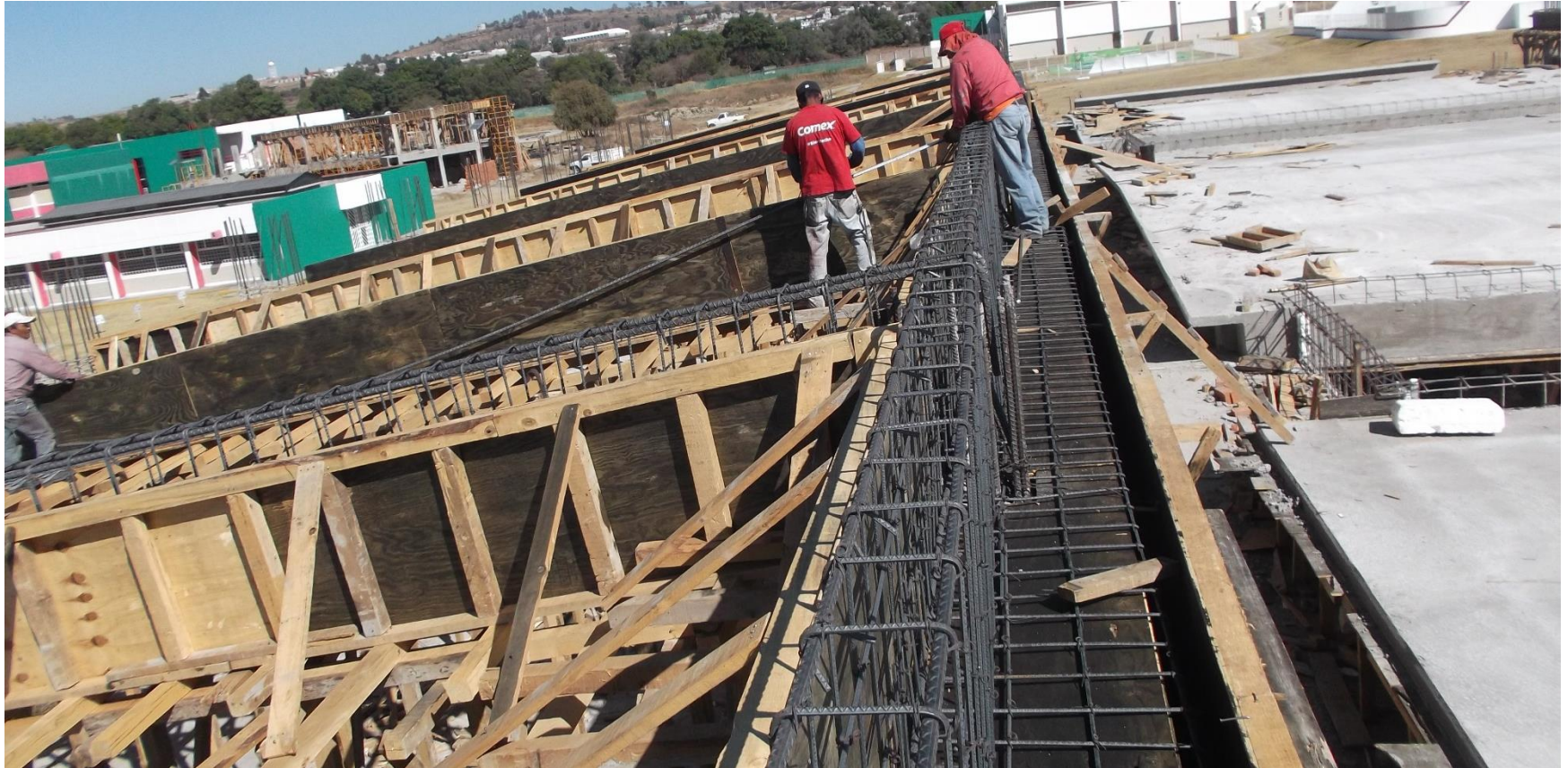
TRABAJOS DE CIMBRA, HABILITADO DE HACERO EN TRABES Y FALDONES EN AMBOS EJES.
