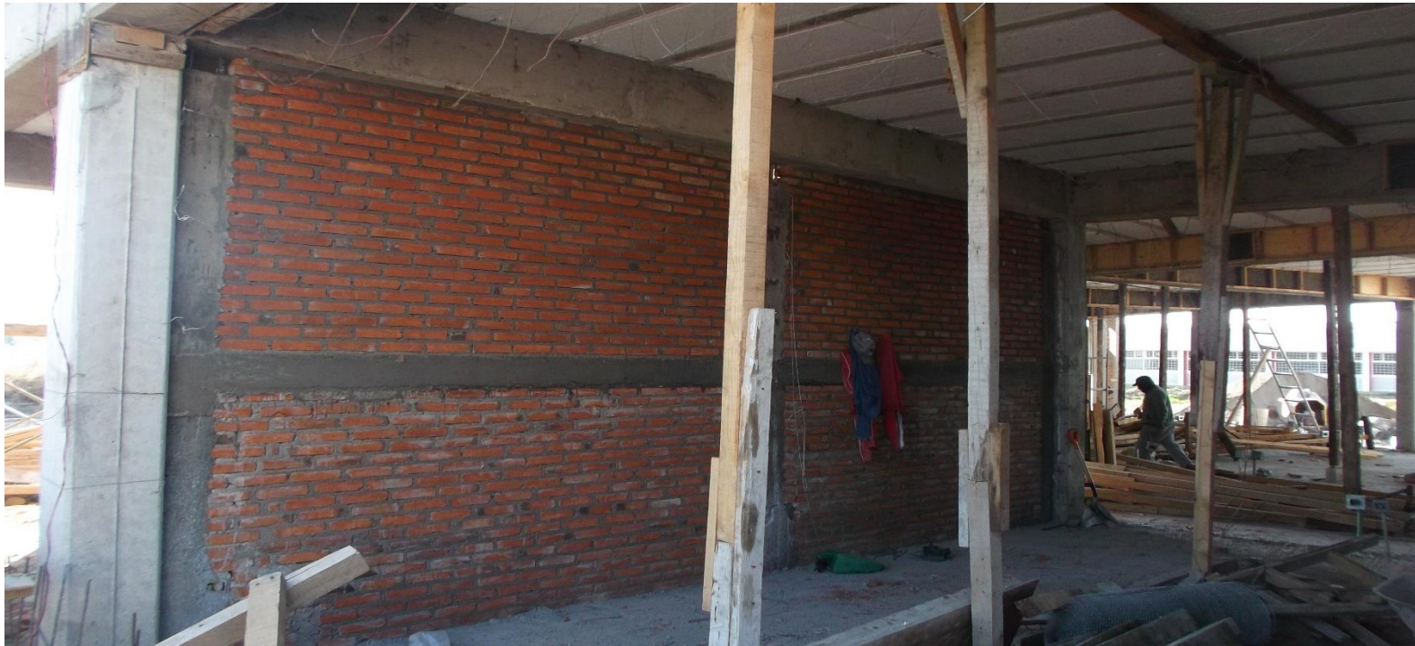
MUROS INTERIORES EN PLANTA BAJA.
