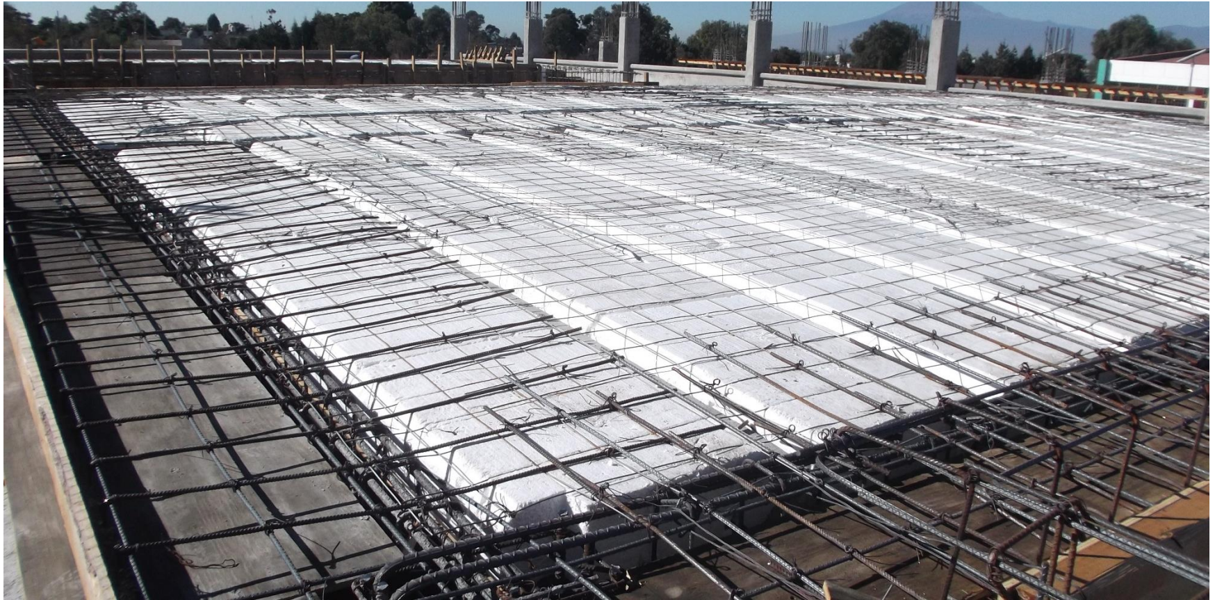
LOSA LISTA, CON REFUERZO DE ACERO EN VOLADOS, MALLA ELECTRO SOLDADA Y ALOJAMIENTO DE TUBERÍA PARA INSTALACIÓN ELÉCTRICA.
