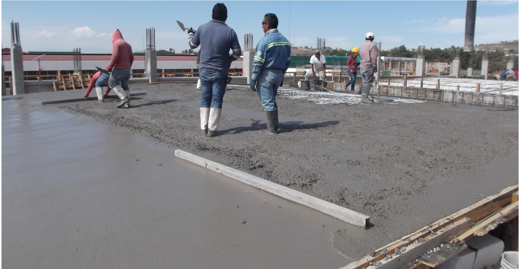
VACIADO DE CONCRETO f'c = 250 \text{ KG/CM}^2 EN LOSA
