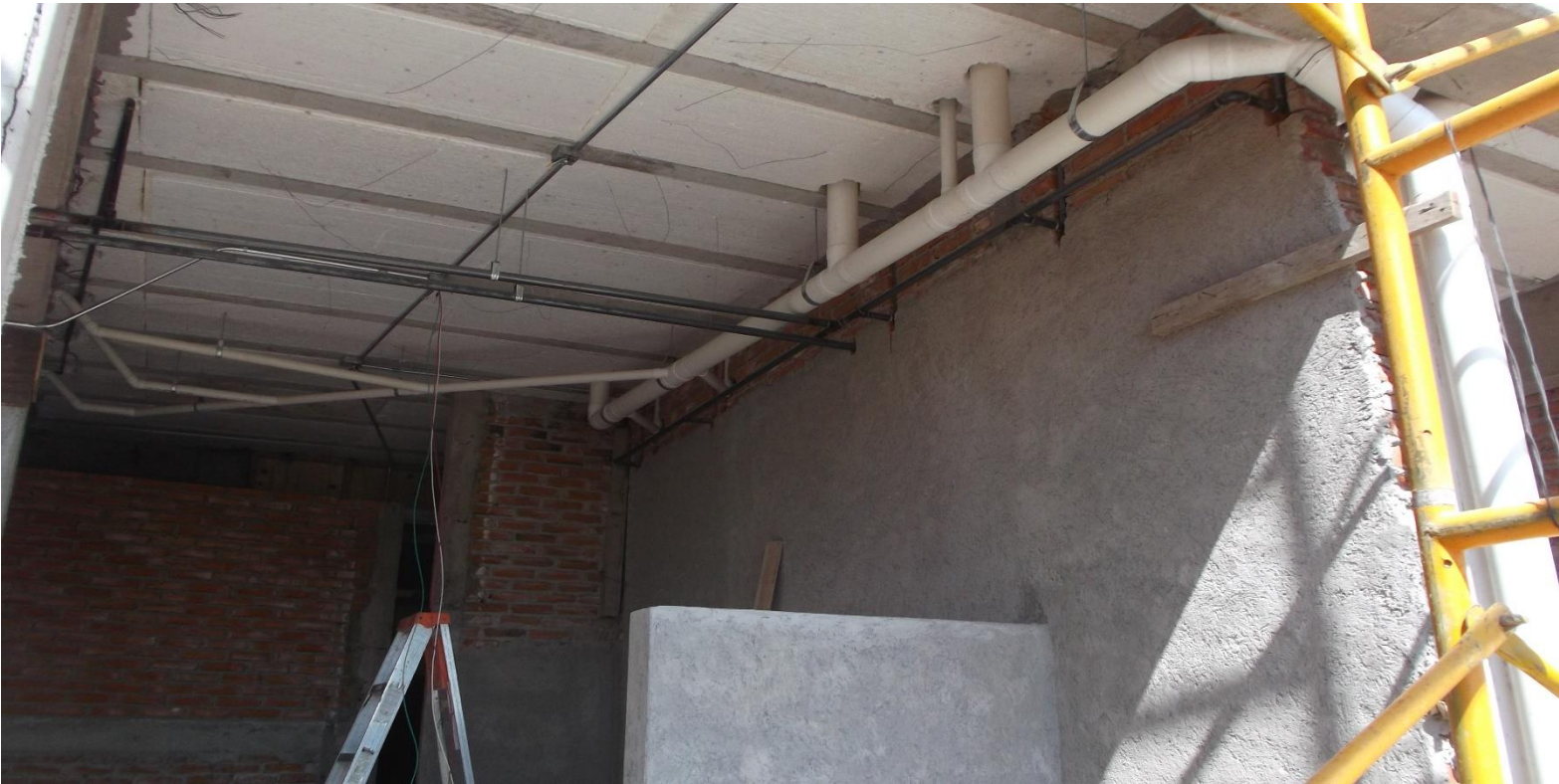
COLOCACION DE INSTALACIONES HIDRAULICAS Y SANITARIAS EN LOSA DE ENTREPISO.
