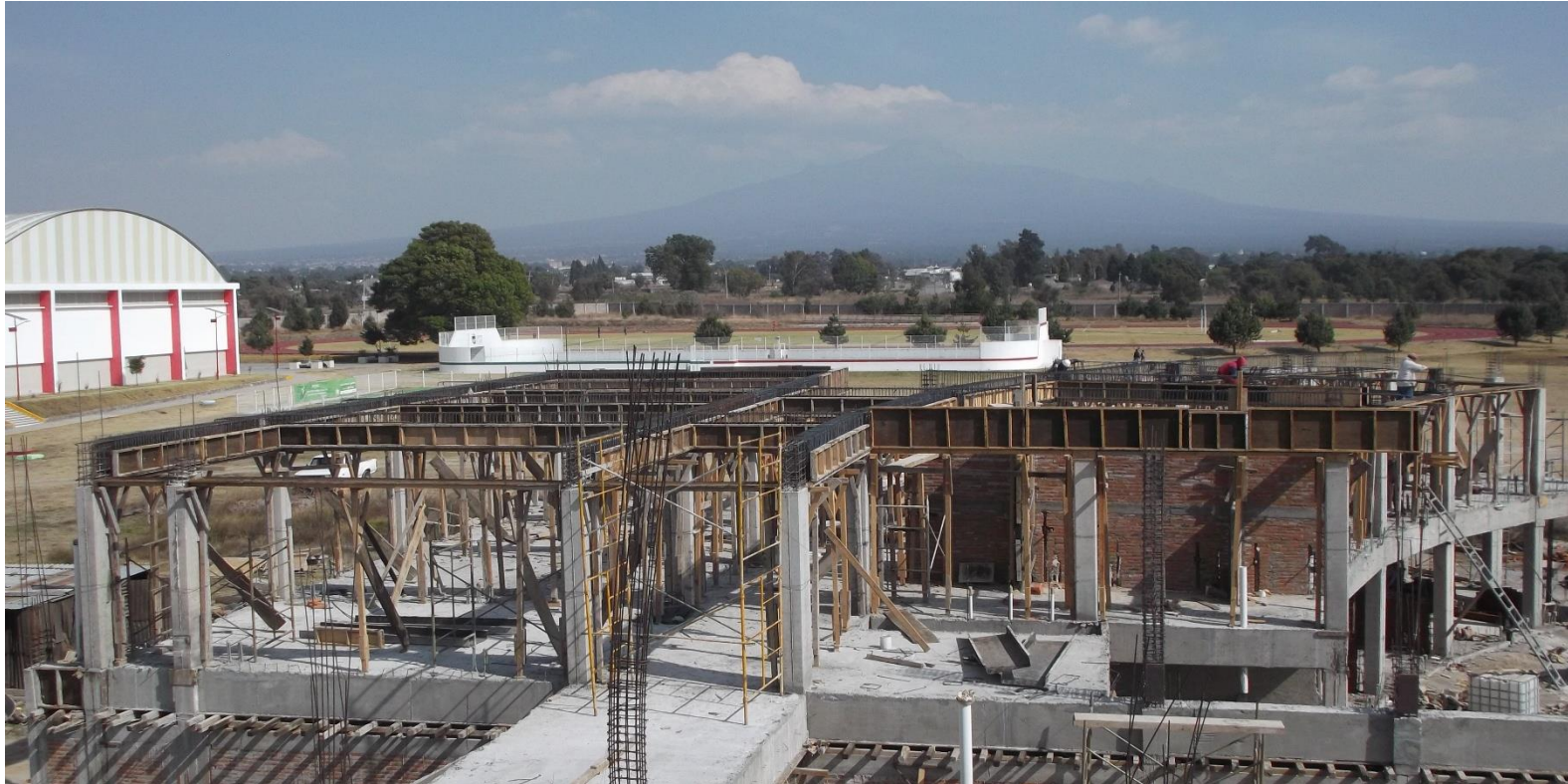
CIMBRADO DE COSTADOS Y ARMADO CON ACERO DE REFUERZO EN TRABES DE LOSA DE AZOTEA.
