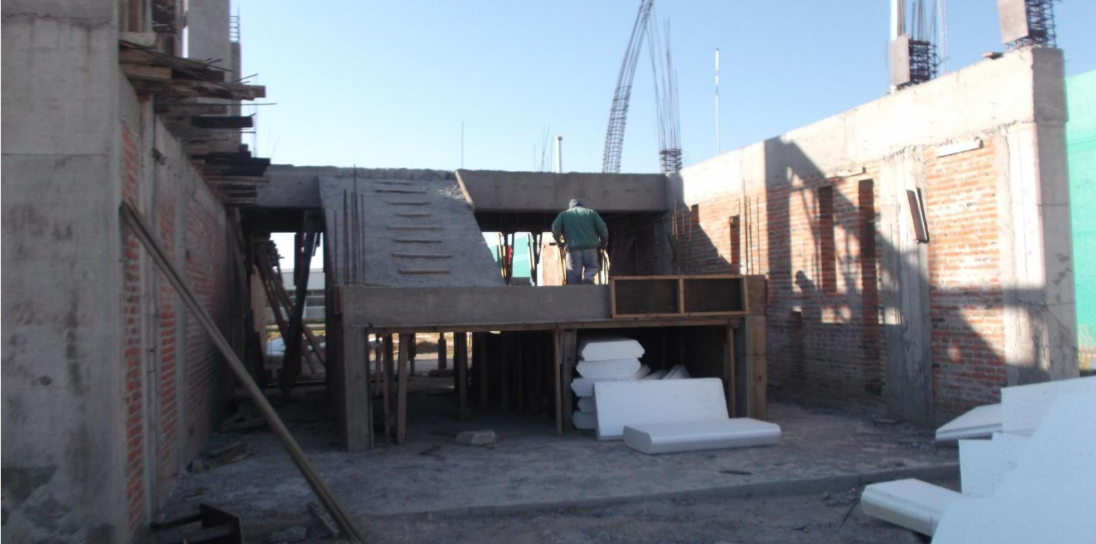
COLADO DE LOSA DE DESCANSO Y RAMPAS DE ESCALERA.
