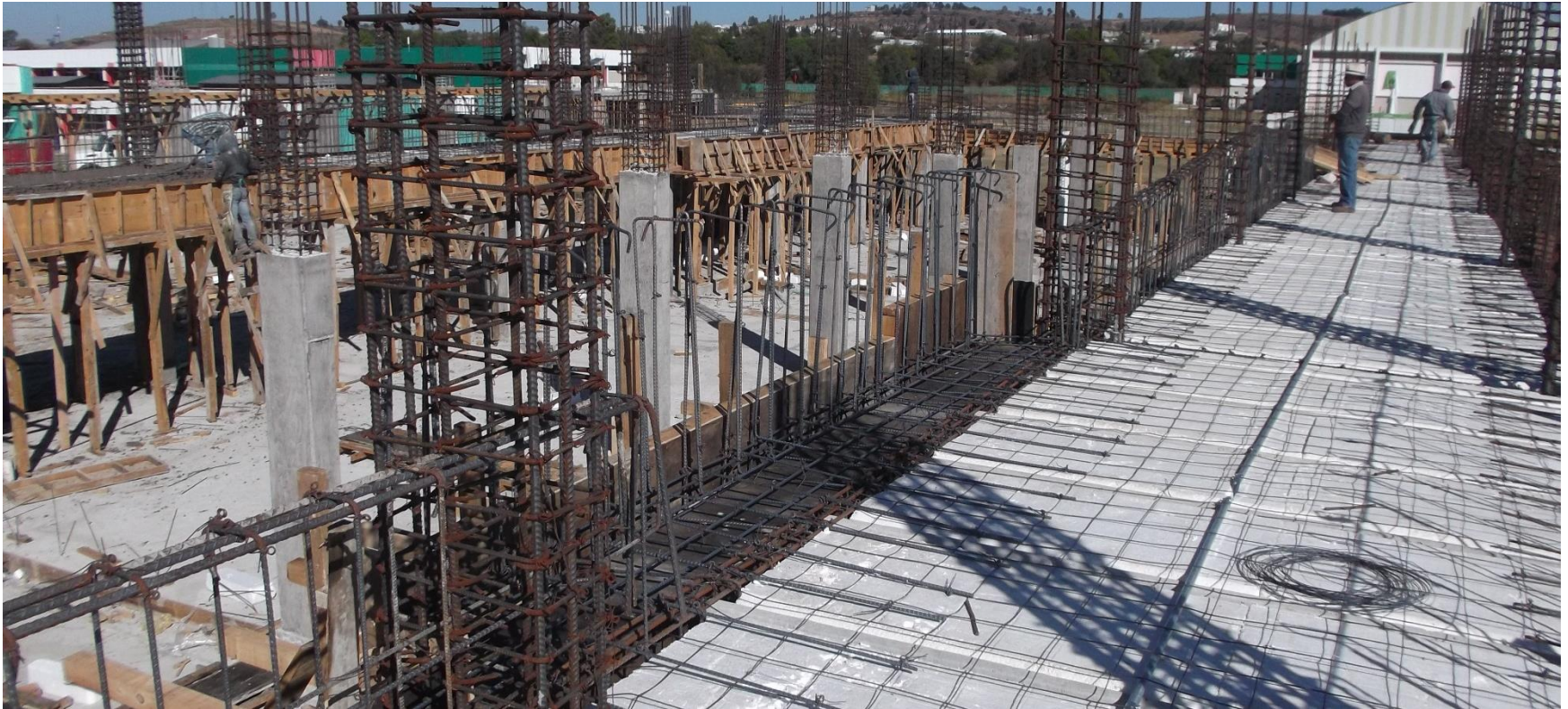
CIMBRA Y ACERO ENTRABES LOSA Y FALDONES, CASETONES DE POLIESTIRENO PARA ALIGERADO DE LOSAS.
