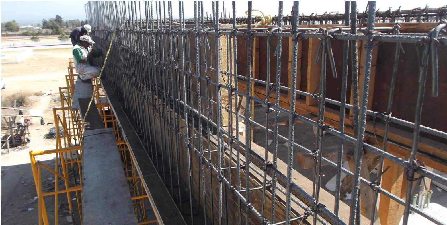
CIMBRADO Y ARMADO CON ACERO DE REFUERZO EN FALDONES DE CONCRETO TIOPO FC-2 EN LOSA DE AZOTEA.
