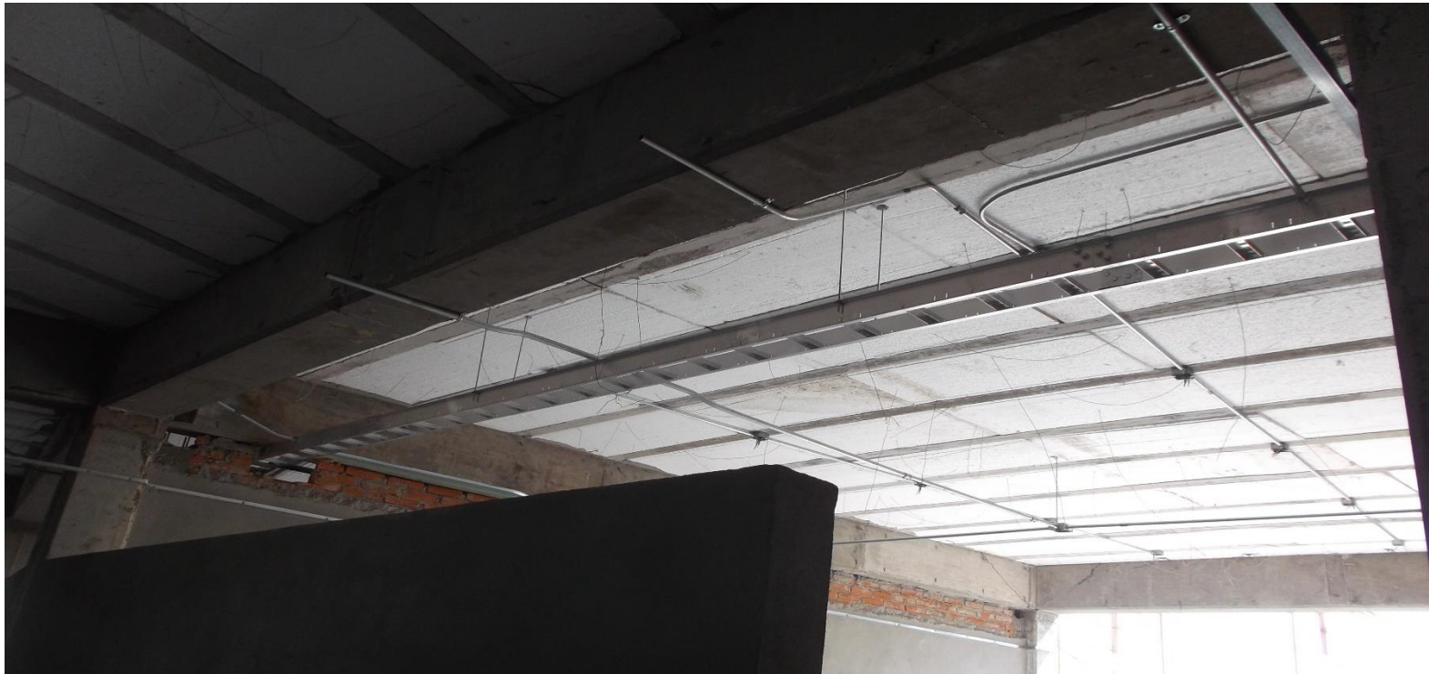
COLOCACION DE INSTALACIONES ELECTRICAS Y DE VOZ Y DATOS EN LOSA DE ENTREPISO.
