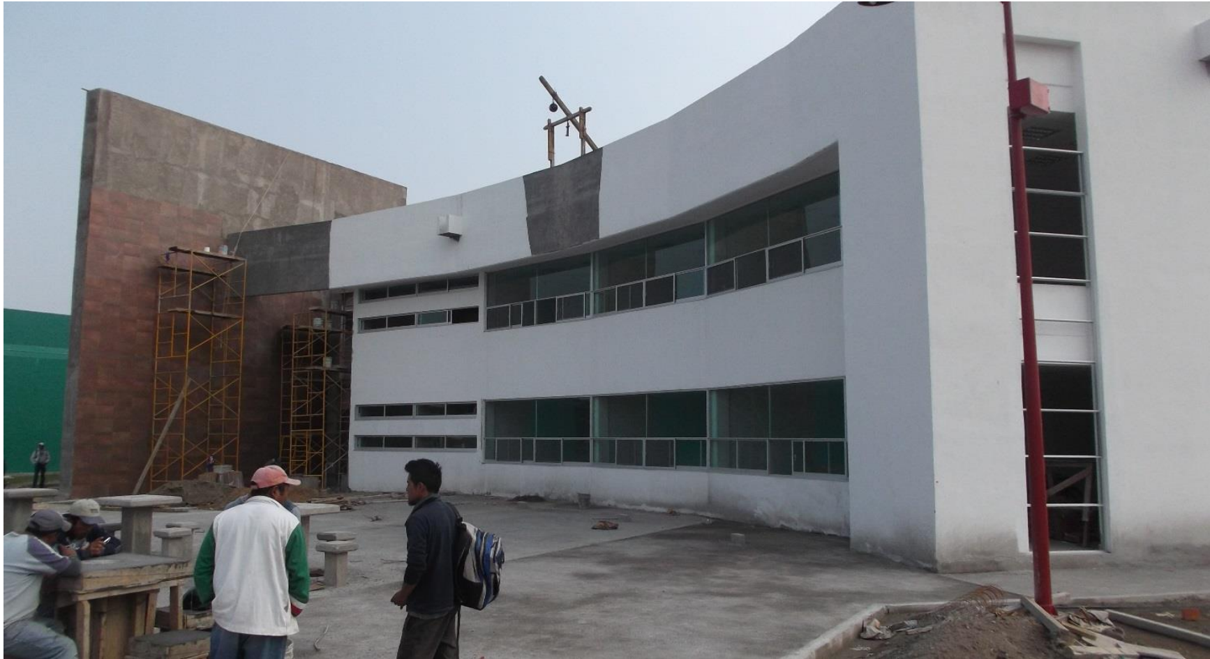
APLICACIÓN DE PINTURA (FONDEO) EN MUROS EXTERIORES.
