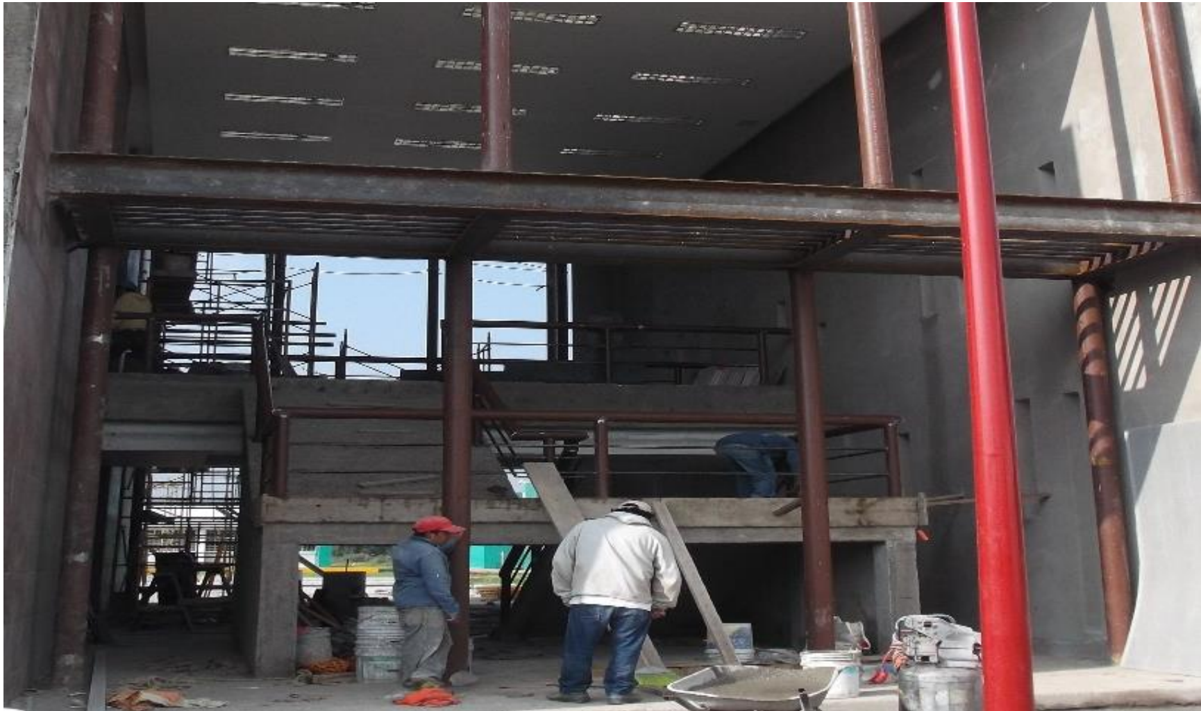
SUMINISTRO Y COLOCACION DE ESTRUCTURA METALICA EN ACCESO PRINCIPAL
