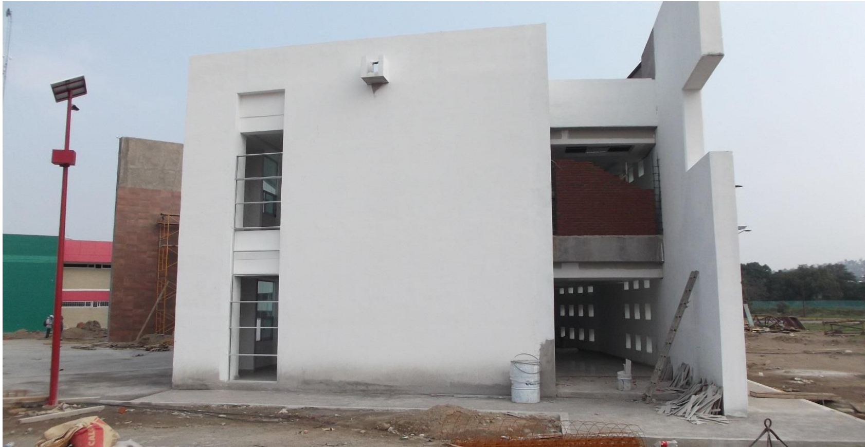
APLICACIÓN DE PINTURA (FONDEO) EN MUROS EXTERIORES.
