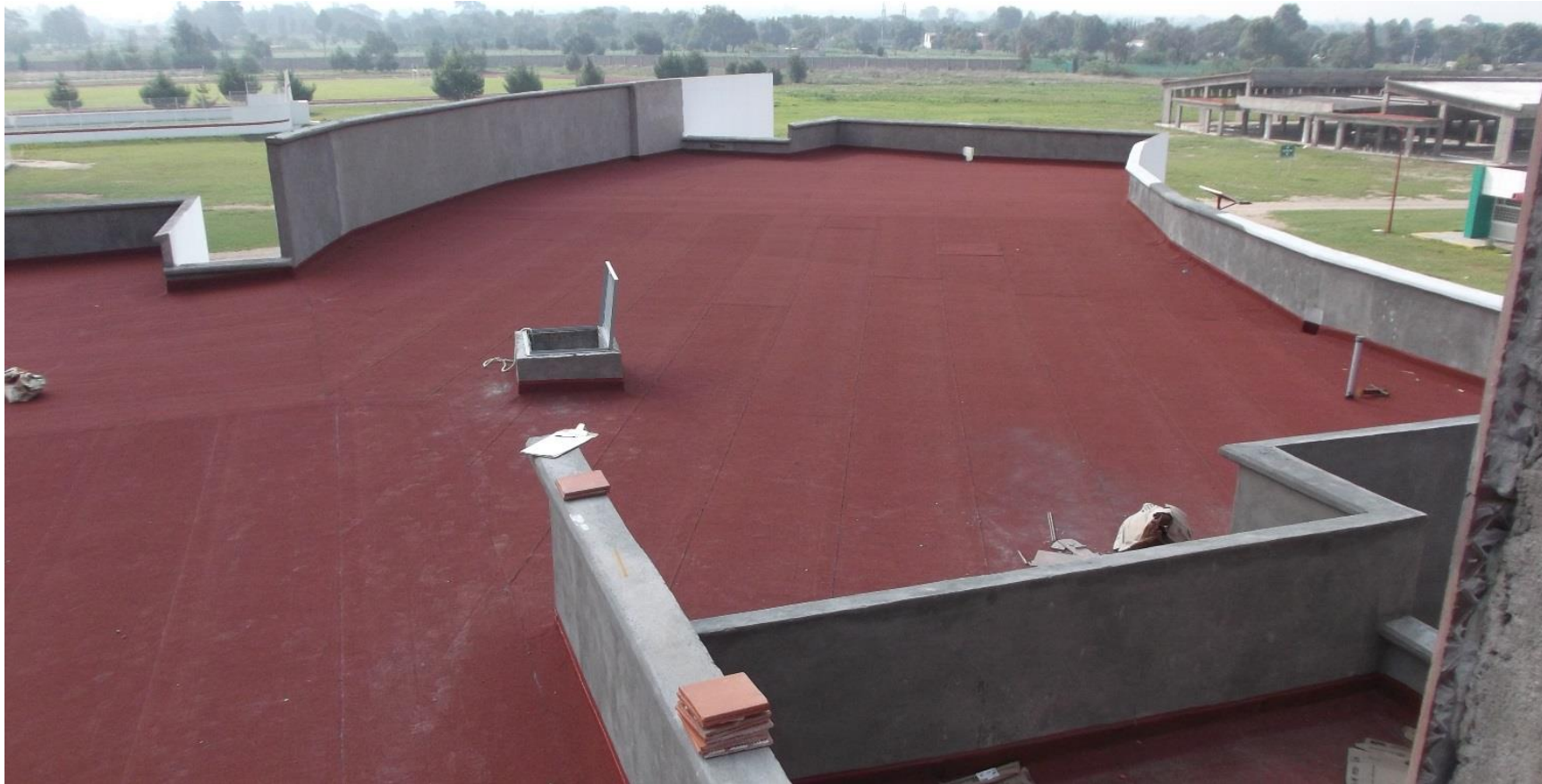
COLOCACION DE MEMBRANA IMPERMEABILIZANTE EN LOSA DE AZOTEA
