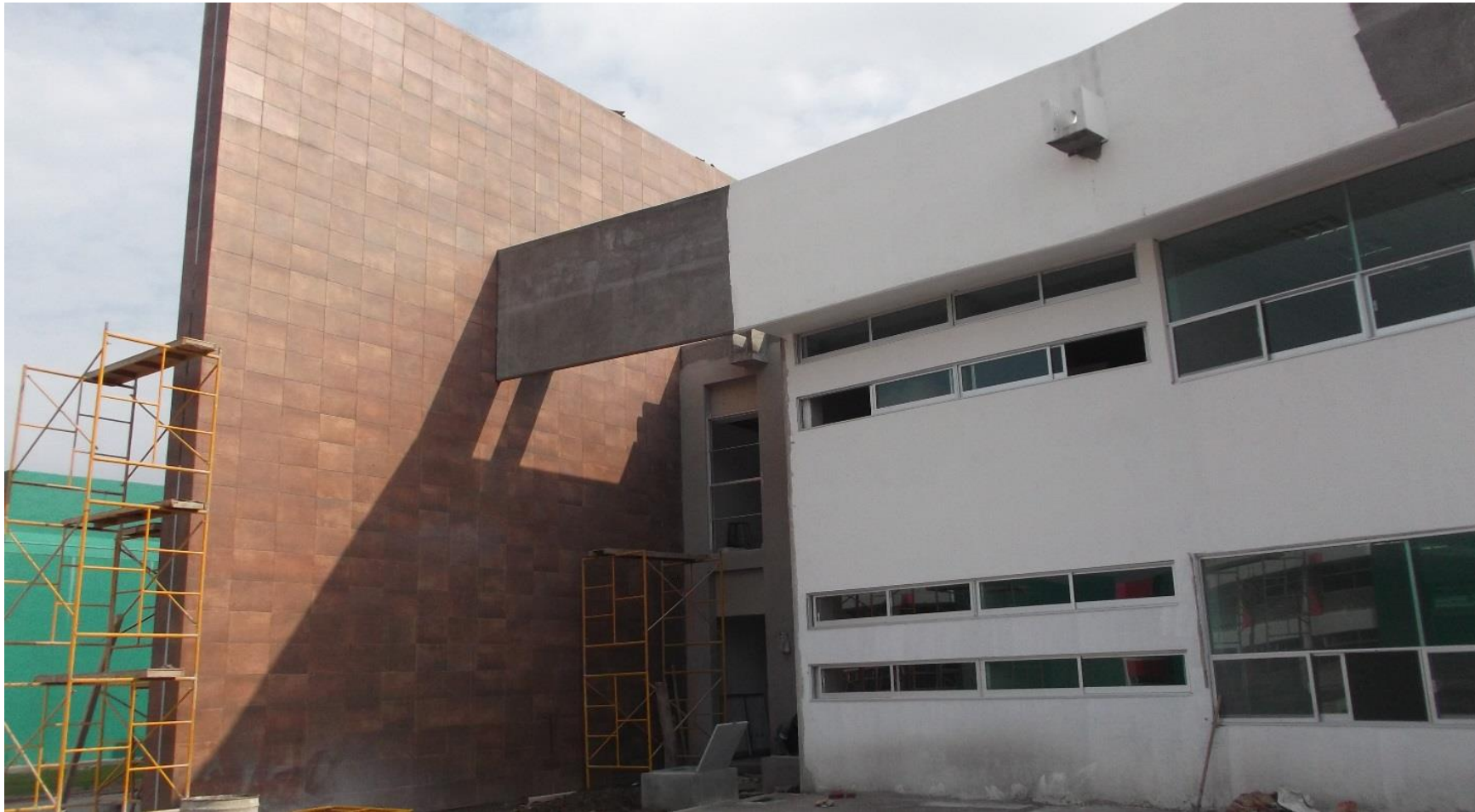
COLOCACION DE REVESTIMIENTO DE CERAMICA EN MUROS EXTERIORES.
