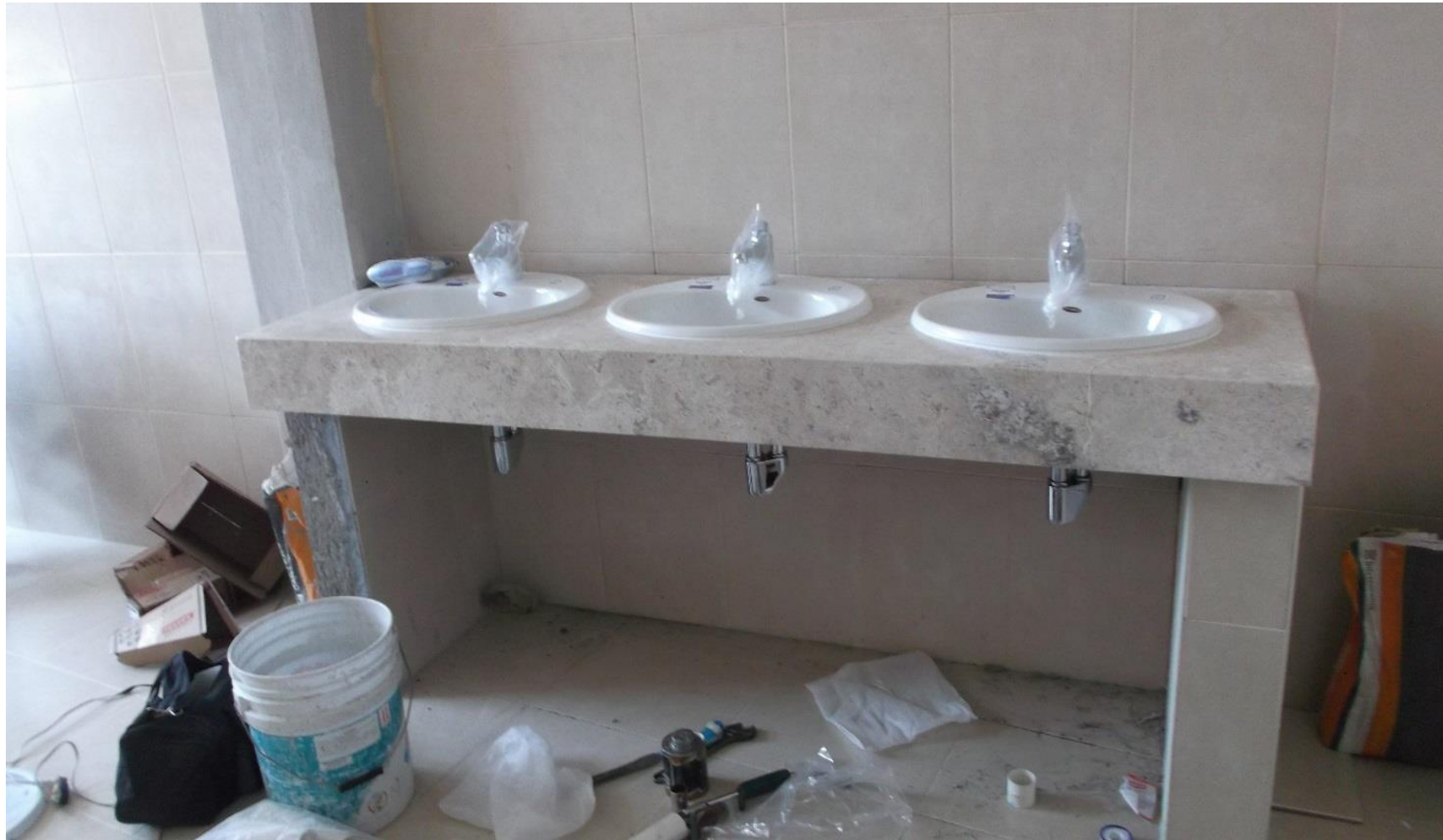
COLOCACION Y CONEXIÓN DE MUEBLES SANITARIOS (OVALINES).
