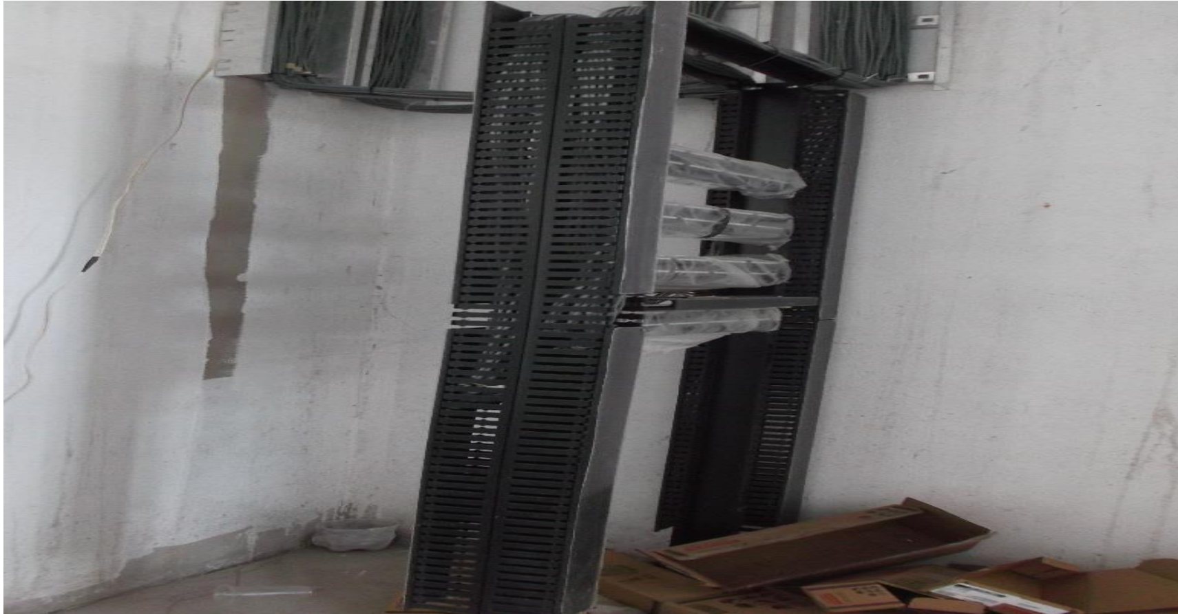
COLOCACION DE EQUIPO PARA VOZ Y DATOS (RACK)
