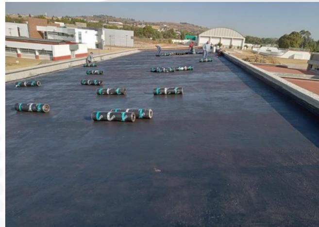
**ARMADO DE ACERO DE REFUERZO EN ZAPATAS AISLADAS, DADOS Y CIMBRADO EN ZAPATAS AISLADAS EN LAB. SISTEMAS AUTOMOTRICES Y LAB. POSGRADO (16 PZAS.), APLICACIÓN DE PRIMER ASFALTICO HIDROPRIMER EN LOSA DE AZOTEA NIVEL 6.61 M.**
