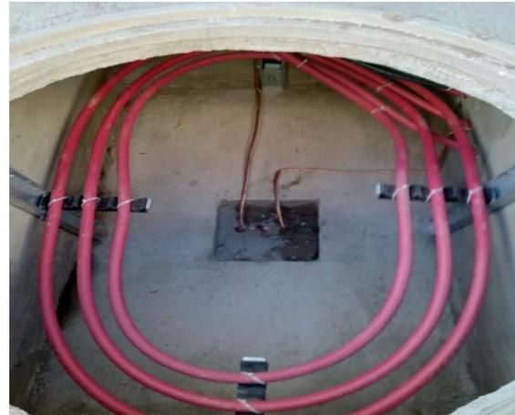
**SUMINISTRO E INSTALACIÓN DE HERRAJES EN EL TRANSFORMADOR DE 150 KVA. QUE ENERGIZARA AL EDIFICIO E
