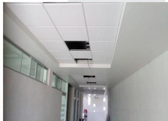
COLOCACIÓN DE PARASOL DE ALUMINIO EN ÁREA DE SALIDA DE EMERGENCIA FACHADA ORIENTE, SUMINISTRO Y COLOCACIÓN DE PANELES DE PLAFÓN ACÚSTICO EN PASILLO DE CIRCULACIÓN PLANTA BAJA
