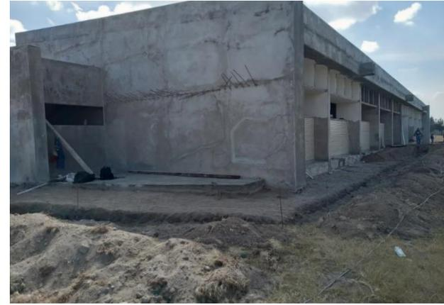
**EXCAVACIÓN Y TENDIDO DE PLANTILLA PARA LA CONSTRUCCIÓN DE CISTERNA CON CAPACIDAD DE 20 M3, DESPALME EN ZONA DE BANQUETAS Y EXCAVACIÓN PARA CONSTRUCCIÓN DE GUARNICIONES**
