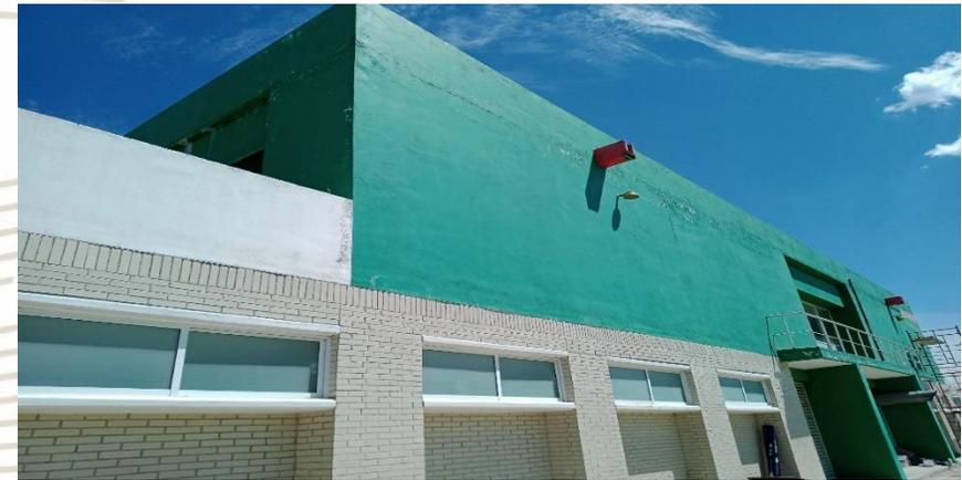
**SE EJECUTARON TRABAJOS DE RESANE EN MUROS DE GIMNASIO PARA EVITAR FILTRACIONES POR LLUVIA Y APLICACIÓN DE PINTURA**
