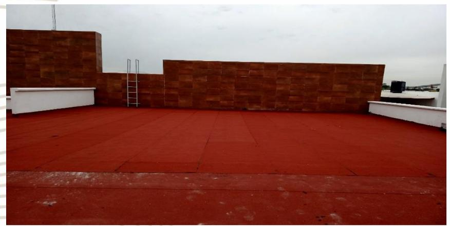
**TRABAJOS DE RETIRO DE MEMBRANA DE IMPERMEABILIZACIÓN EN MAL ESTADO, DEMOLICIÓN Y RETIRO DE ENLADRILLADO, APLICACIÓN DE PRIMER ASFALTICO Y COLOCACIÓN DE MEMBRANA DE IMPERMEABILIZANTE DE 4 MM DE ESPESOR EN EDIFICIO UD-5.**
