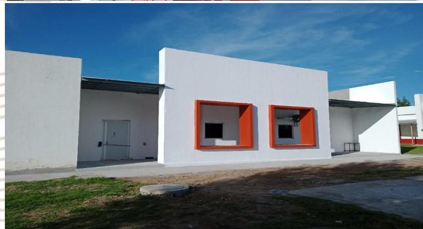
COLOCACIÓN DE ESTRUCTURA METÁLICA DE PTR 3"X1 ½" PARA RECIBIR CUBIERTA DE POLICARBONATO, REPARACIÓN DE FALSO PLAFÓN CON TABLA CEMENTO EN SANITARIOS DE CAFETERÍA PINTURA EN FACHADA POSTERIOR
