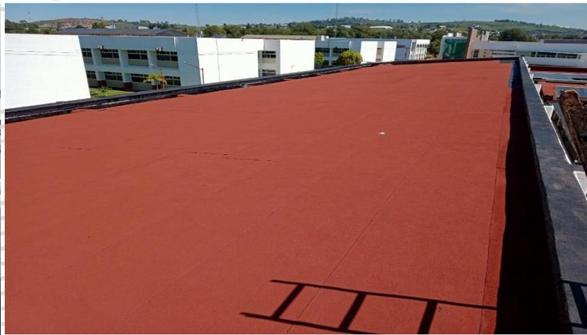
TRABAJOS DE RETIRO DE IMPERMEABILIZANTE EN MAL ESTADO Y TENDIDO DE RELLENO CON CACAHUITILLO PARA DAR PENDIENTE EN LOSA DE AZOTEA DE SALA DE ESPERA, APLICACIÓN DE PRIMER ASFALTICO PARA RECIBIR MEMBRANA DE IMPERMEABILIZANTE GRANULAR DE 4MM. DE ESPESOR EN EDIFICIO LT-2
