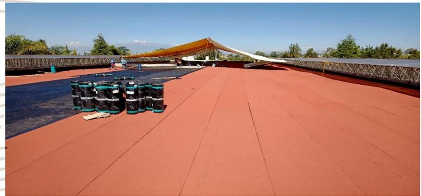
**TRABAJOS DE APLICACIÓN DE PRIMER ASFALTICO Y CONSTRUCCIÓN DE GÁRGOLA DE CONCRETO PARA DESALOJO DE AGUAS PLUVIALES EN SALA DE ESPERA, Y APLICACIÓN DE PRIMER ASFALTICO PARA RECIBIR MEMBRANA GRANULAR DE IMPERMEABILIZACIÓN DE LOSA DE AZOTEA EN EDIFICIO UD-1**
