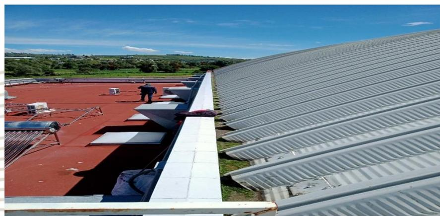
**TRABAJOS DE RETIRO DE MEMBRANA IMPERMEABILIZANTE EN LOSA DE AZOTEA DE EDIFICIO LT-2, TRABAJOS DE DEMOLICIÓN Y RETIRO DE LOSETA EN LOSA DE AZOTEA DE EDIFICIOS UD.1 Y LT.1 Y CANALON PARA DESALOJO DE AGUAS PLUVIALES CON SECCION HIDRAULICA INSUFICIENTE CUBIERTA DEL GIMNASIO.**
