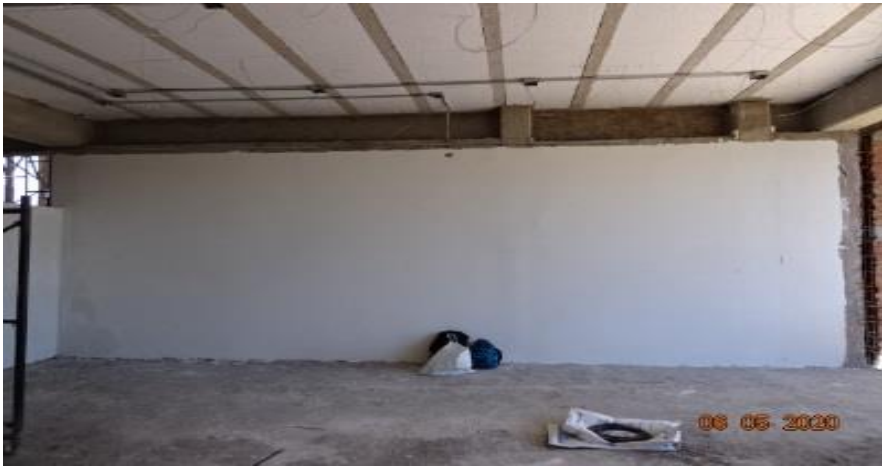
APLICACION DE APLANADO FINO EN MUROS INTERIORES E INICIO DE COLOCACION DE LOSETA DE CERAMICA EN PISOS INTERIORES
