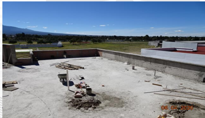
CONSTRUCCION DE PRETILES DE CONCRETO Y REPIZON EN LOSA DE AZOTEA (NIVEL 7.80 M)
