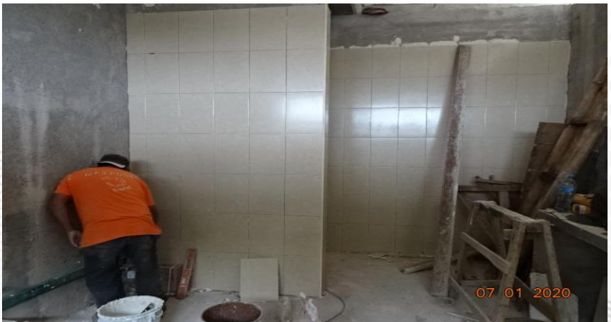
SUMINISTRO Y COLOCACION DE LAMBRIN DE CERAMICA EN SANITARIOS HOMBRES Y MUJERES PLANTA BAJA Y PLANTA ALTA, SUMINISTRO, COLOCACION Y PROCESO DE SOLDADURA DE ESTRUCTURA METALICA EN FACHADAS INTEGRALES NORTE Y SUR.
