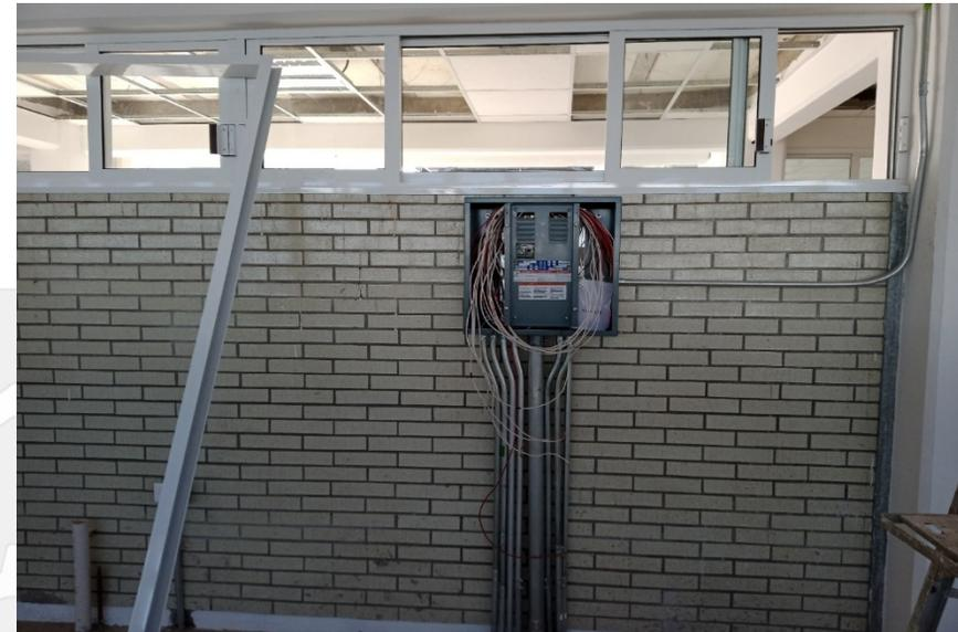
**SUMINISTRO Y COLOCACIÓN DE TABLERO PRINCIPAL I-LINE CON INTERRUPTOR PRINCIPAL DE 600 A. Y TABLEROS SECUNDARIOS NQDD 100A- 240V, 12 CIRCUITOS EN LABORATORIO DE SISTEMAS AUTOMOTRICES**
