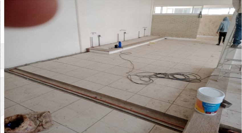
**INSTALACION DE DUCTOS EN TRINCHERAS POR PISO PARA LINEAS DE GAS Y AIRE COMPRIMIDO EN AREA DE PROYECTOS DE INVESTIGACION**
