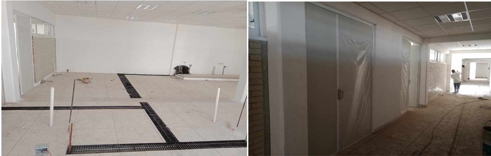
**SUMINISTRO Y COLOCACION DE REJILLA IRVING EN TRINCHERAS DE PISO EN AREA DE PROYECTOS DE INVESTIGACION SUMINISTRO Y COLOCACION DE PUERTAS DE CONTROL INTERNAS A BASE DE PANELES DE 32MM. DE ESPESOR ACABADO FINAL ESMALTE CURADO AL HORNO**
