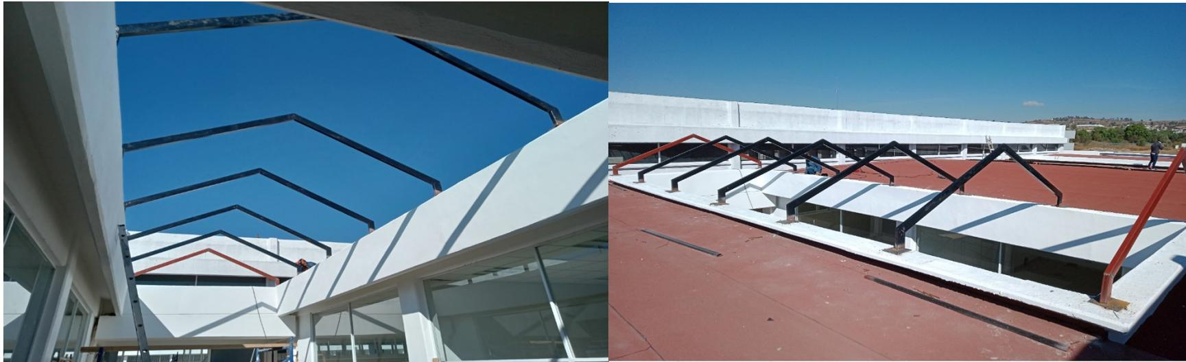
FABRICACION DE ESTRUCTURA METALICA A BASE DE PERFILES "R400" CAL. 18 Y "R200" PARA DOMO EN PATIO INTERIOR DEL EDIFICIO, EJES D'-F' /15-16
