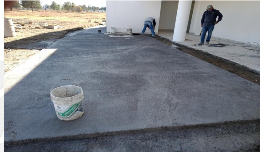
**CONSTRUCCION DE BANQUETAS CON CONCRETO PREMEZCLADO F' C=150 KG/CM2 EN FACHADA NORTE**
