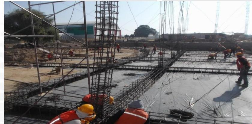
**SUMINISTRO Y TENDIDO DE PLÁSTICO CAL. RS-600 COLOR NEGRO EN CONTRATABES Y LOSA DE CIMENTACIÓN PARA RECIBIR CONCRETO PREMEZCLADO Y SUMINISTRO HABILITADO Y COLOCADO DE ACERO DE REFUERZO DISTINTOS DIÁMETROS EN CONTRATABES Y COLUMNAS**
