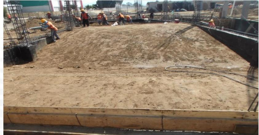
**SUMINISTRO Y APLICACIÓN DE IMPERMEABILIZANTE FESTER MICROLASTIC EN CIMENTACIÓN, RELLENO COMPACTADO AL 95% CON MATERIAL INERTE EN INTERIORES.**
