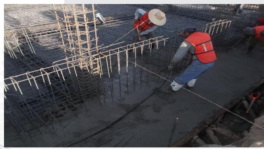
**CIMBRADO DE FRONTERAS Y COLOCACIÓN DE ACERO DE REFUERZO DISTINTOS DIÁMETROS EN LOSA DE CIMENTACIÓN Y SUMINISTRO DE**
