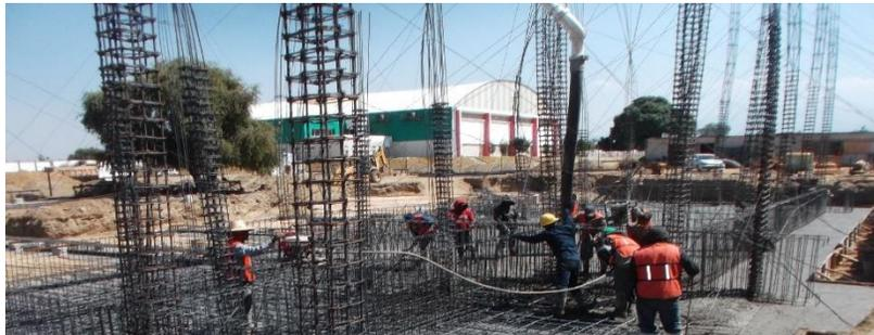
**SUMINISTRO DE CONCRETO PREMEZCLADO F' C= 250 KG/CM2 PARA PRIMERA ETAPA DE COLADO DE CIMENTACIÓN Y CURADO A BASE DE AGUA EN LA SUPERFICIE DEL CONCRETO PREMEZCLADO DEPOSITADO, CIMBRA EN COLUMNAS COMO PREPARACIÓN PARA VACIADO DE CONCRETO.**
