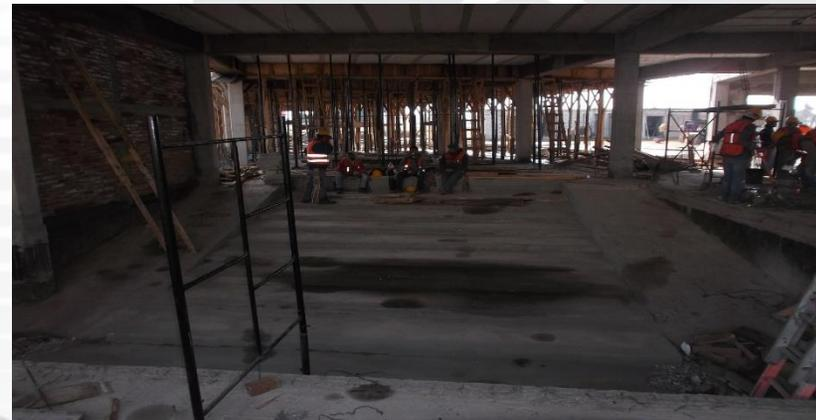
**ARMADO DE ACERO Y COLADDO DE MUROS DE CISTERNA, FORJADO DE ESCALONES EN SALA AUDIOVISUAL PARA ISOPTICA**
