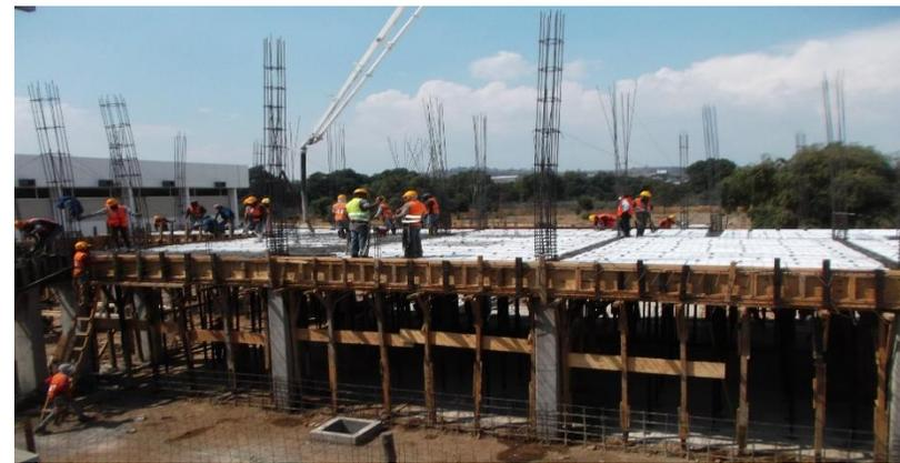
**CIMBRADO DE ENTREPISO COLOCACIÓN DE VIGUETAS PRENSADAS, BOVEDILLAS DE POLIESTIRENO Y SUMINISTRO DE CONCRETO PREMEZCLADO EN LOSA DE ENTREPISO**
